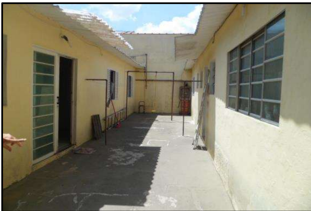
FOTO 14 – Vista do acesso às edículas.
