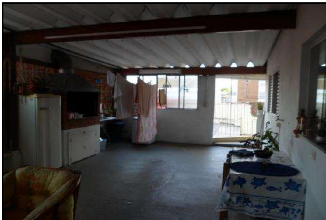
FOTO 12 – Vista geral da área coberta.
