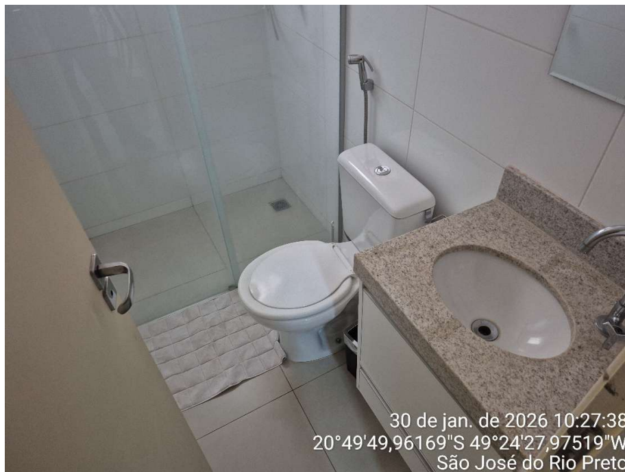
FOTO 08: BANHEIRO SOCIAL - VISTORIA
