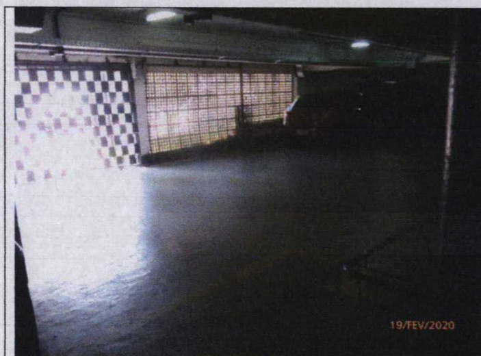
Foto n.º 17. Vista do portão de acesso ao 2º subsolo.
