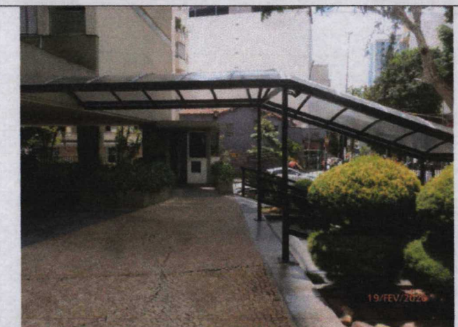
Foto n.º 5. Vista do hall da entrada social do pavimento térreo.
