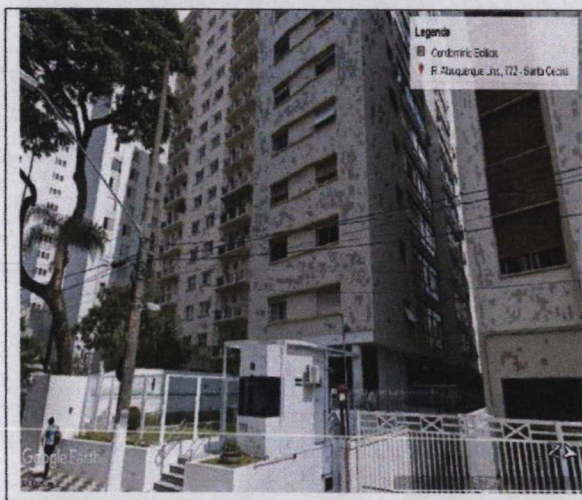
Foto n.º 2. Comparativo n.º 3, localizado na Rua Dr. Albuquerque Lins, 772.
