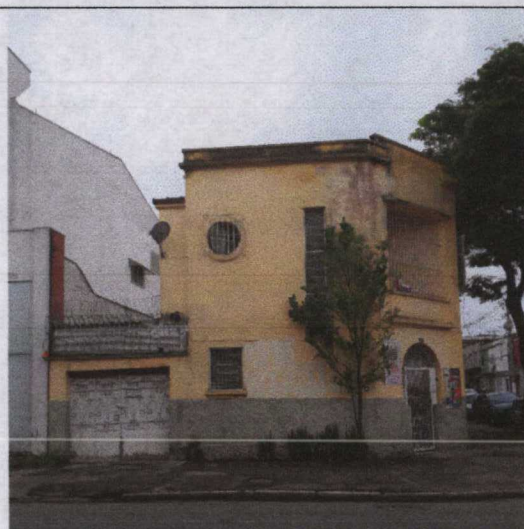
Foto n.º 5. Vista da fachada do segundo conjunto tomada da Rua Anhaia, no sentido da Rua Jaraguá.
