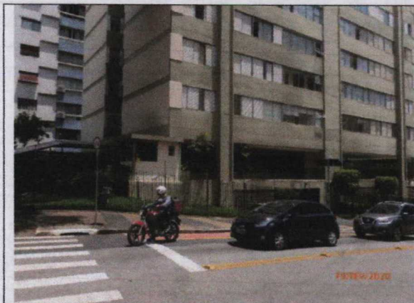
Foto n.º 1. Comparativos n.ºs 1 e 2, Edifício Praia de Itaparica, localizado na Rua Dr. Albuquerque Lins, n.º 724.
