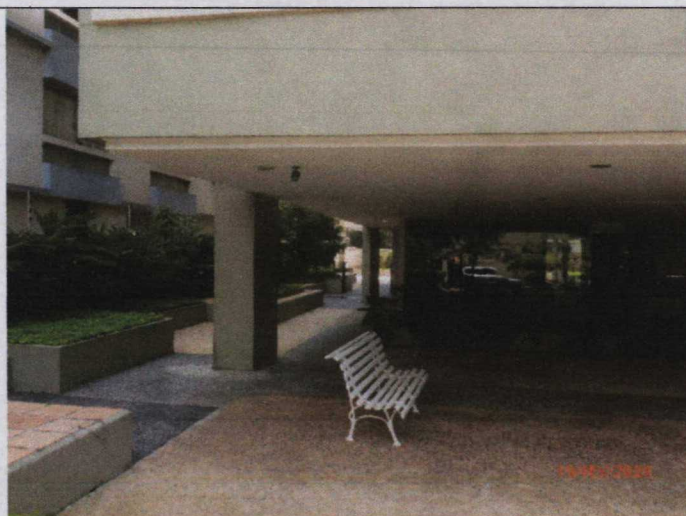
Foto n.º 8. Vista do corredor lateral do lado esquerdo do térreo, tomada da frente para os fundos do condomínio.
