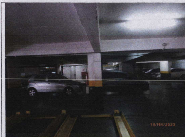
Foto n.º 15. Vista geral do 1º subsolo.
