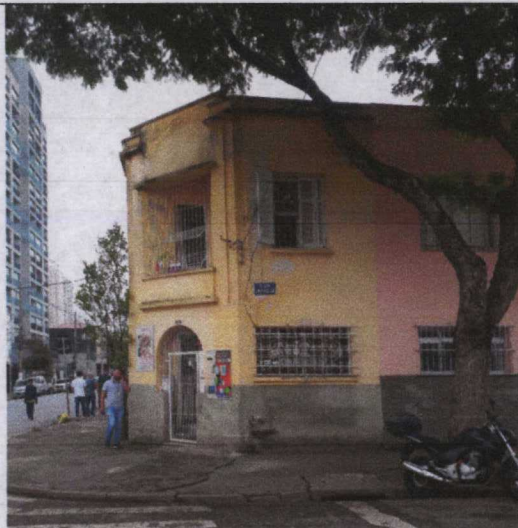
Foto n.º 4. Vista da fachada do segundo conjunto tomada da Rua Jaraguá, sentido da Rua Anhaia.
