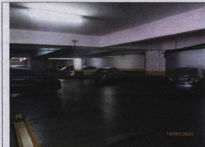
Foto n.º 16. Outra vista geral do 1º subsolo.
