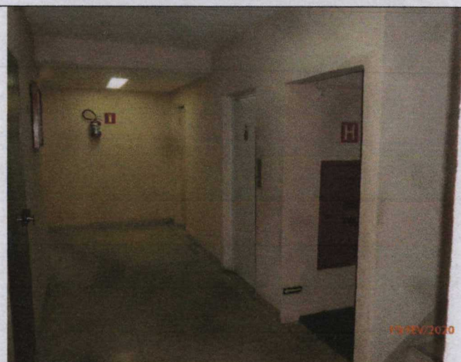
Foto n.º 11. Vista do hall de serviço e escadaria de acesso aos pavimentos superiores e do pavimento subsolo.
