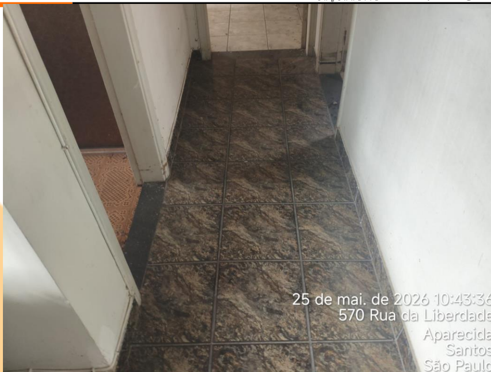
Vista corredor de acesso aos quartos e banheiro social
