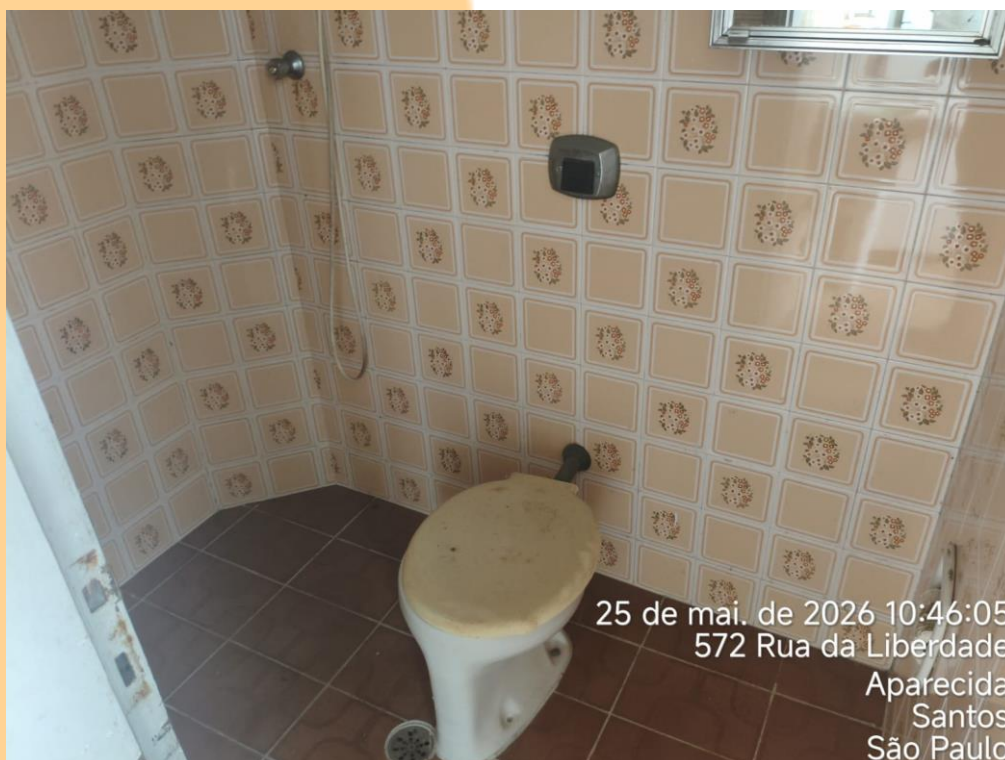
Banheiro de empregada
