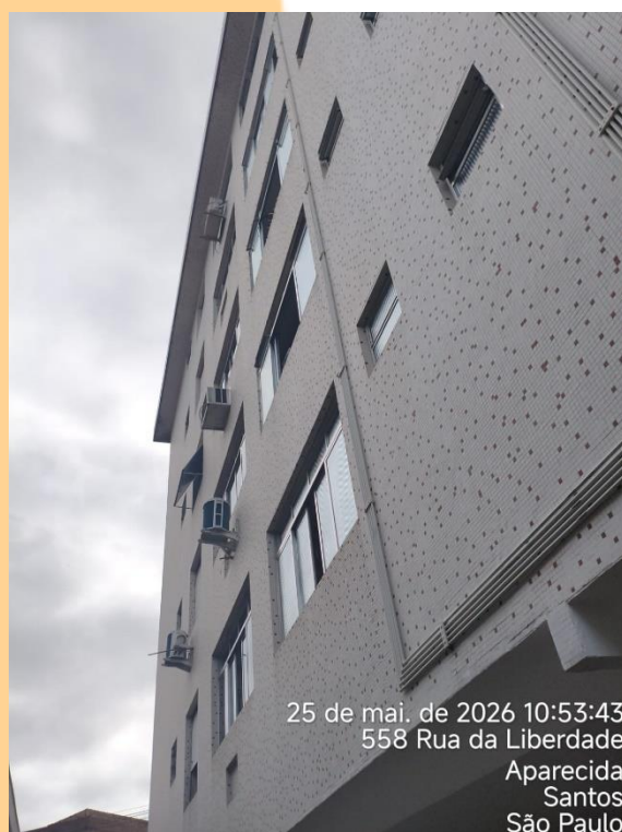
Vista Fachada – Pastilhas em bom estado de conservação
