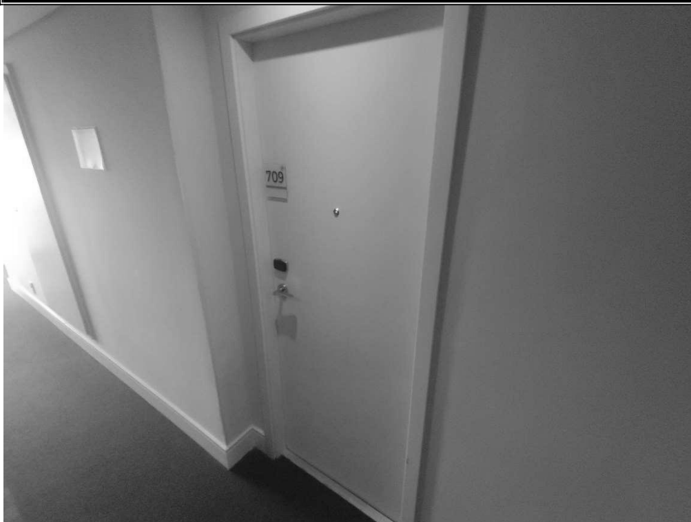
Foto 1 - Entrada do imóvel
