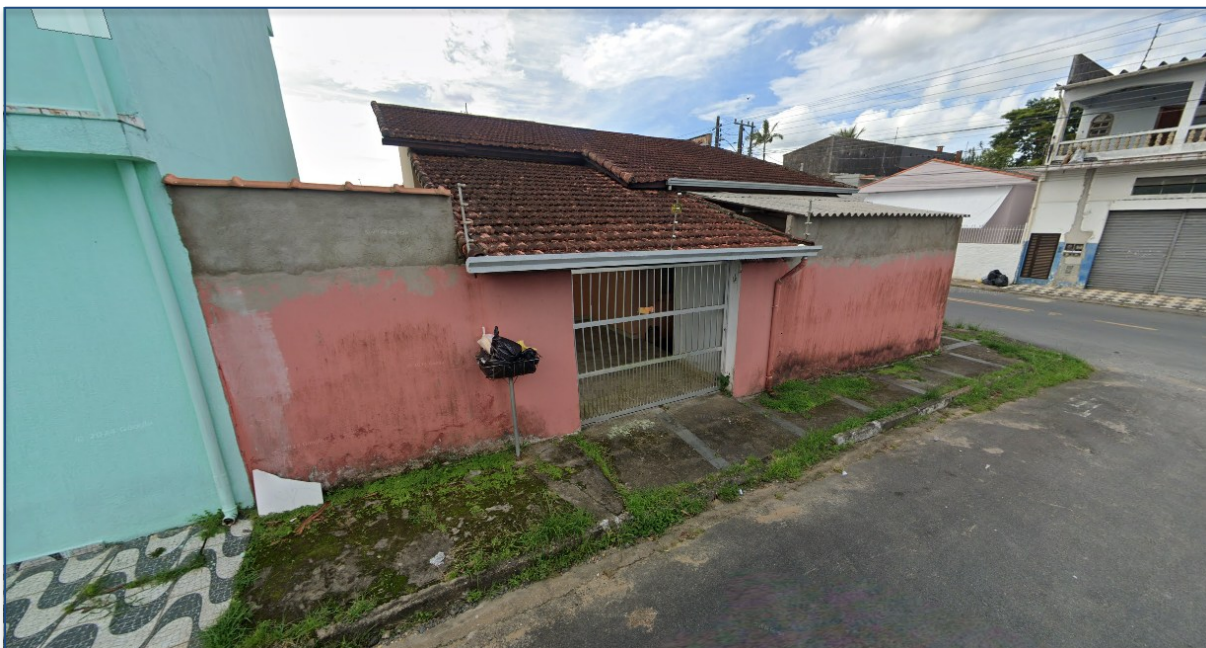
Acesso pela Rua Aracajú Fonte: Google Street View
