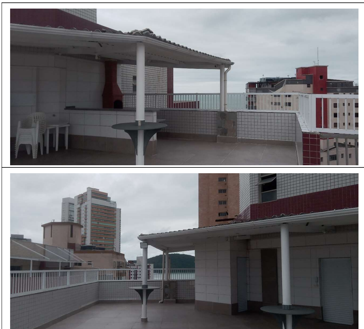
Fotos 3/8 – vista da área comum do Condomínio Edifício Praia de Icarai
