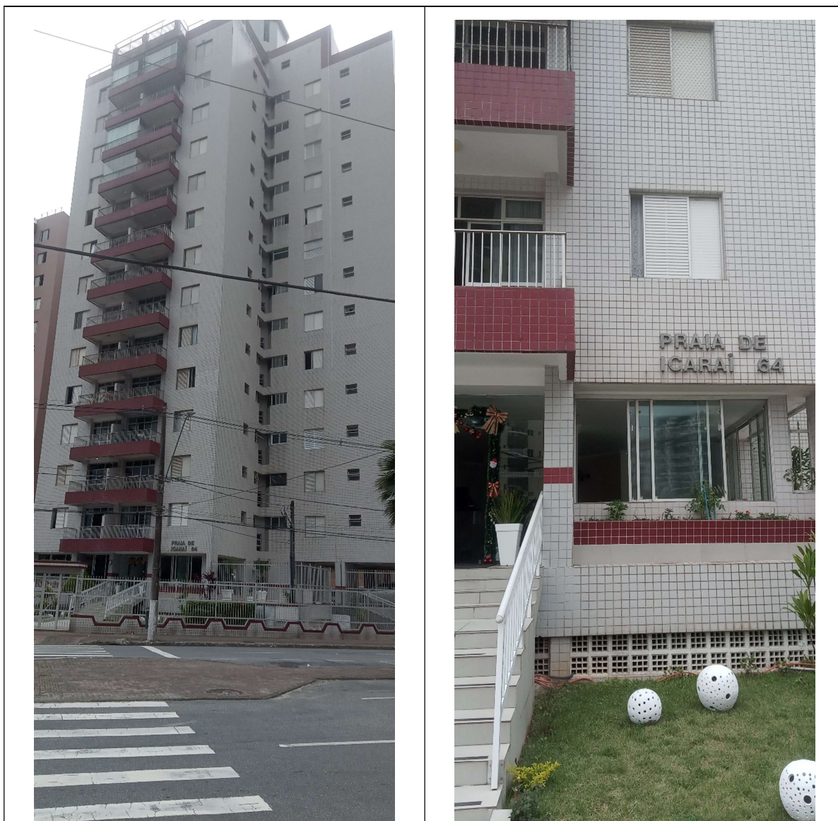
Fotos 1/2 – vista da fachada do Condomínio Edifício Praia de Icarai
