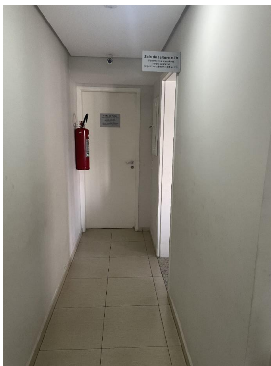
Foto nº 23- Vista parcial do corredor de acesso às salas
