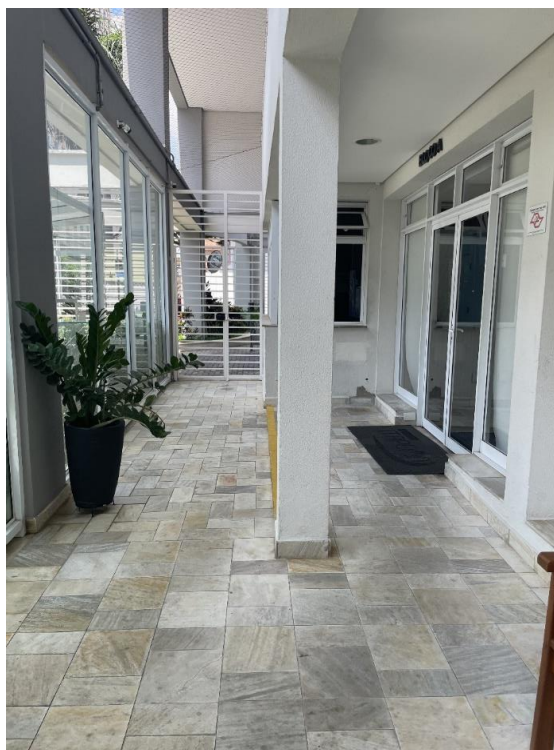
Foto nº 5- Vista parcial de área social externa e da porta de entrada
