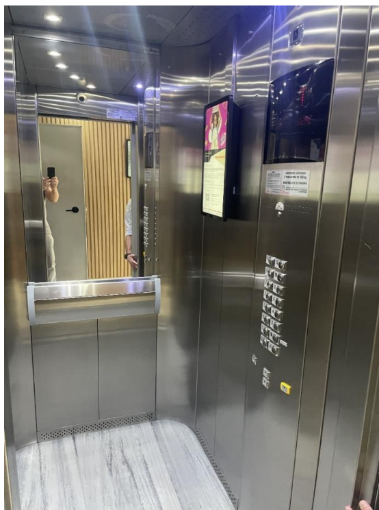
Foto nº 10- Detalhe do interior do elevador
