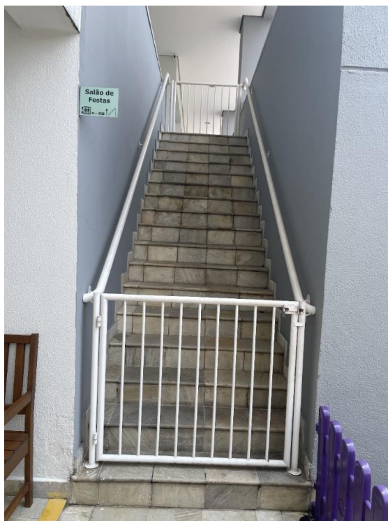
Foto nº 24- Vista parcial da escada externa de acesso ao salão de festas
