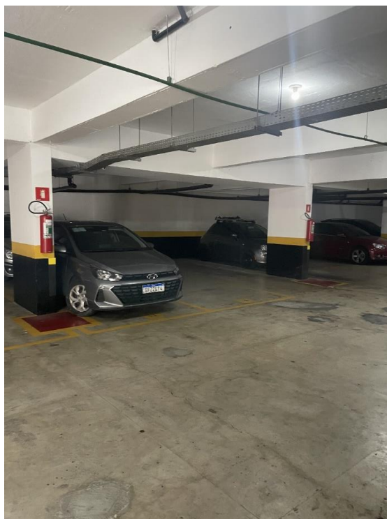
Foto nº 12- Vista parcial de garagem
