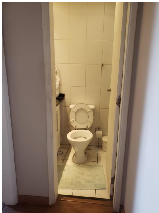
Foto nº 42- Vista parcial do outro banheiro
