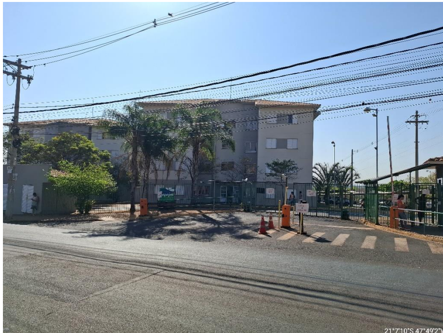
Foto 4 - Outra vista da fachada do condomínio
