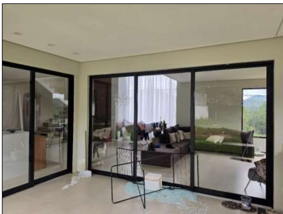
Aspectos da edificação – pavimento térreo.
