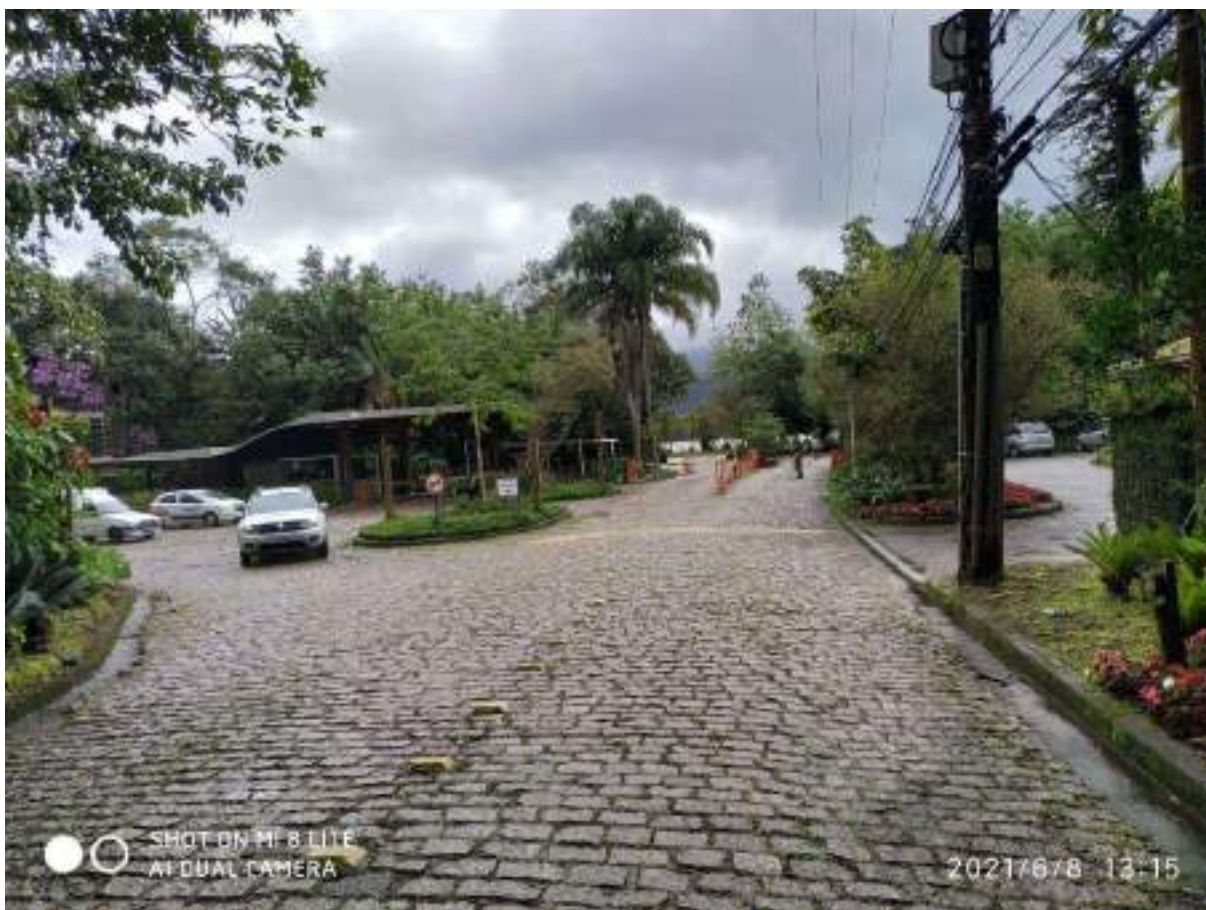
Foto 05: Vista de outro ângulo da Portaria de Entrada do Loteamento Iporanga . Ao fundo vemos a Estrada Guarujá-Bertioga.
