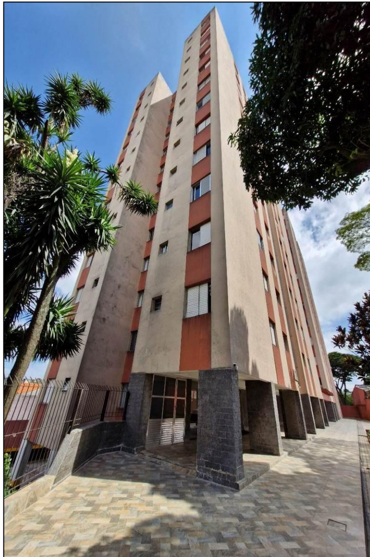
Foto nº 5: Detalhe da fachada do Edifício Roberta.
