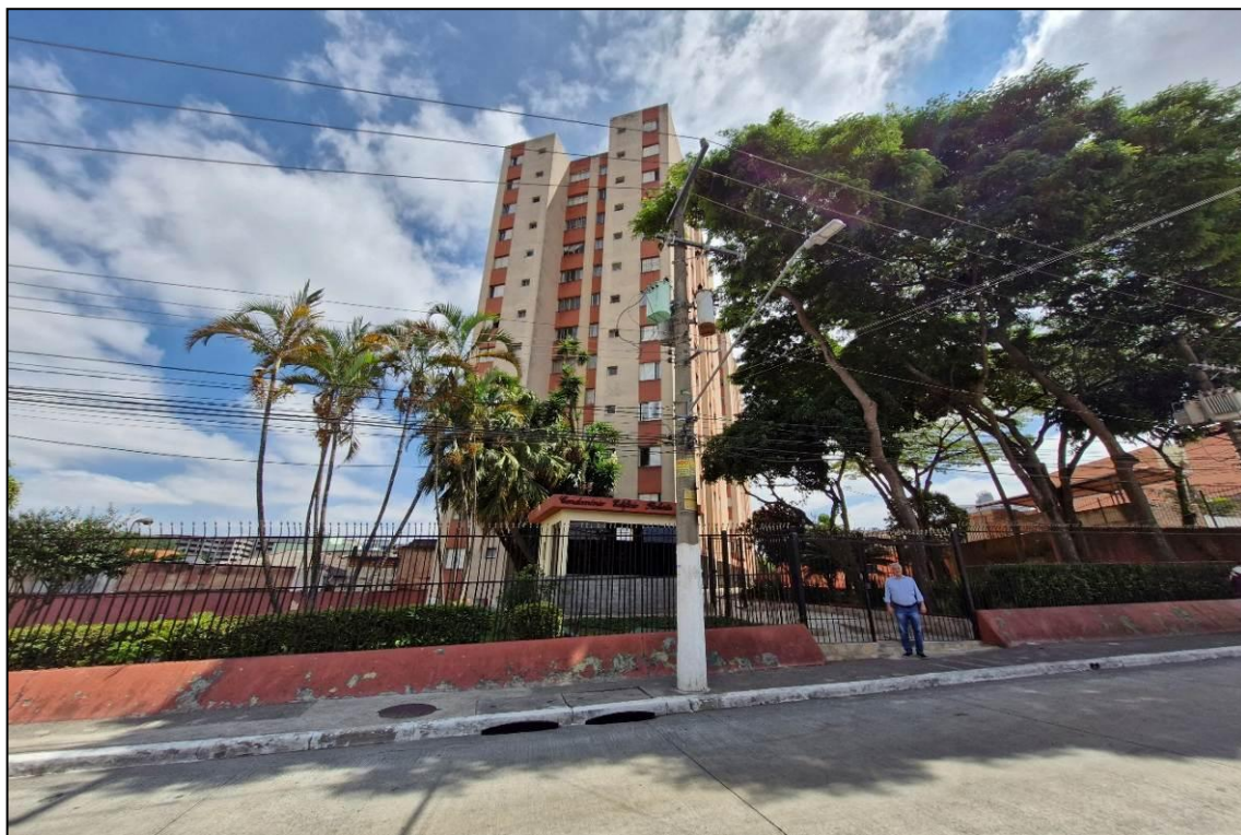
Foto nº 3: Vista da fachada do Edifício Roberta sob nº 152 da Rua Benedito Fernandes.
