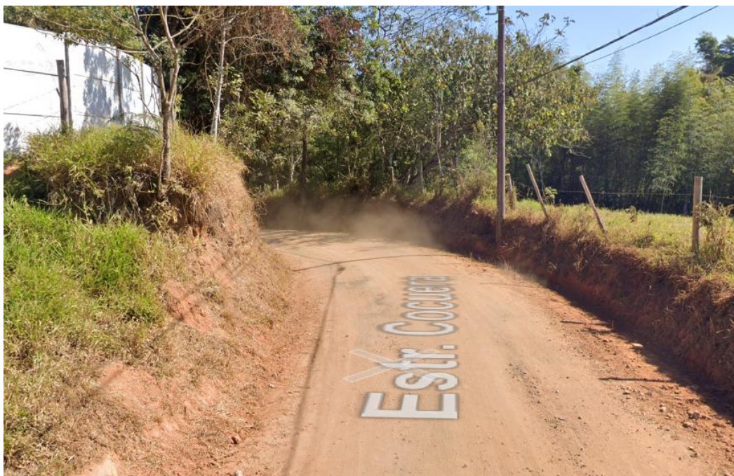
DETALHES DA VIA DE ACESSO AO IMÓVEL
