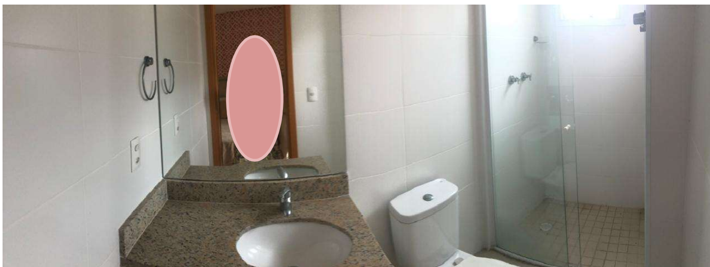
Figura 57 – Vista banheiro suíte secundária.
