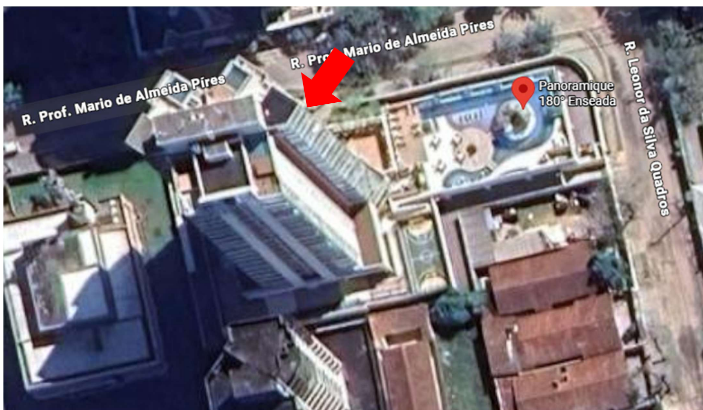
Figura 3 –Imagem mais aproximada de satélite da área e do entorno do edifício avaliado .Revelando implantação do condomínio e volumetrias. Fonte: Google Maps.
