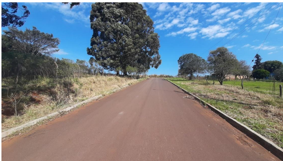
Rua Rio Negro em frente ao Imóvel, Vista para Oeste.
