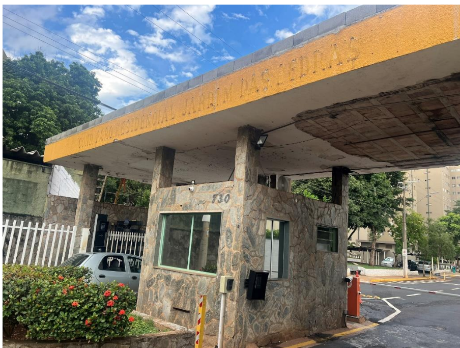
Foto 2 - Vista da identificação do Condomínio
