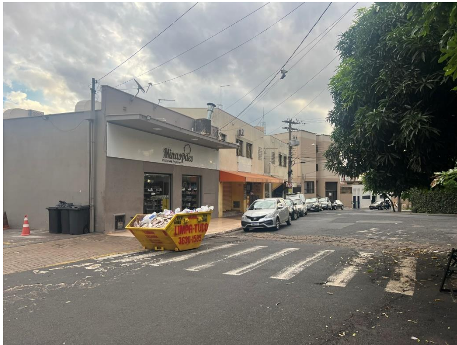
Foto 3 - Vista do logradouro
