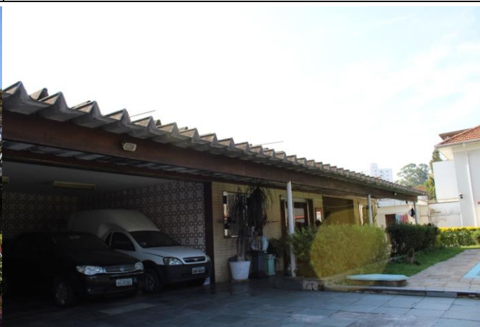
Fachada da edícula
