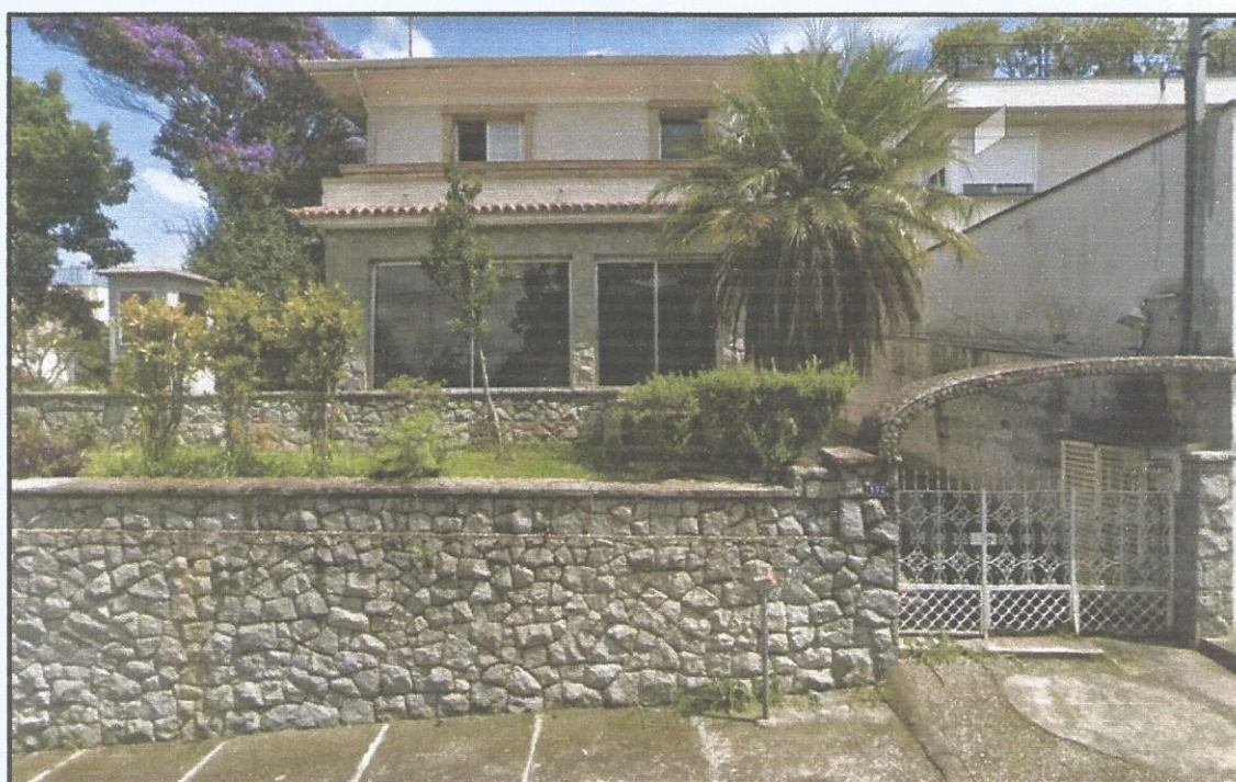
# - FACHADA IMÓVEL AVALIANDO
