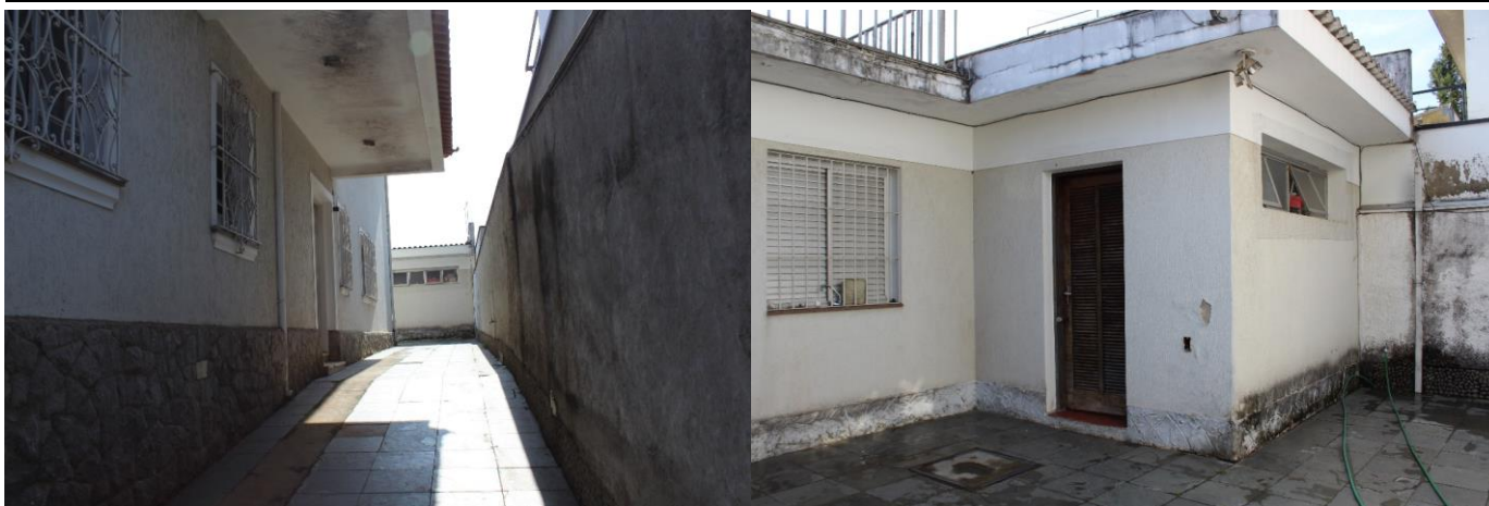
Acesso a garagem
