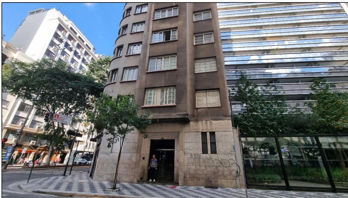
Imagem 5: Fachada do Edifício Josephina Paula Leite Nogueira Ferraz.
