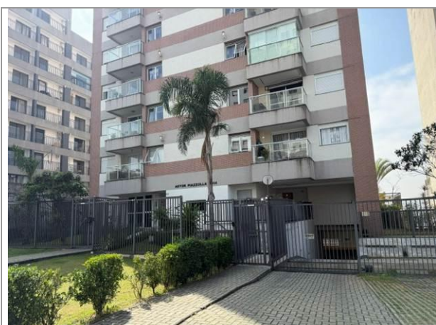
Frente – acesso veículos
