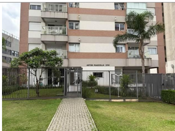
Frente – acesso pedestres
