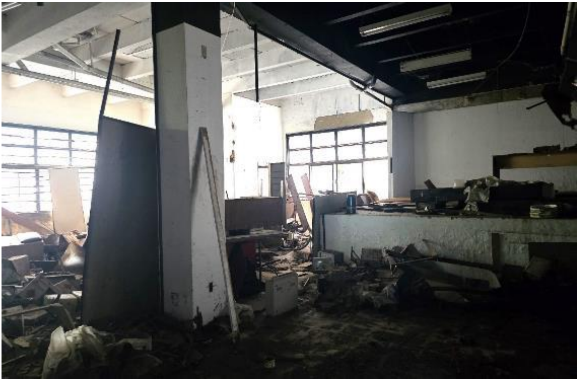
Foto 32 – Interior da loja/subsolo
