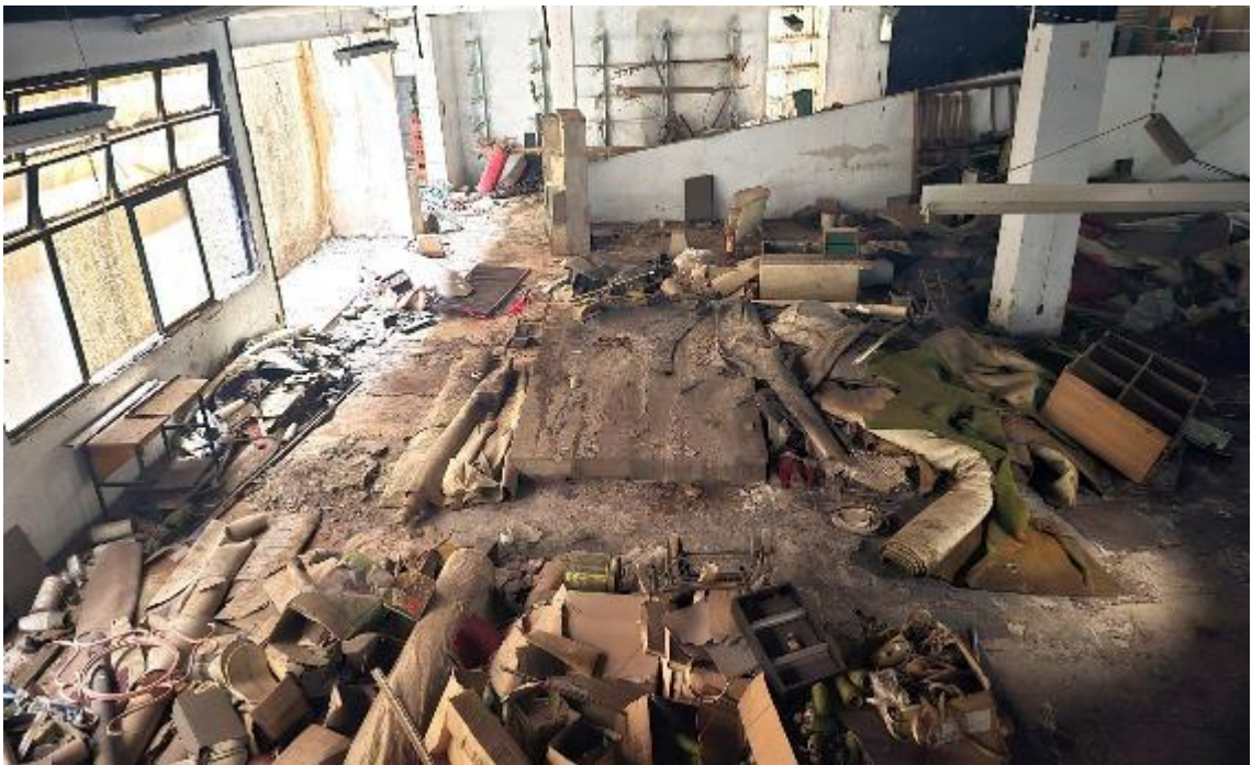
Foto 14 – Interior da loja/subsolo
