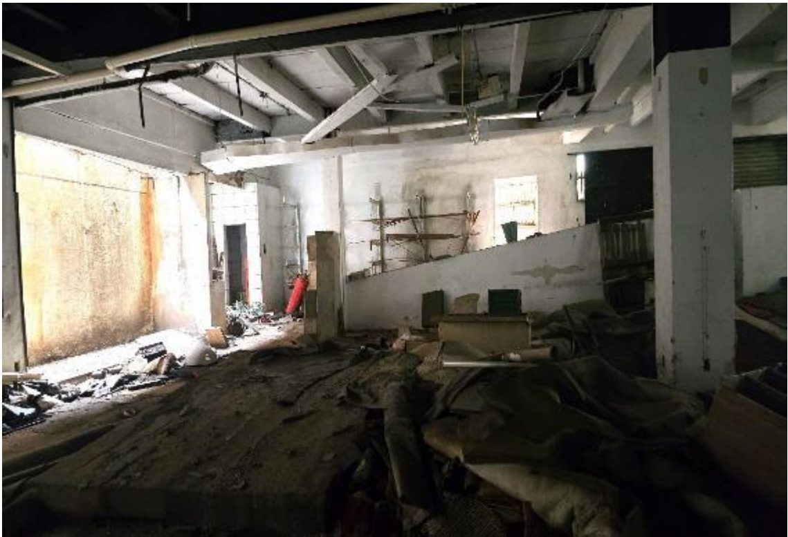
Foto 23 – Interior da loja/subsolo
