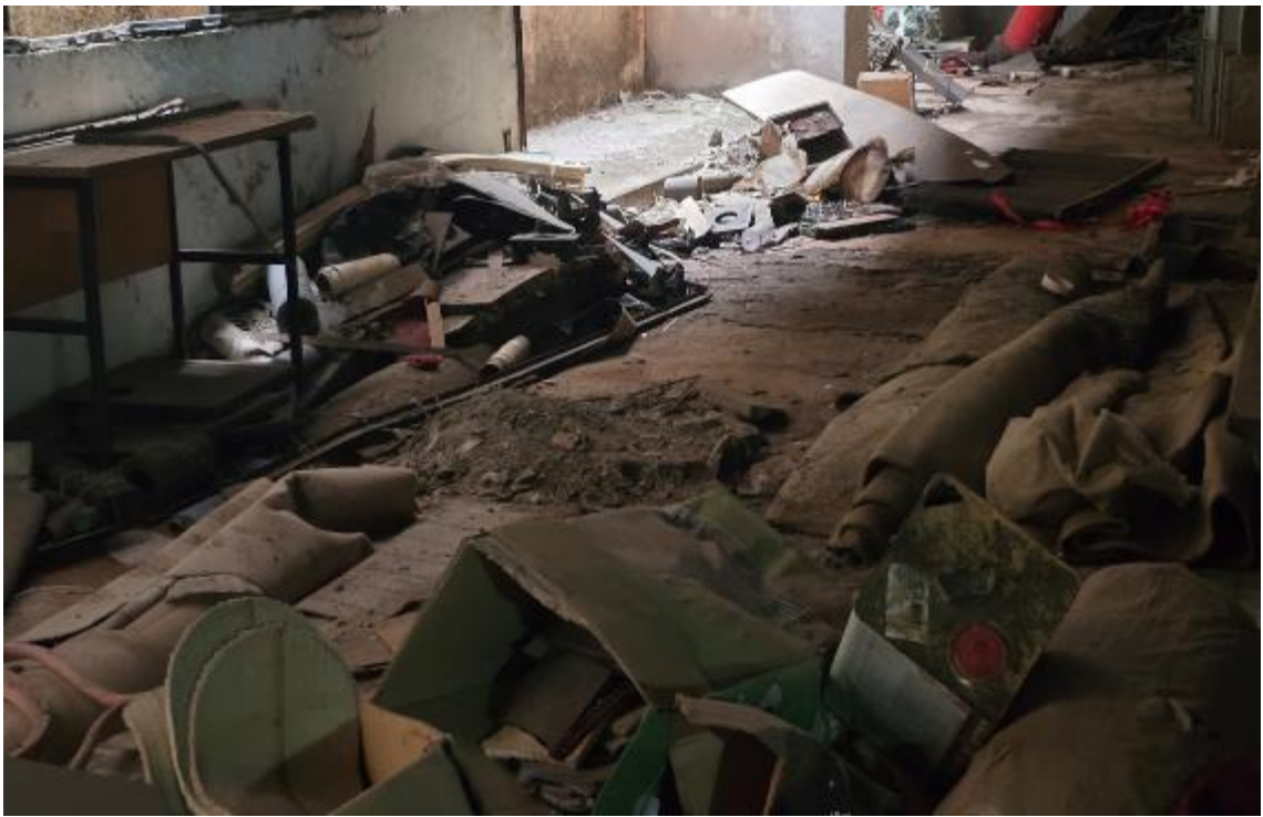
Foto 37 – Interior da loja/subsolo
