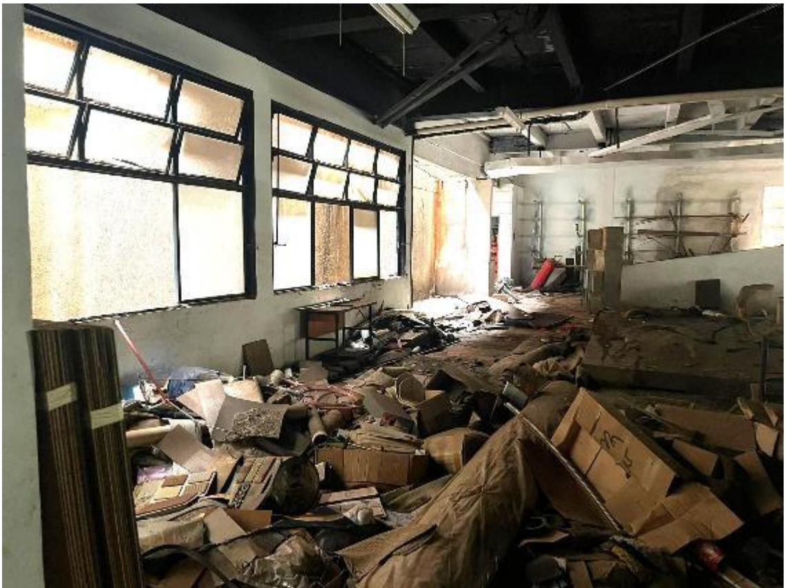
Foto 47 – Interior da loja/subsolo
