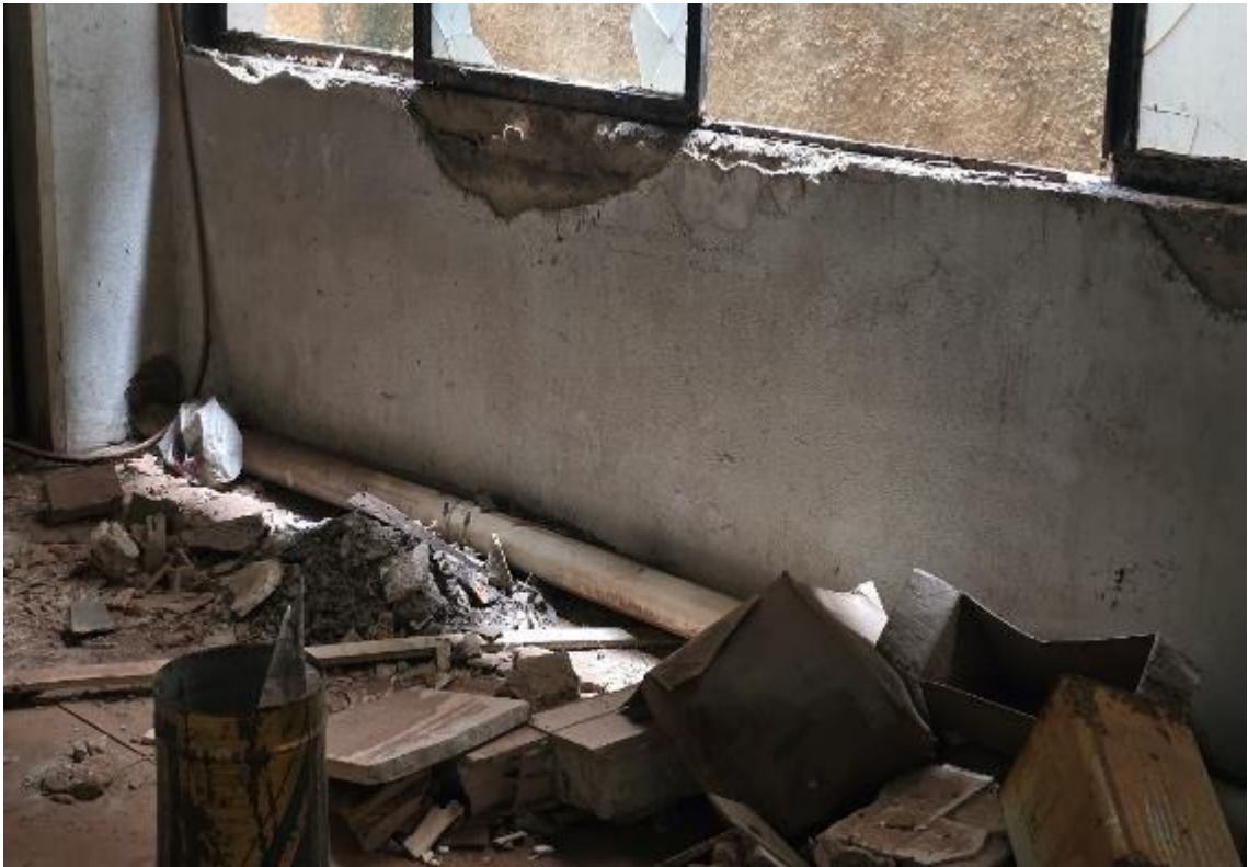
Foto 42 – Interior da loja/subsolo
