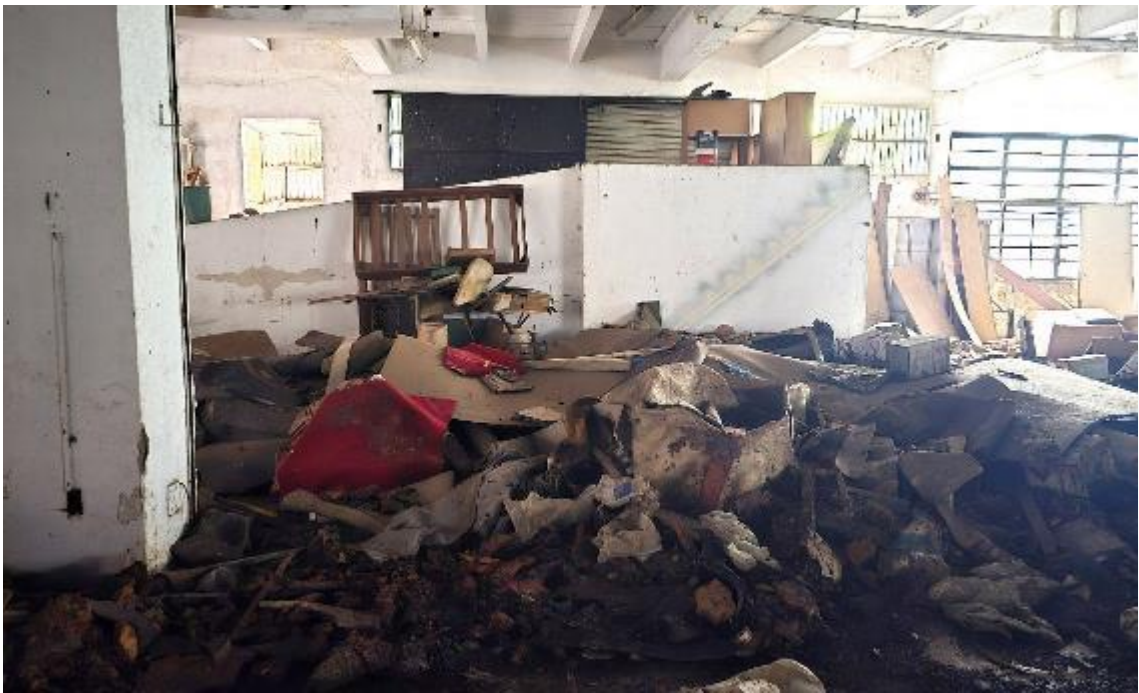
Foto 24 – Interior da loja/subsolo
