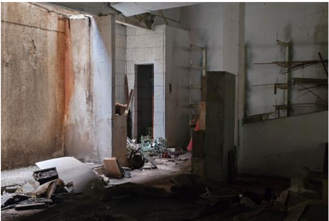
Foto 36 – Interior da loja/subsolo
