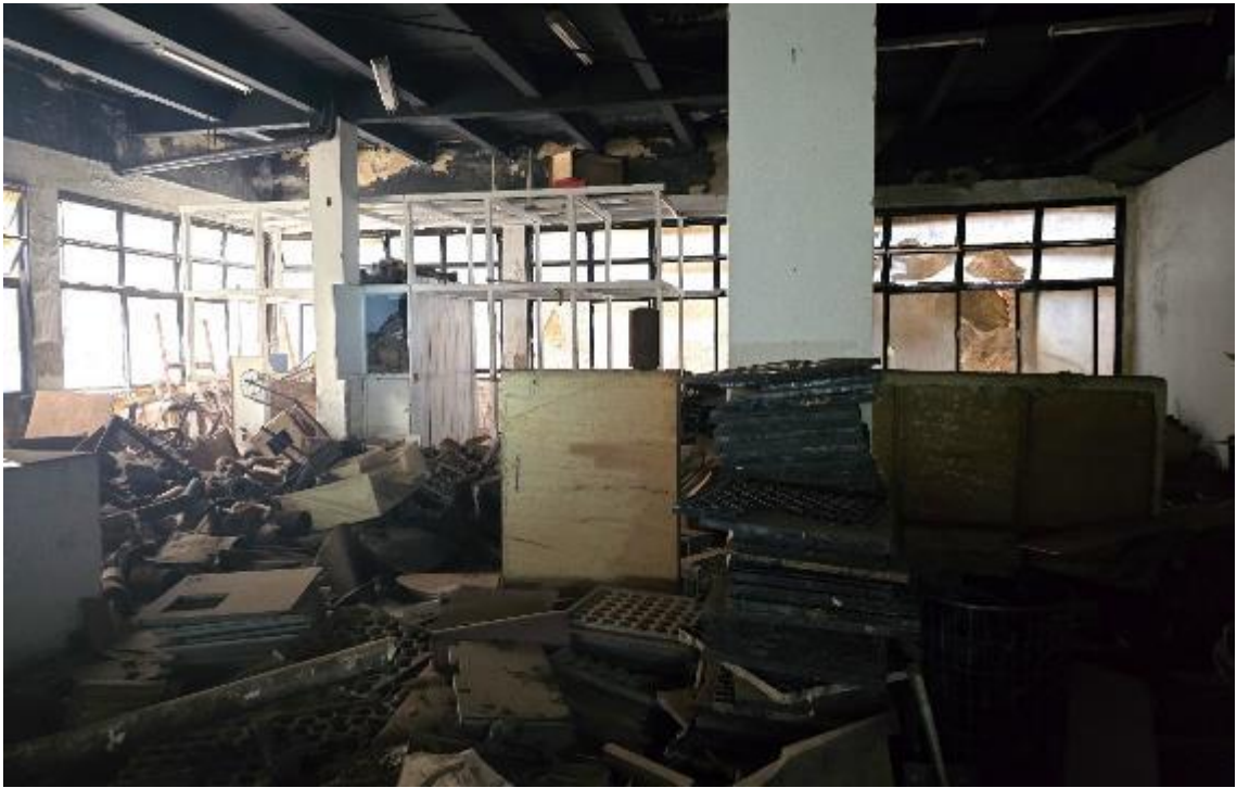
Foto 39 – Interior da loja/subsolo
