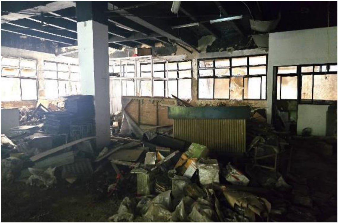
Foto 27 – Interior da loja/subsolo
