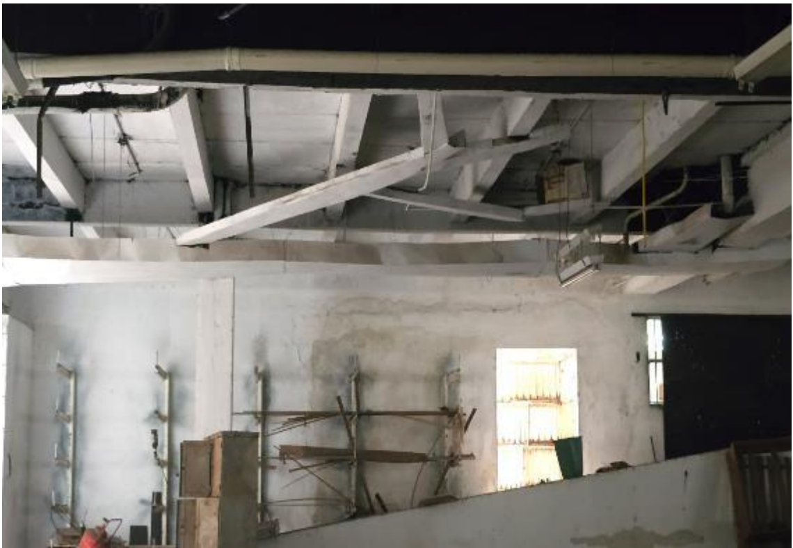
Foto 40 – Interior da loja/subsolo
