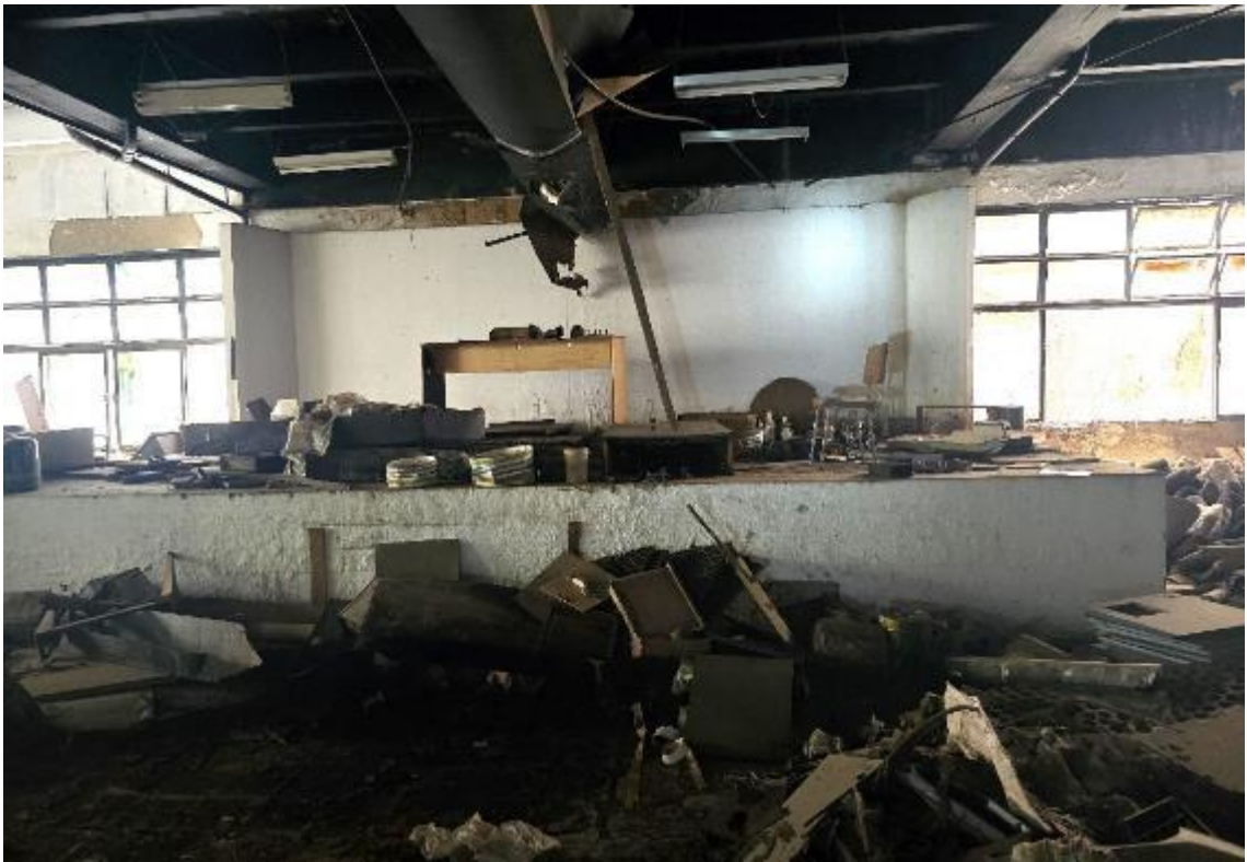
Foto 38 – Interior da loja/subsolo
