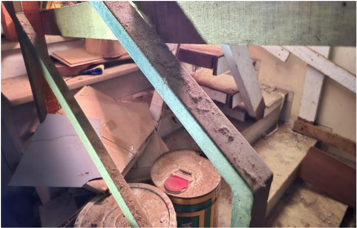
Foto 9 – Escada que dá acesso a loja no subsolo
