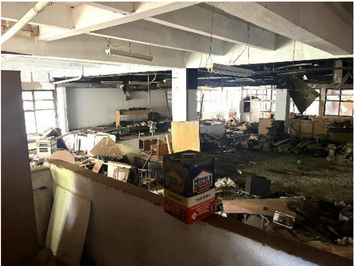
Foto 49 – Interior da loja/subsolo
