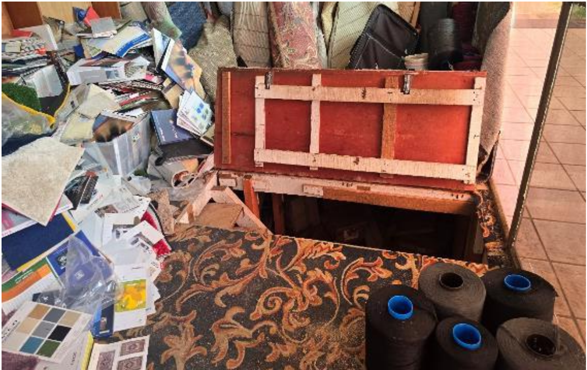
Foto 7 – Porta aberta no assoalho da recepção que dá acesso a escada para a LOJA no subsolo
