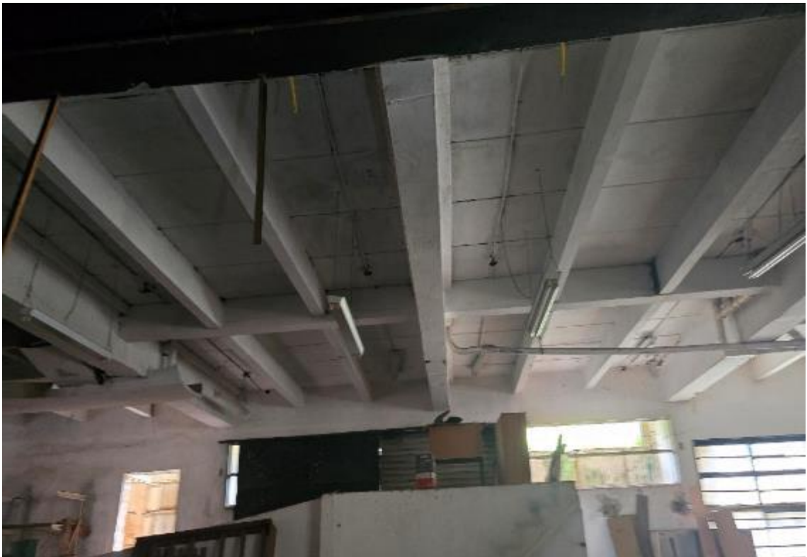
Foto 34 – Interior da loja/subsolo
