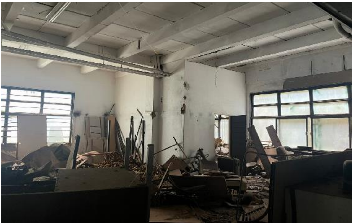
Foto 48 – Interior da loja/subsolo
