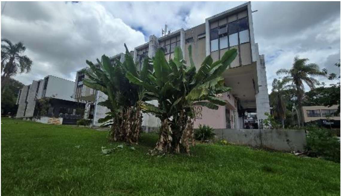
Foto 60 – Fachada da parte de trás do prédio
