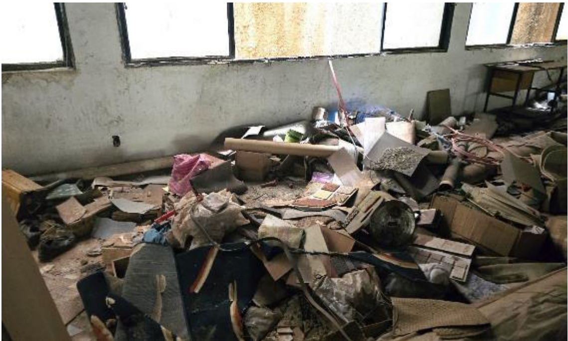
Foto 43 – Interior da loja/subsolo
