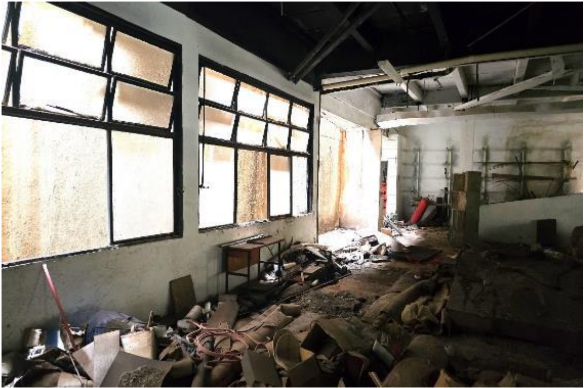
Foto 19 – Interior da loja/subsolo
