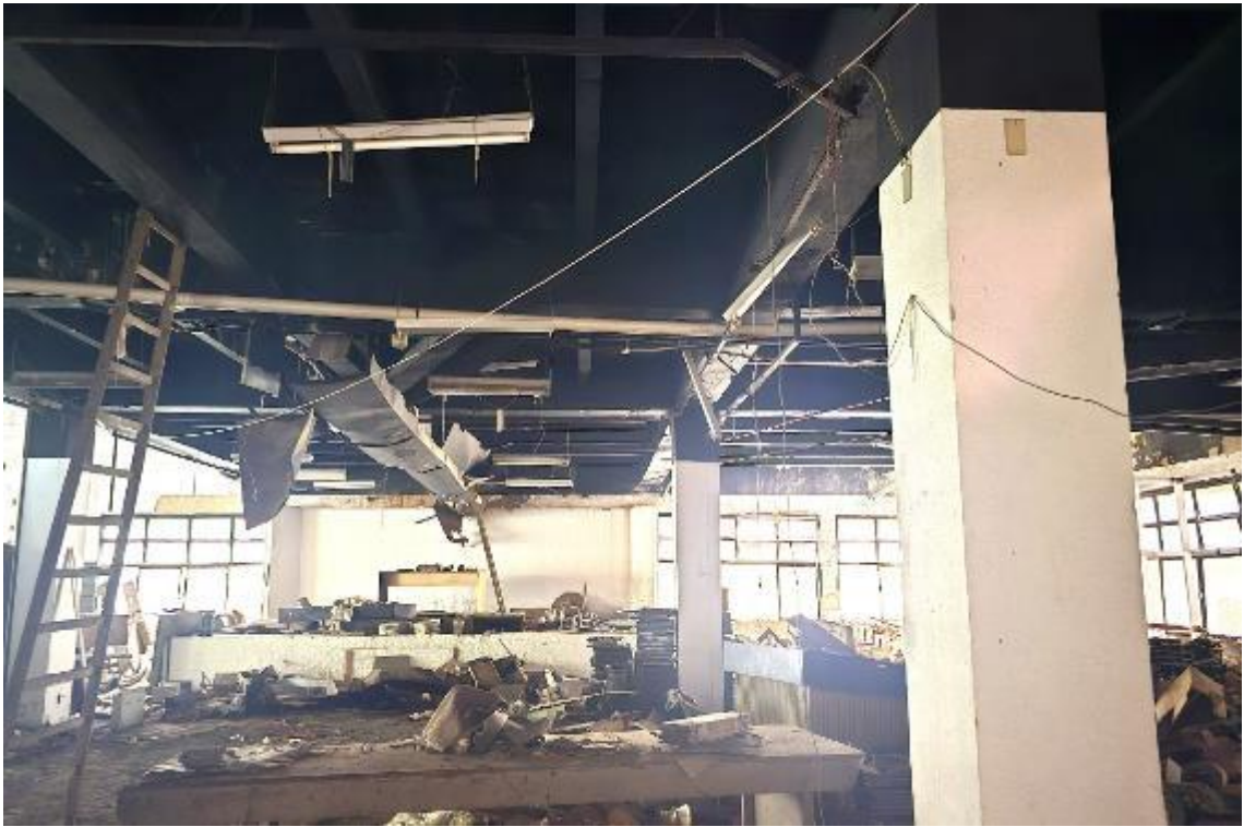
Foto 21 – Interior da loja/subsolo
