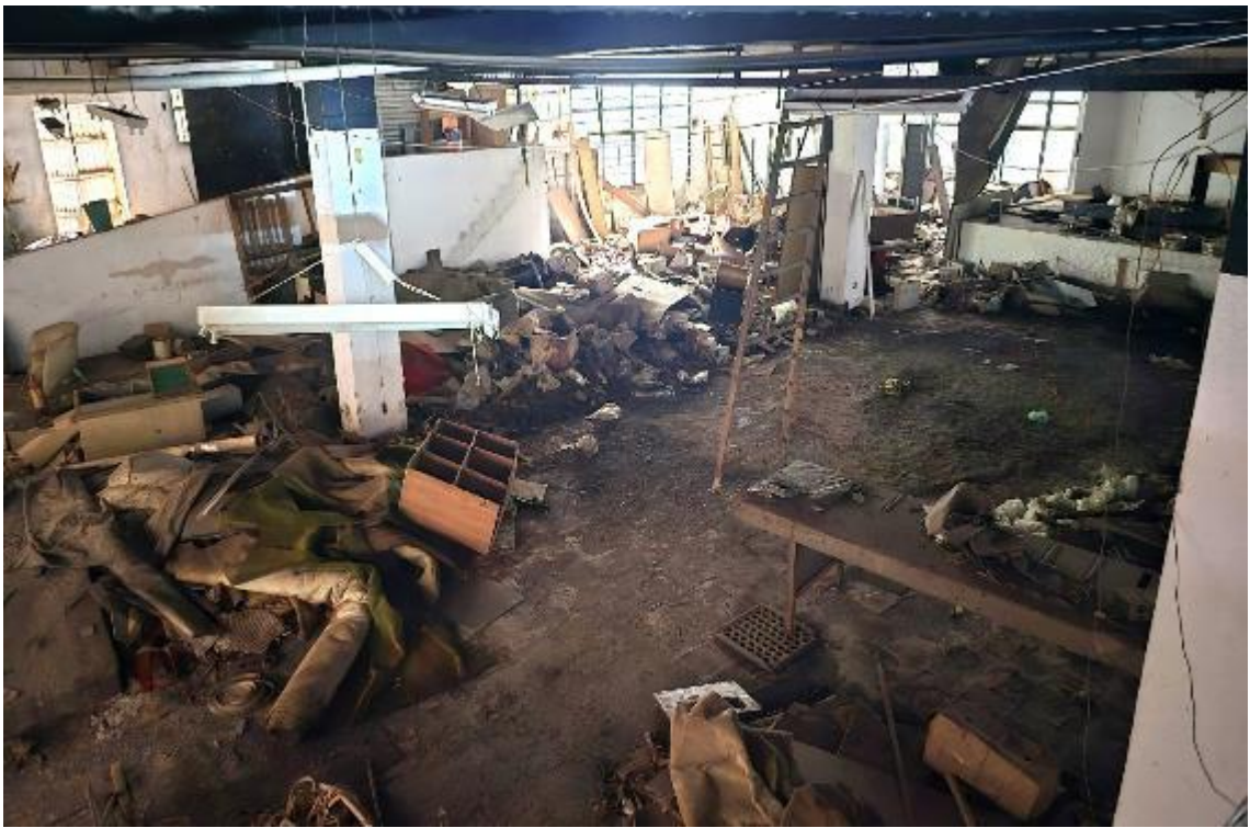
Foto 17 – Interior da loja/subsolo
