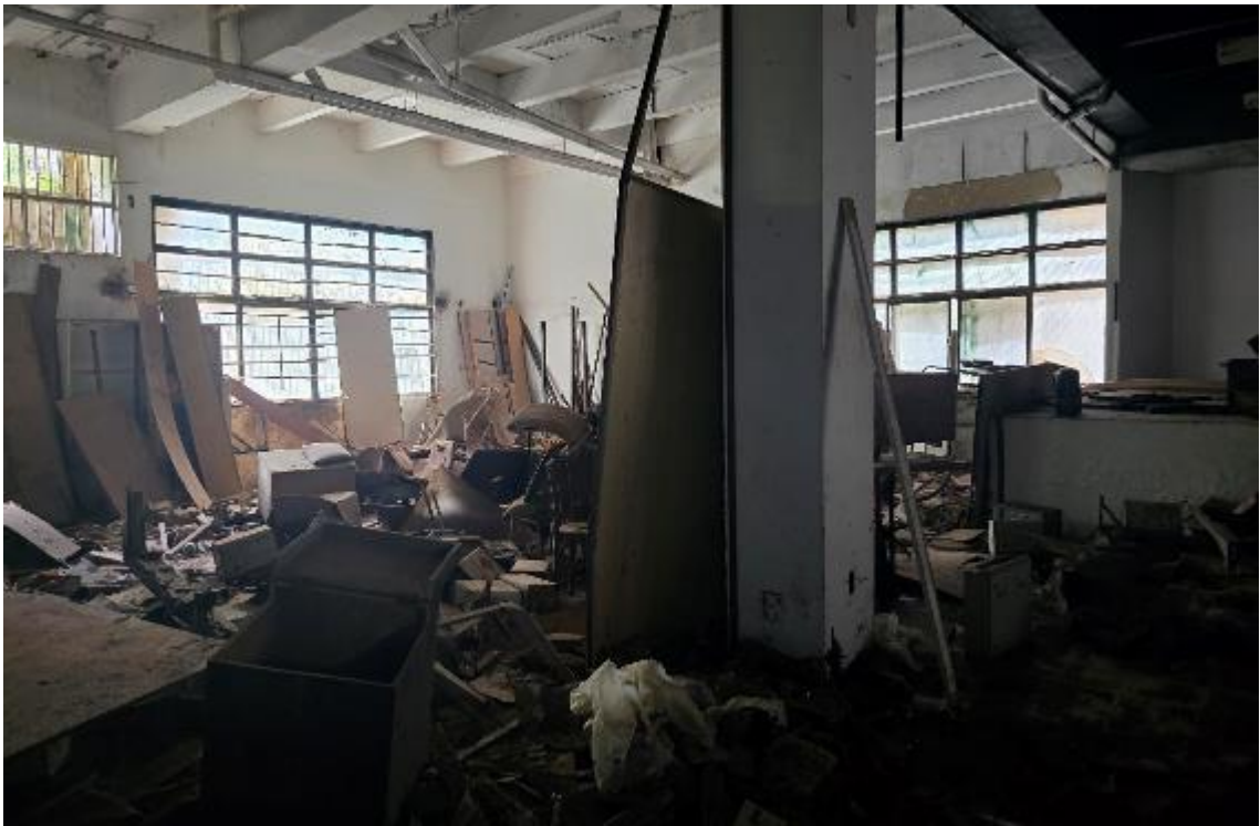
Foto 41 – Interior da loja/subsolo
