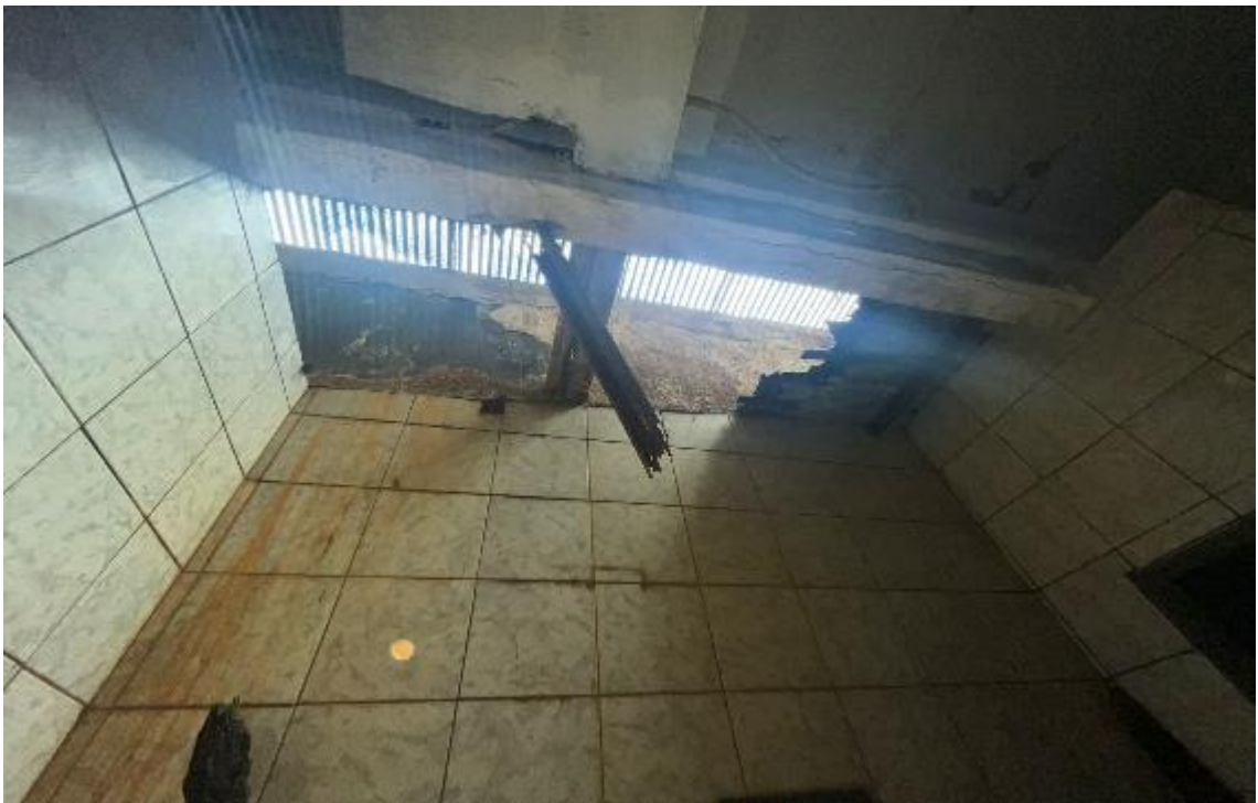
Foto 50 – Interior da loja/subsolo
