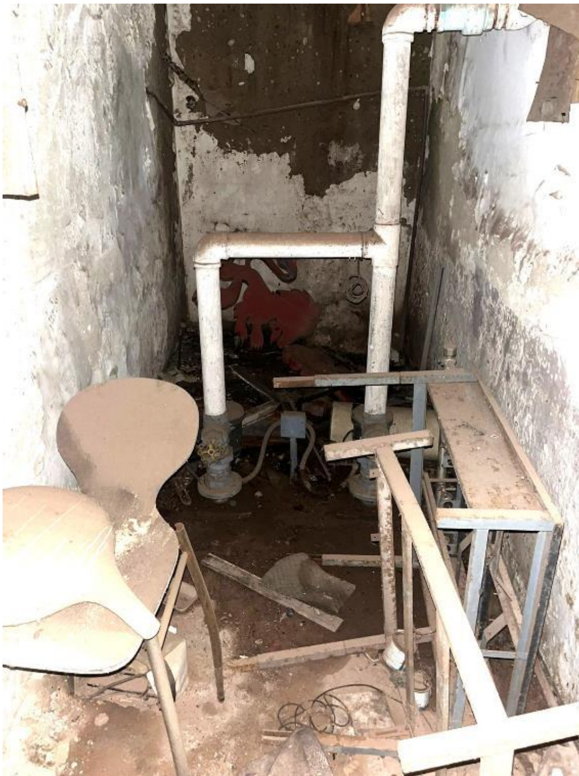
Foto 52 - Interior da loja/subsolo
