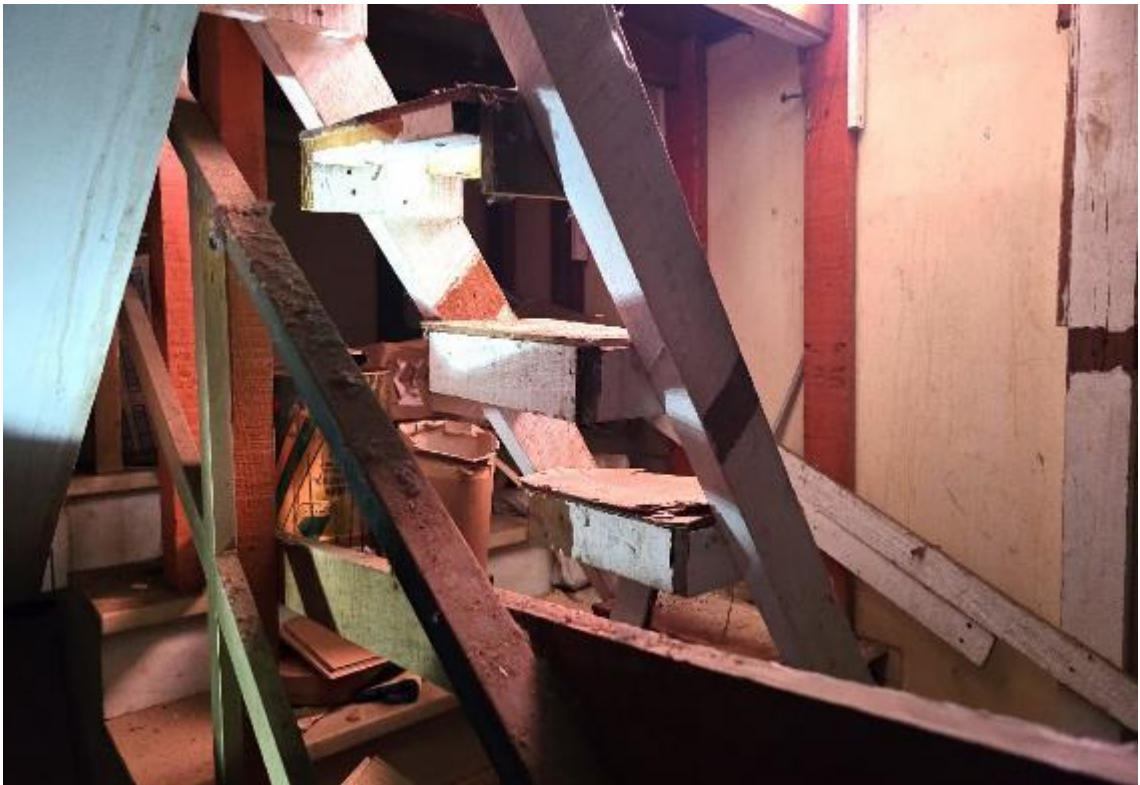
Foto 10 – Escada que dá acesso a loja no subsolo
