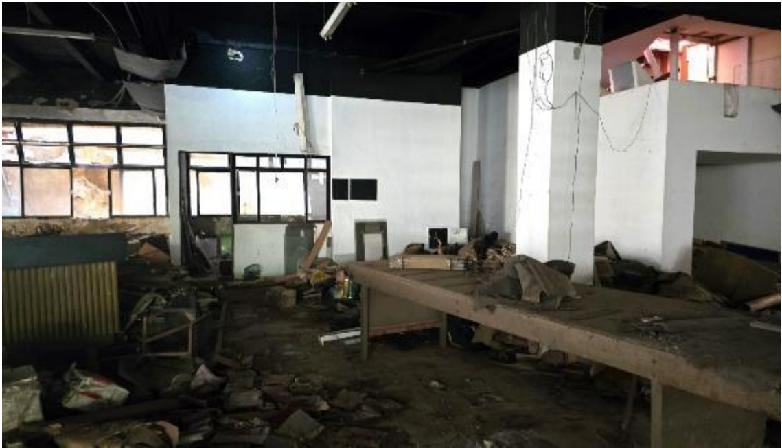
Foto 46 – Interior da loja/subsolo
