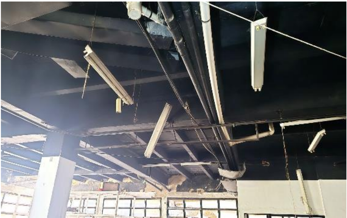
Foto 29 – Interior da loja/subsolo
