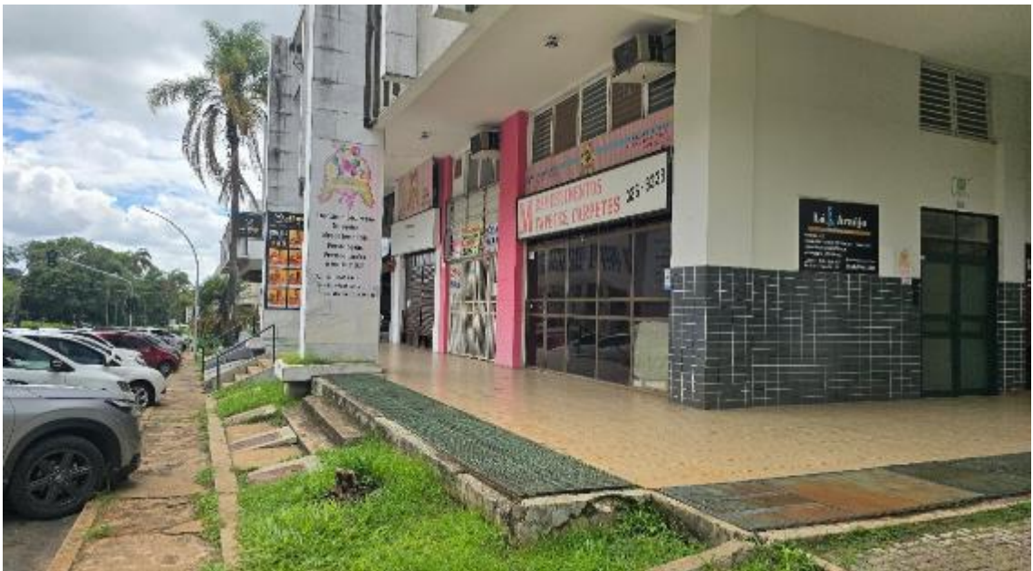
Foto 3 – Fachada da loja/visão lateral do prédio
