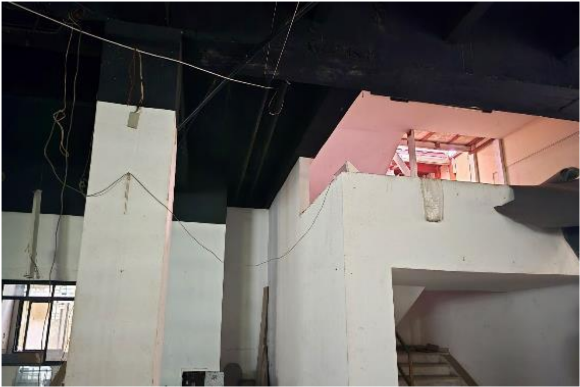
Foto 45 – Interior da loja/subsolo
