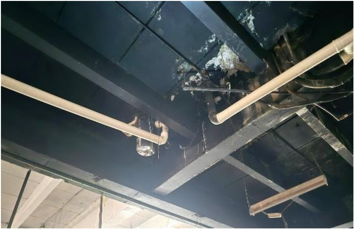
Foto 31 – Interior da loja/subsolo
