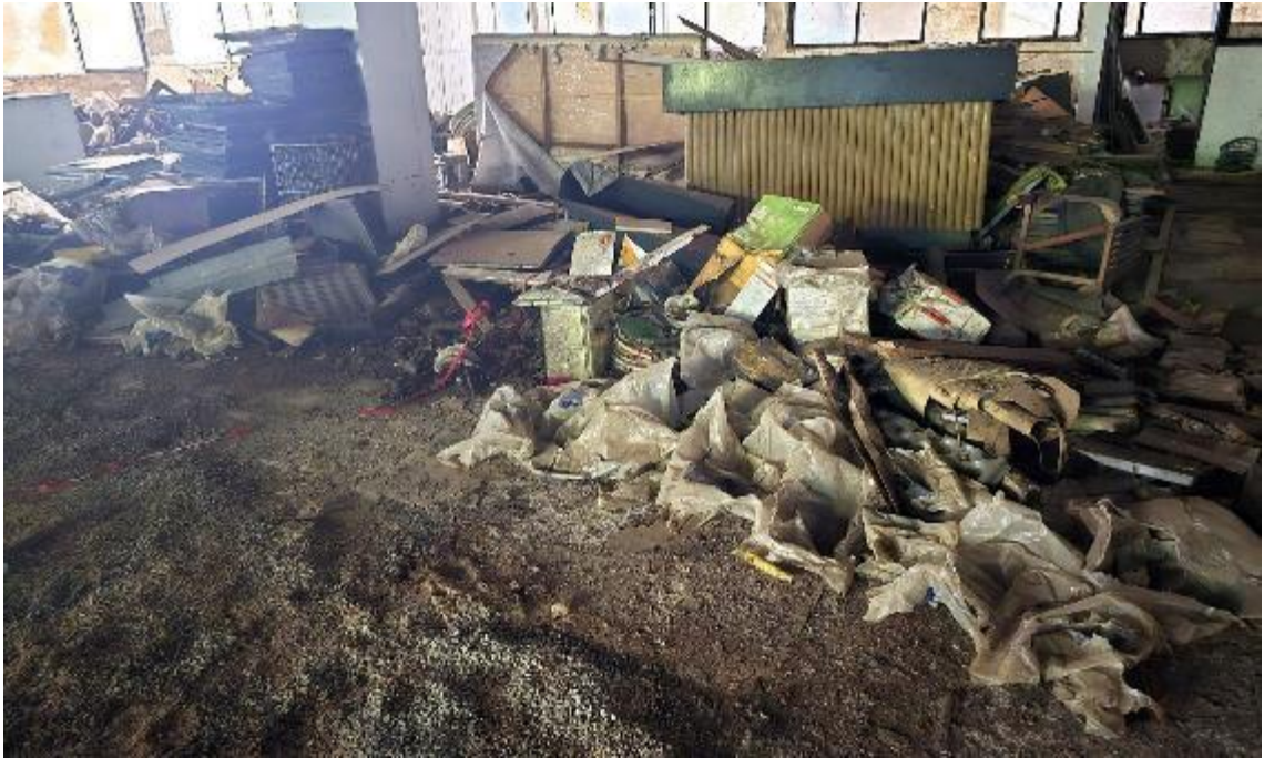
Foto 28 – Interior da loja/subsolo
