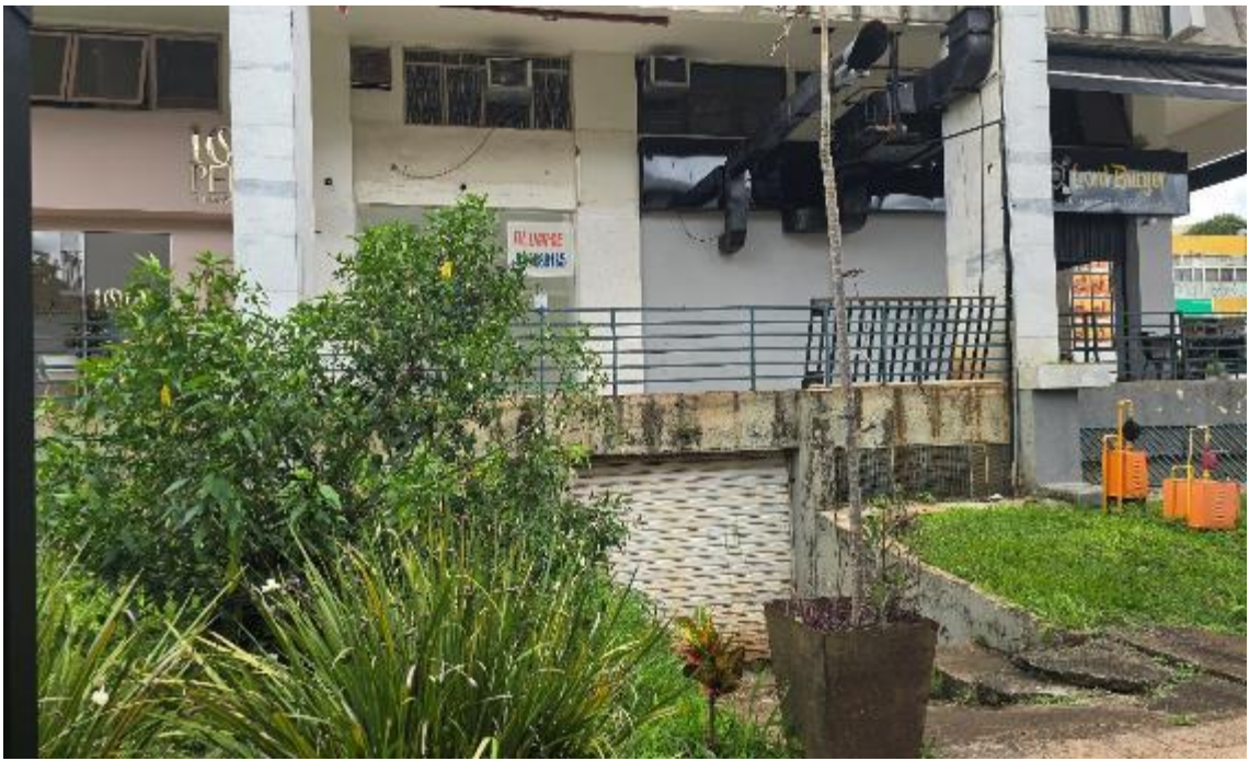
Foto 58 – Fachada lateral do prédio e acesso de serviço da loja (porta metálica)
