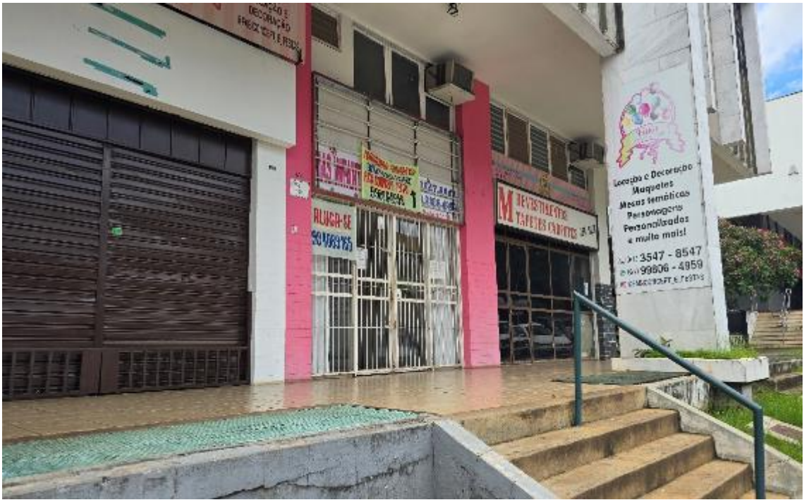
Foto 4 – Frente do prédio com visão lateral da fachada da loja
