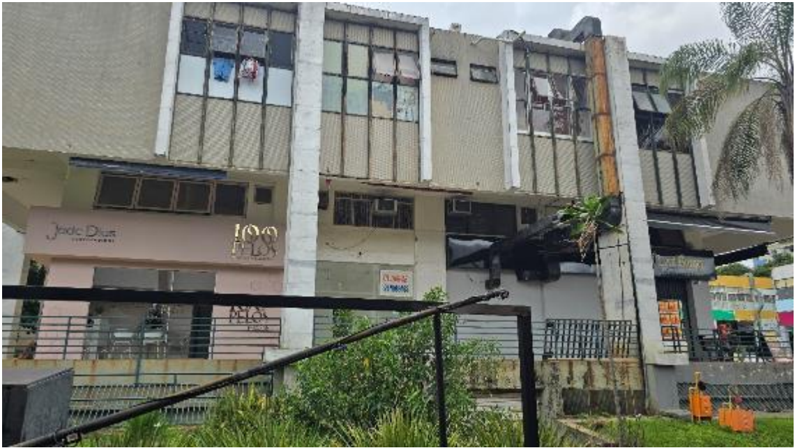
Foto 55 – Fachada lateral do prédio
