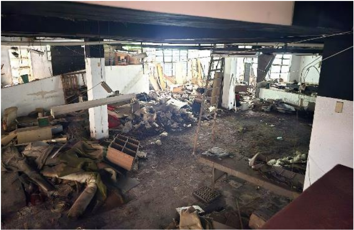
Foto 13 – Interior da loja/subsolo
