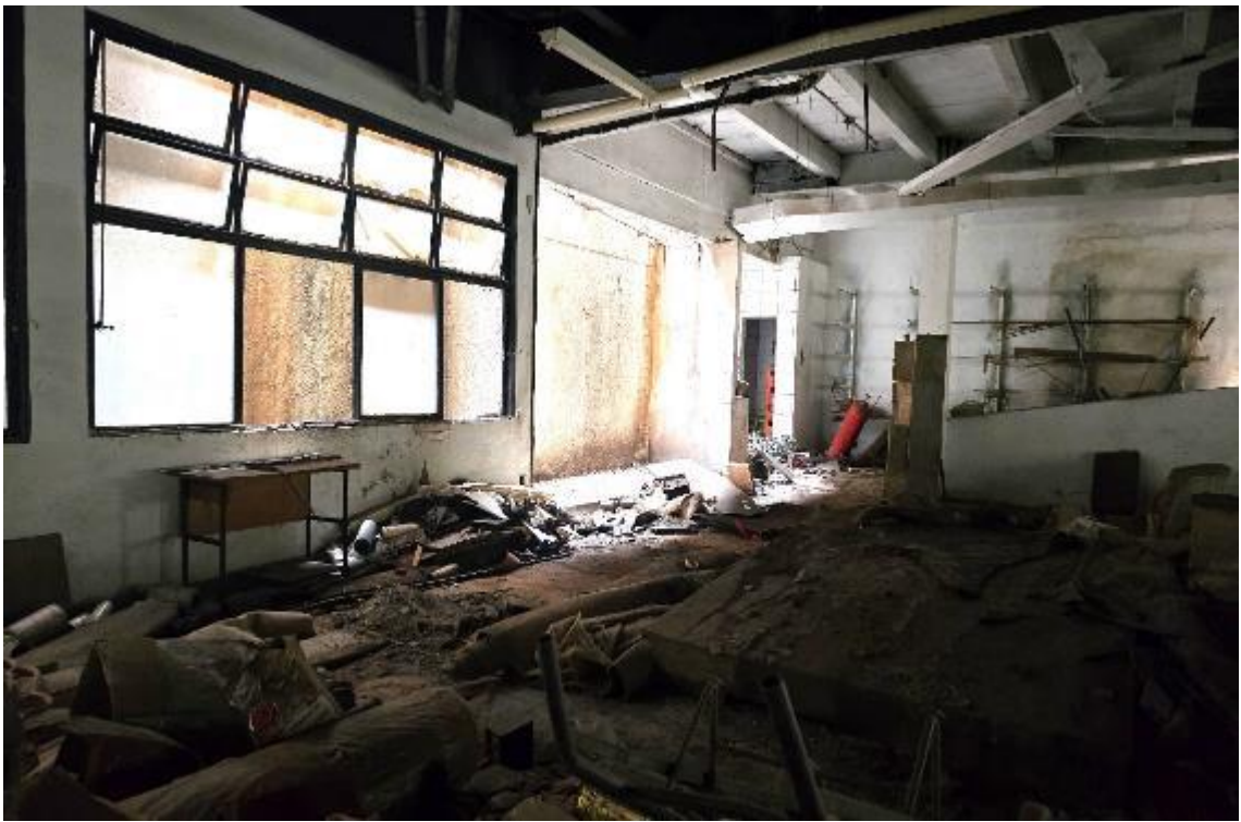
Foto 26 – Interior da loja/subsolo
