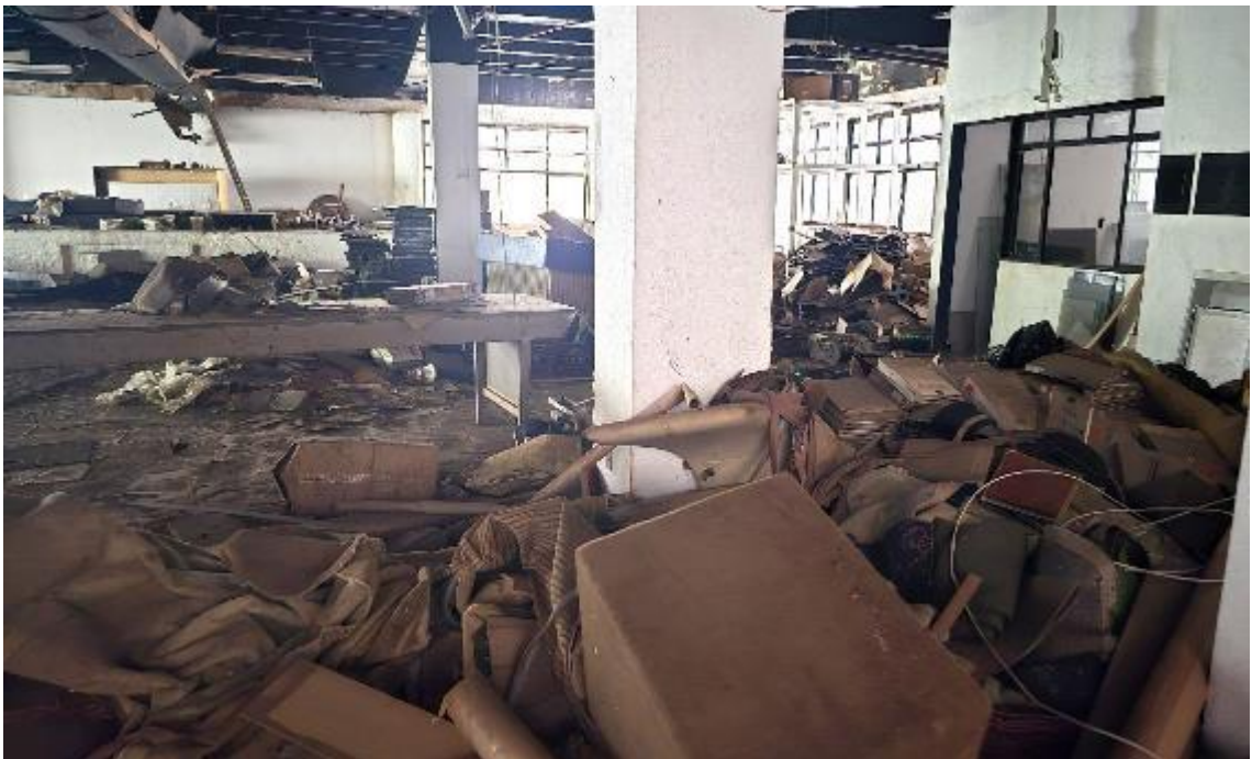
Foto 22 – Interior da loja/subsolo
