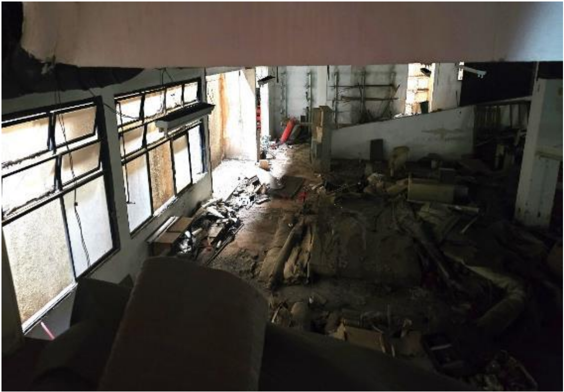
Foto 15 – Interior da loja/subsolo
