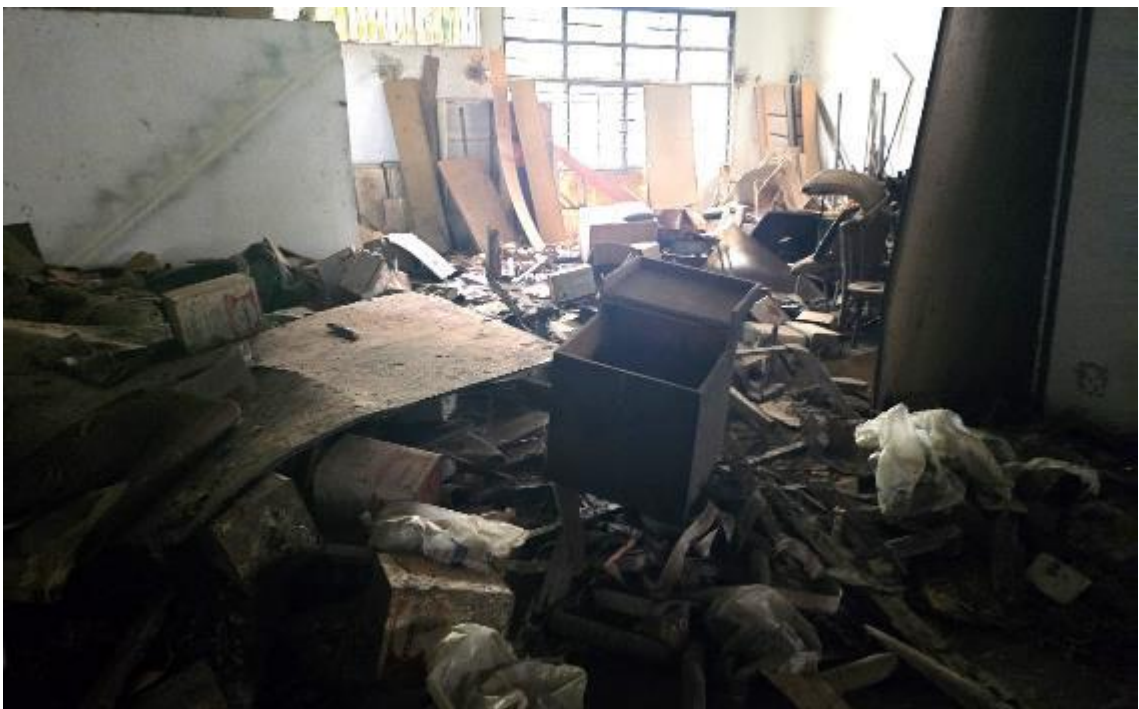
Foto 44 – Interior da loja/subsolo
