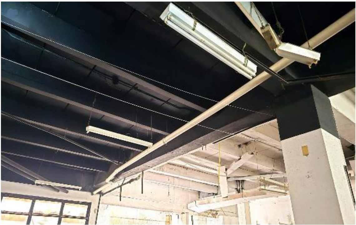
Foto 30 – Interior da loja/subsolo
