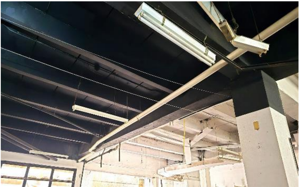
Foto 35 – Interior da loja/subsolo
