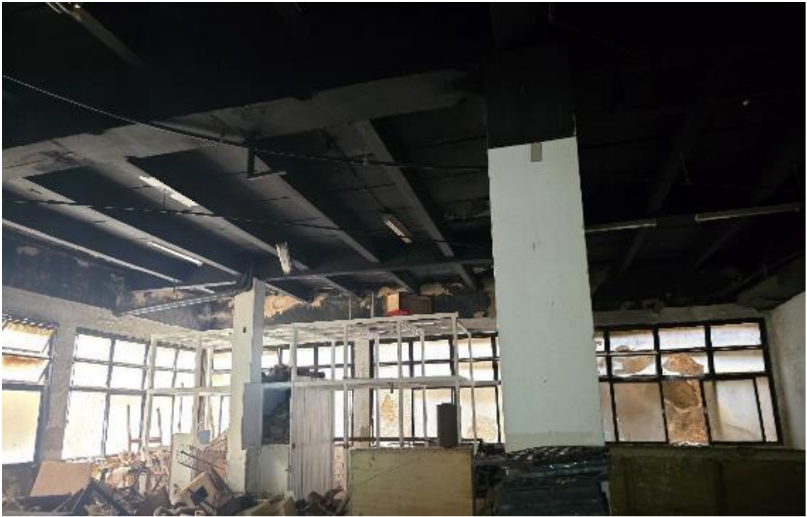
Foto 33 – Interior da loja/subsolo
