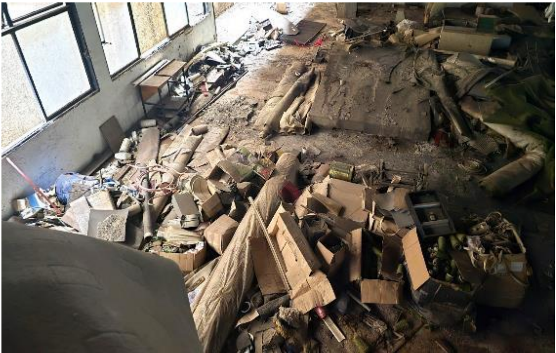
Foto 16 – Interior da loja/subsolo
