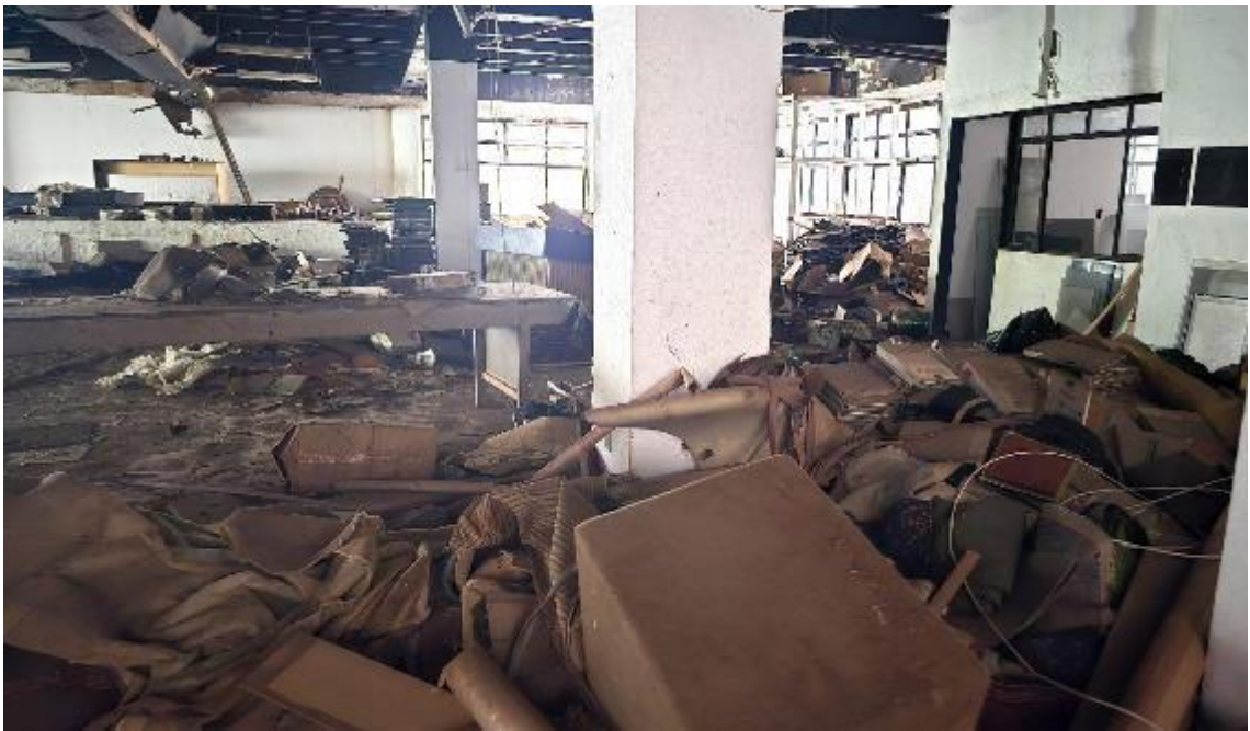
Foto 20 – Interior da loja/subsolo
