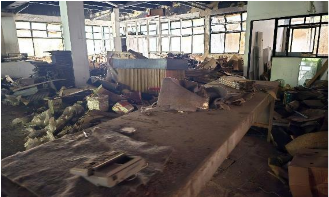
Foto 25 – Interior da loja/subsolo
