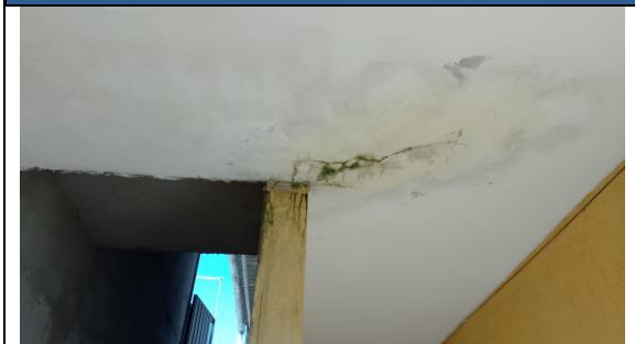
FOTO – Escada de acesso rachaduras
