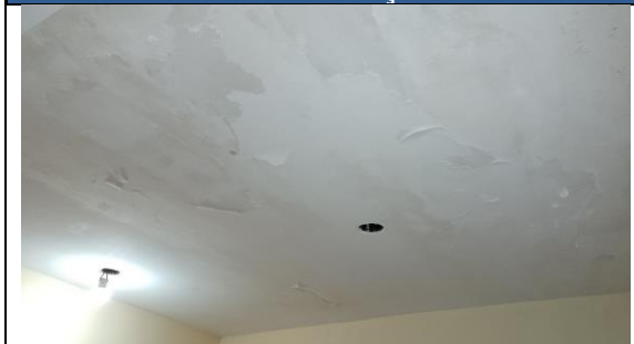
FOTO – Teto infiltração avarias
