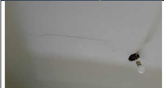
FOTO – Teto infiltração avarias
