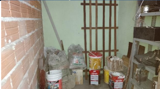
FOTO – Depósito inacabado
