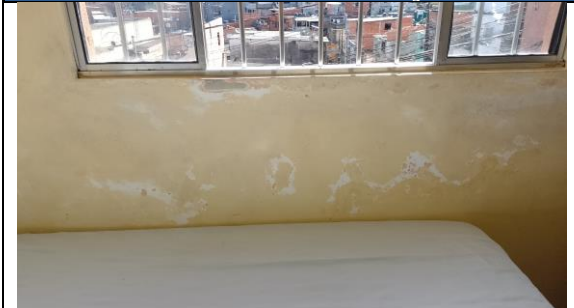
FOTO – Parede infiltração
