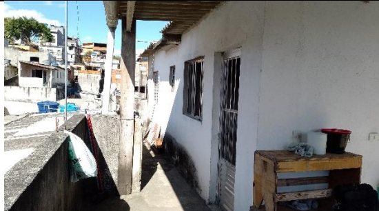
FOTO – Corredor lateral de acesso
