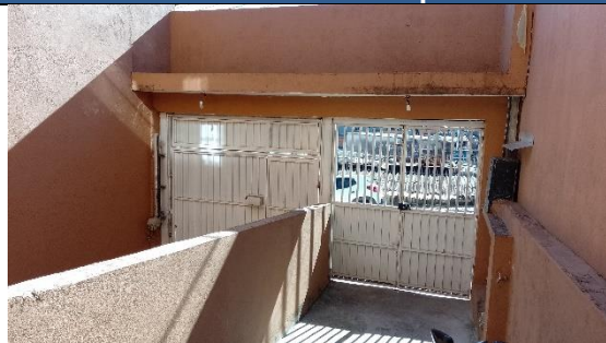
FOTO – Térreo / Portão e Rampa de acesso
