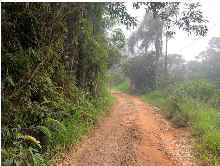
DETALHES DA VIA DE ACESSO AO IMÓVEL
