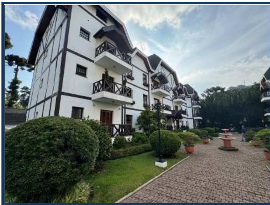
Vista do Edifício Deber ( Bloco “C” ).
