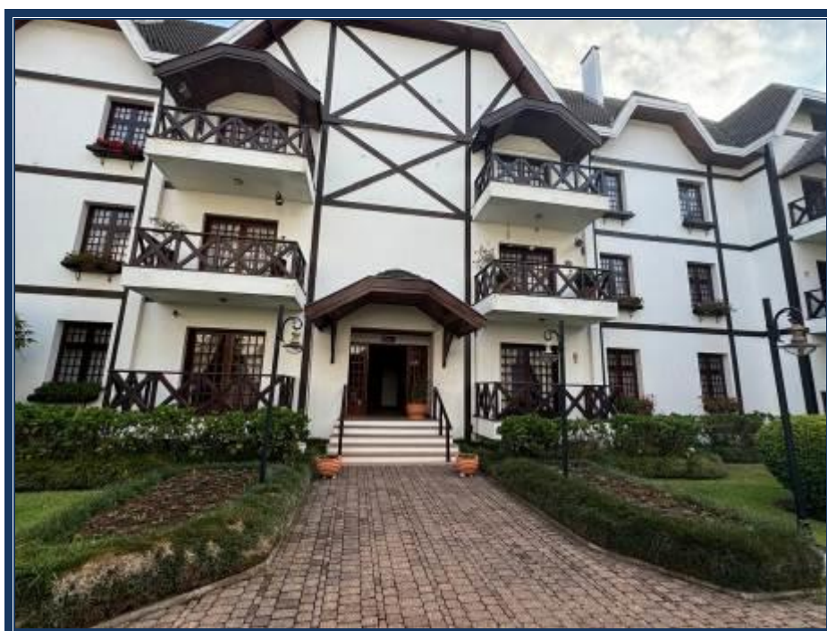
Vista do Edifício Deber ( Bloco “C” ).
