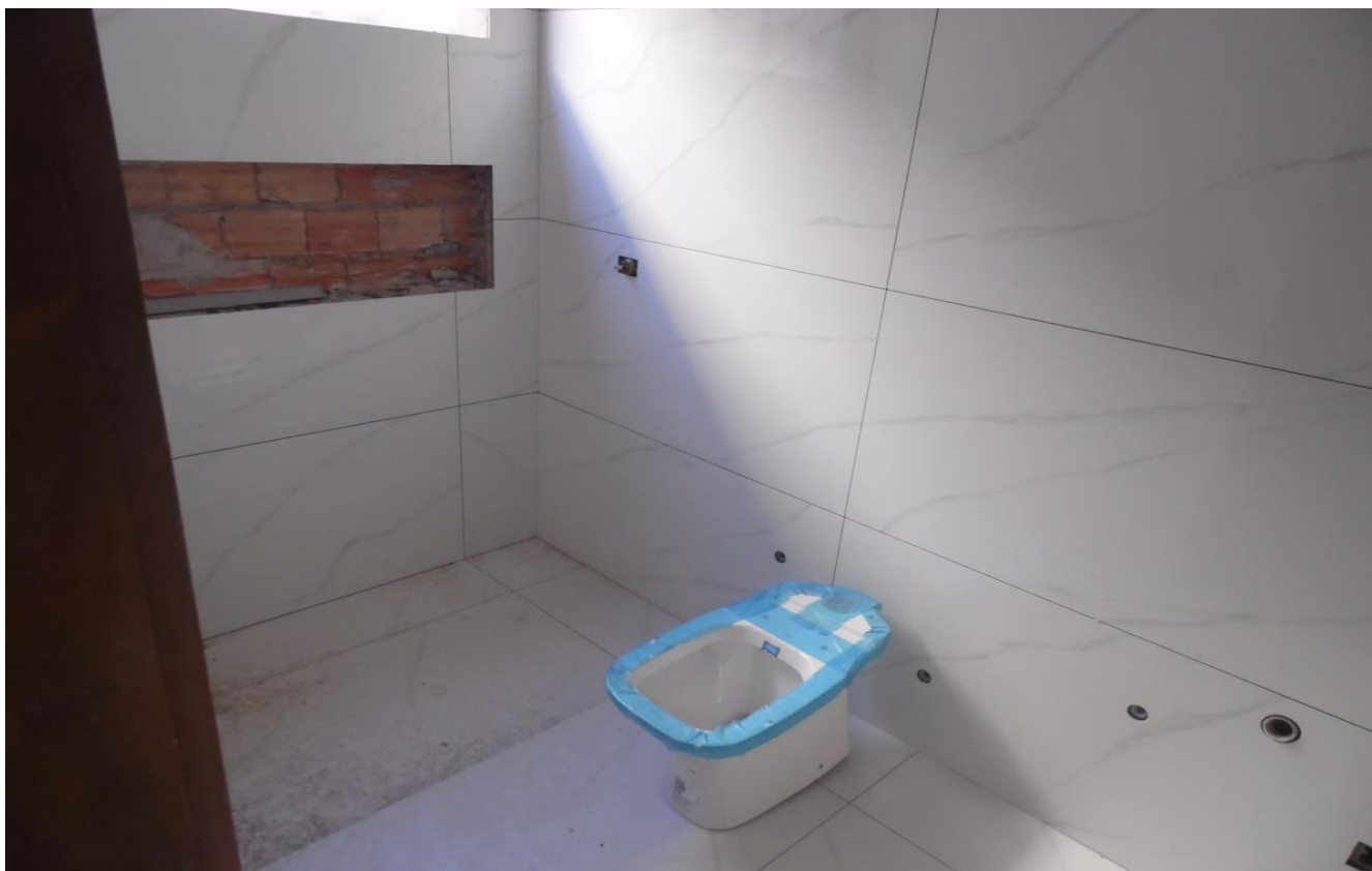
Imagem 14 – Banheiro da Suíte - pisos e revestimentos cerâmicos assentados e instalação hidráulica concluída, ainda está pendente a instalação elétrica (fiação) e acabamentos finais.
