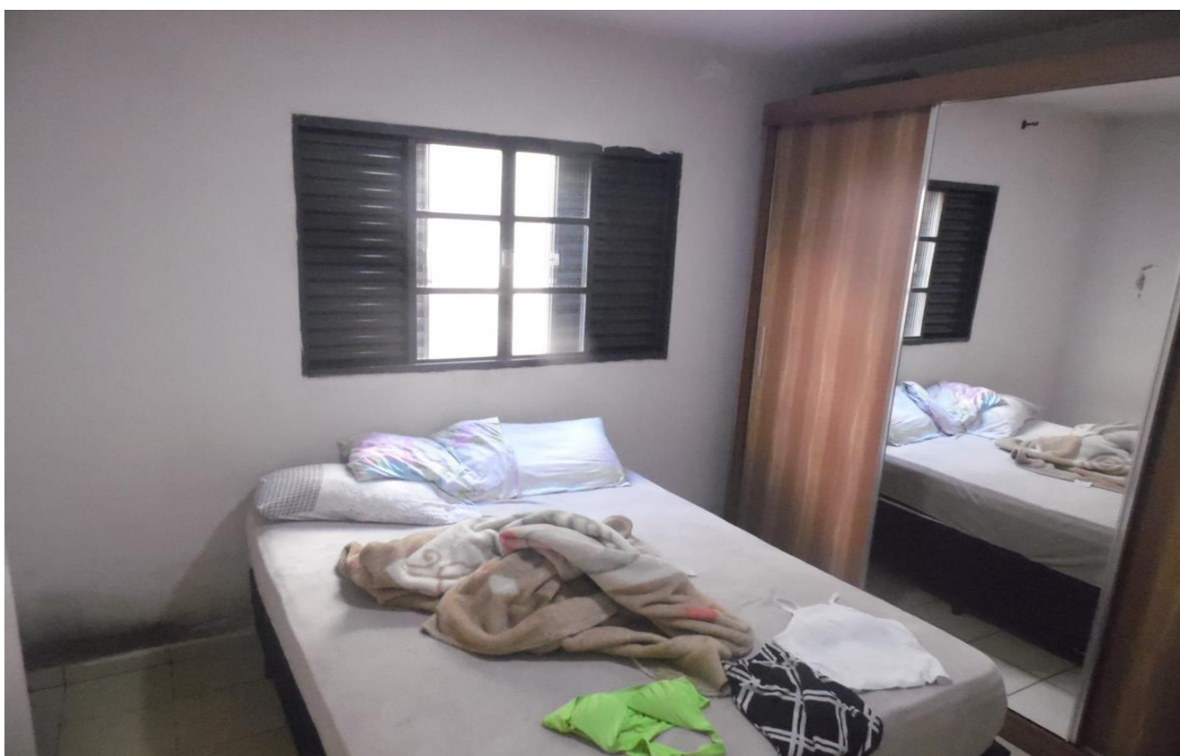
Imagem 11 – O outro Dormitório - mesmo padrão construtivo, pintura precisando de revisão.
