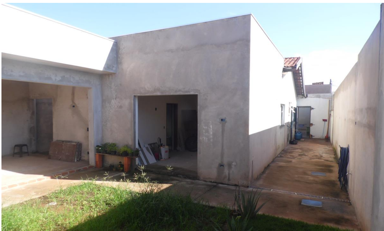
Imagem 05 – Fundos do imóvel - local em que está sendo construída uma Suíte com Closet e uma Área de Lazer com Churrasqueira, que finalizados elevarão o valor de mercado do imóvel.
