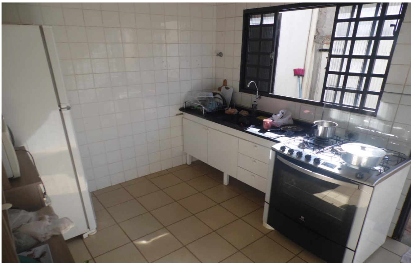
Imagem 08 – Cozinha - pisos cerâmicos, revestimentos até o teto, Laje, instalações hidráulicas e elétricas embutidas, Esquadrias em metal, gabinete, bancada e metais no padrão simples.
