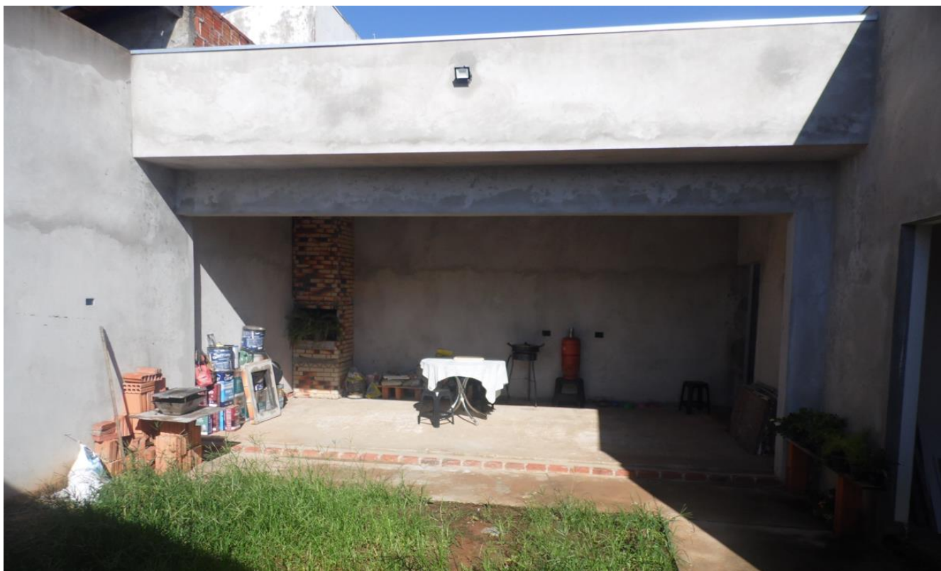
Imagem 06 – Fundos do imóvel - local em que está sendo construída uma Suíte com Closet e uma Área de Lazer com Churrasqueira, que finalizados elevarão o valor de mercado do imóvel.
