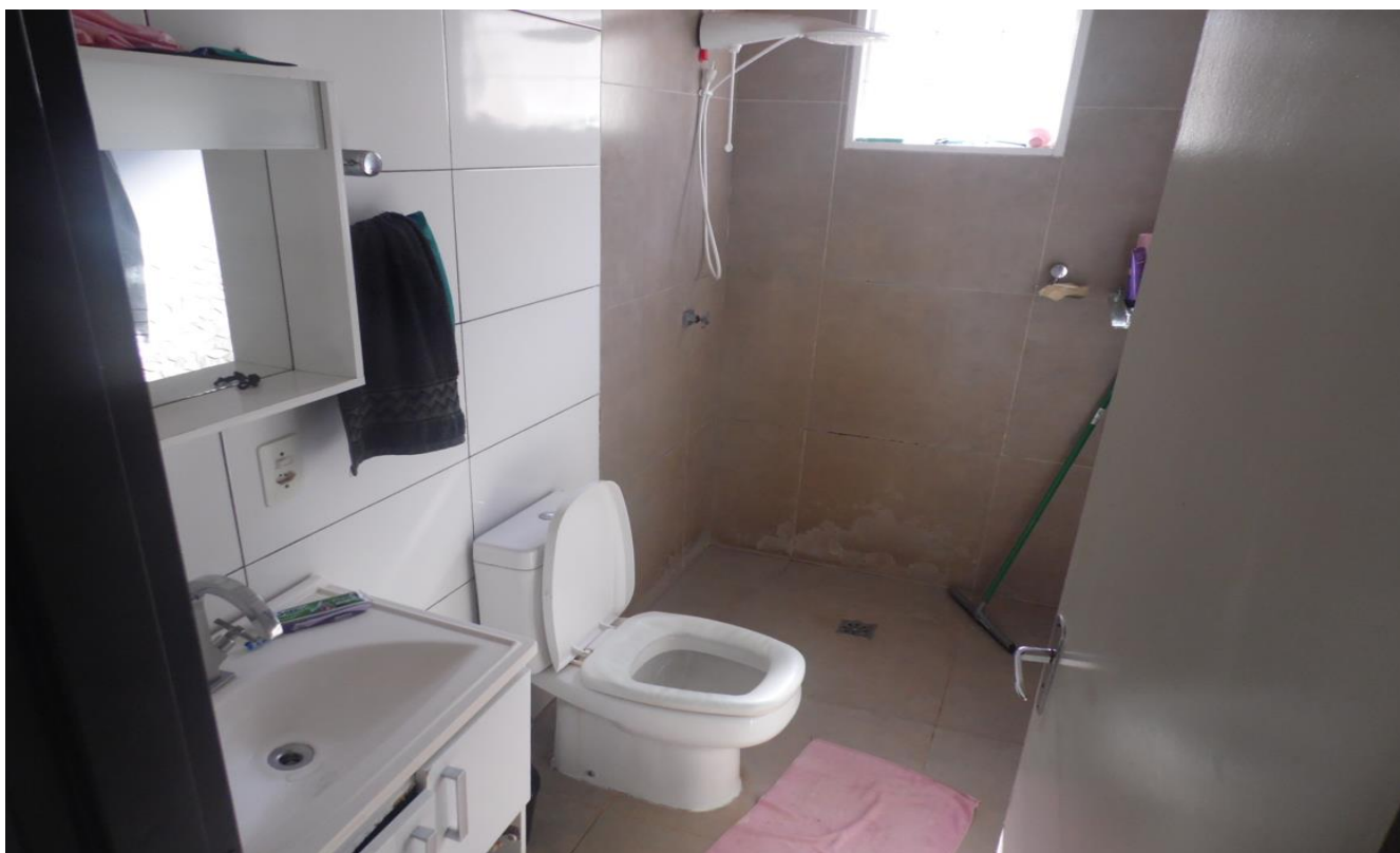
Imagem 09 – Banheiro - pisos cerâmicos, revestimentos até o teto, Laje, instalações hidráulicas e elétricas embutidas, Esquadrias em metal, Louças e Metais sanitários no padrão simples.
