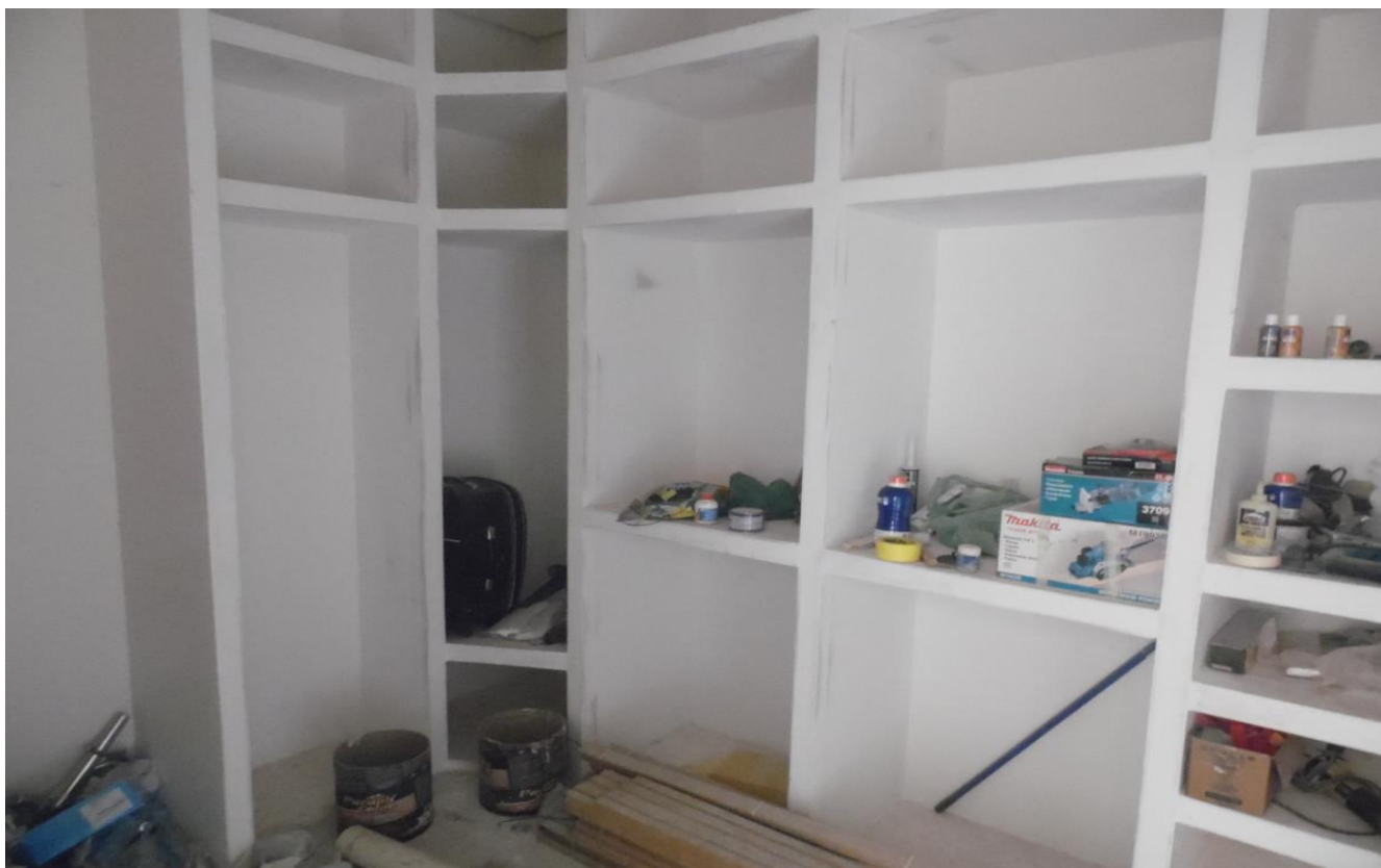
Imagem 13 – Closet - também em construção, contrapiso, nichos em gesso (dry wall), paredes rebocadas e pintura a ser realizada, quando concluído elevará o valor de mercado do imóvel.
