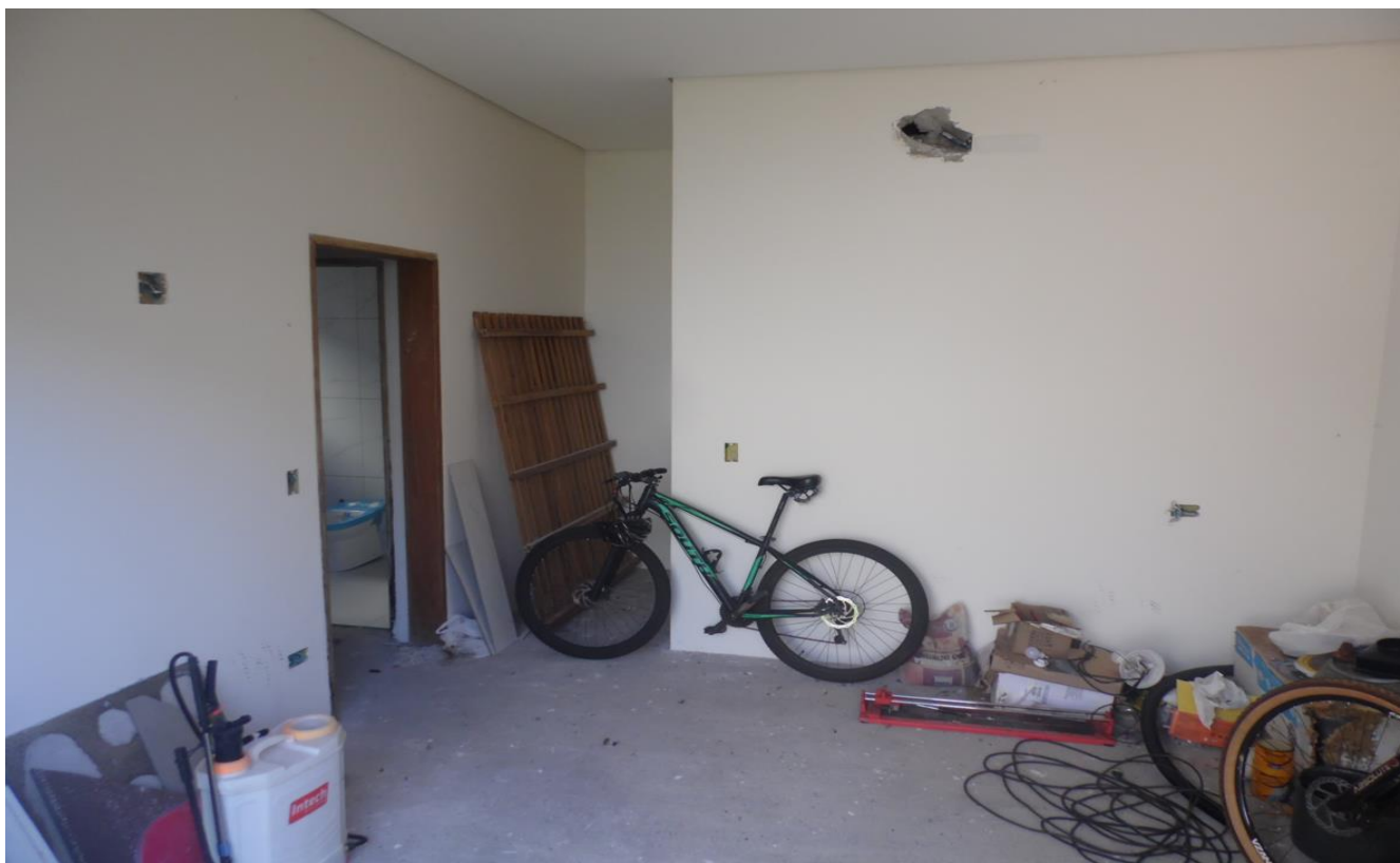
Imagem 12 – Parte dos fundos, Suíte - ainda em construção, contrapiso, forração em gesso, instalação elétrica sem fiação, mas com caixas de passagens e conduítes, e paredes rebocadas.
