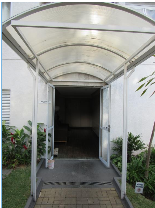
Foto de nº 28 - Acesso ao edifício.
