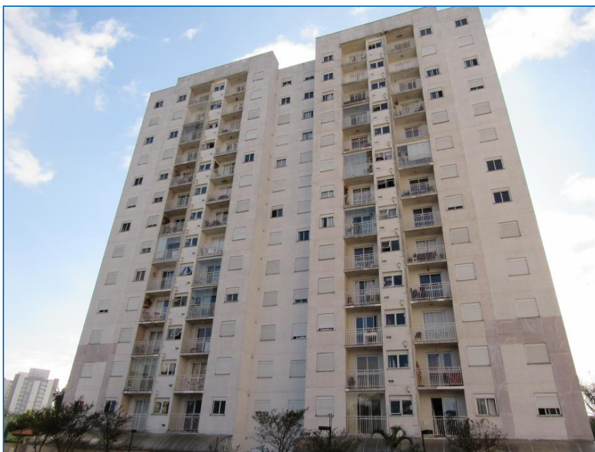
Foto de nº 15- Aspectos gerais do edifício.
