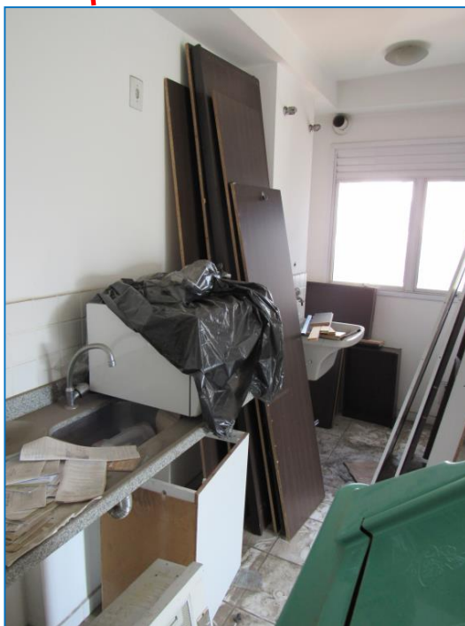
Foto de nº 48- Outra vista da cozinha.
