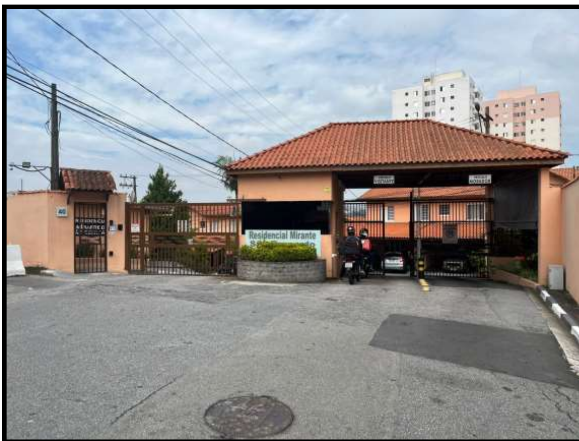
FACHADA DO “CONDOMÍNIO RESIDENCIAL MIRANTE DE SÃO BERNARDO”
