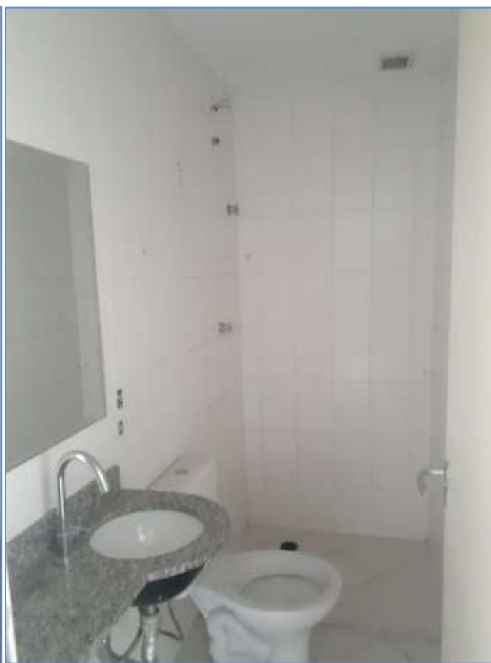
- FOTO 14 – Vista Banheiro comum.
