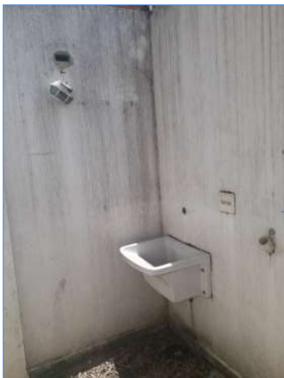
FOTO 10 – Vista da área de serviço no Pav. Térreo
