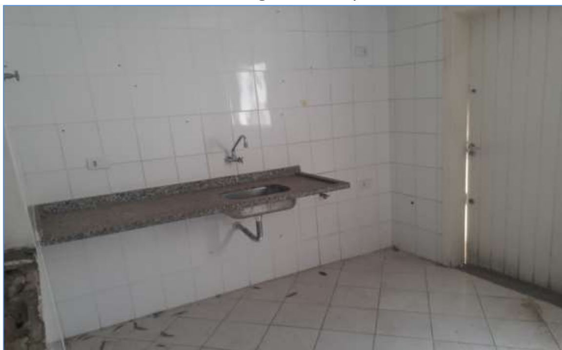
- FOTO 07 – Vista geral da cozinha. Note que ainda faltam executar parte dos acabamentos e reforma parcial.
