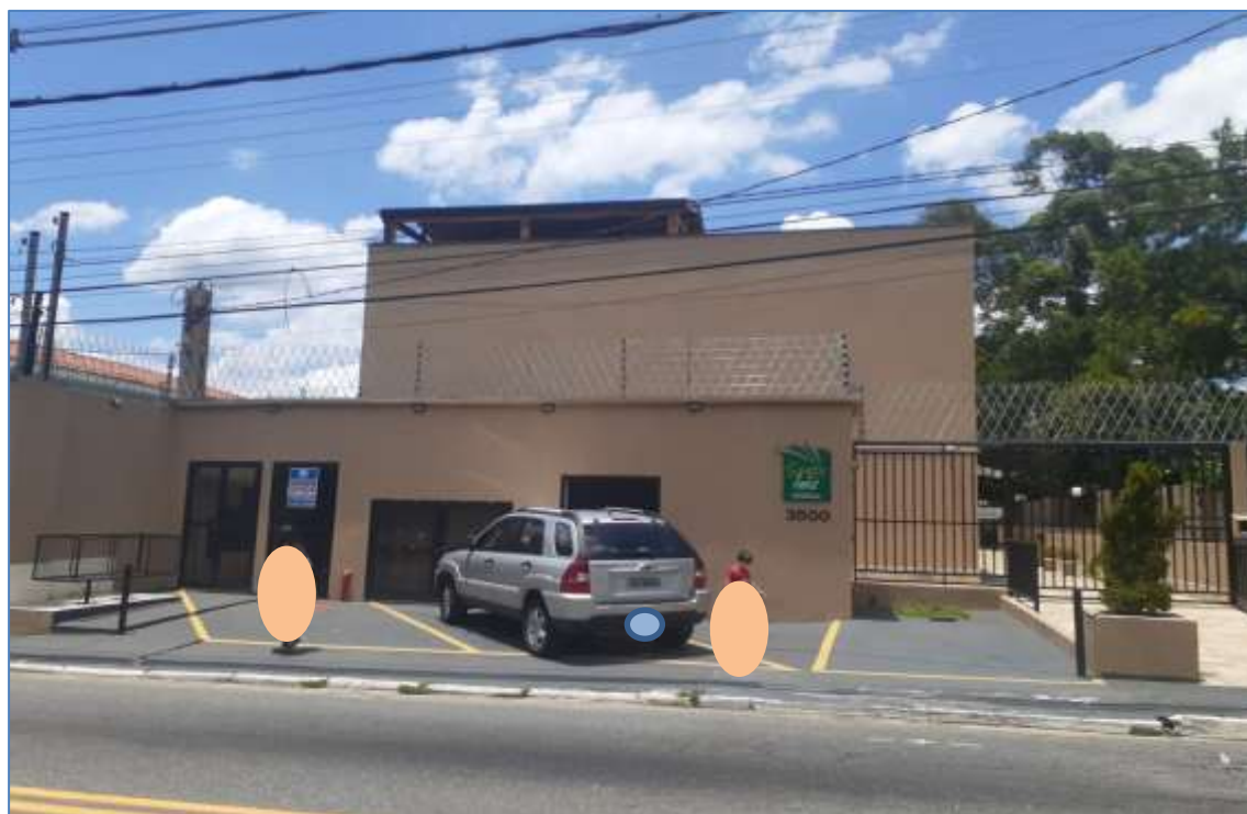
- FOTO 01 – Vista da fachada do Condomínio.
