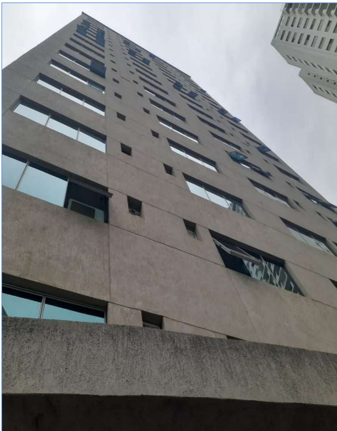
- FOTO 10 - Vista geral da fachada do edifício.
