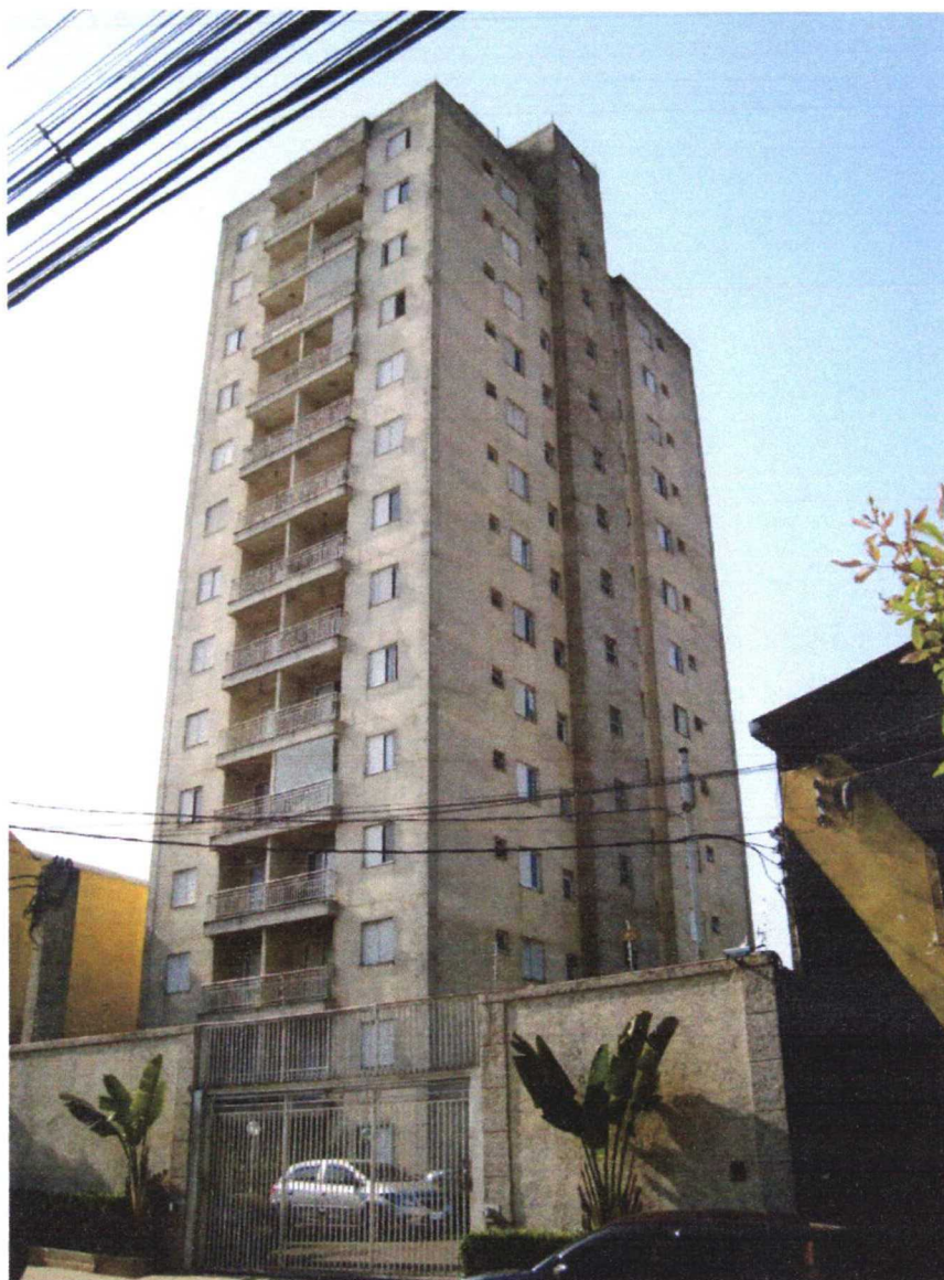
Foto nº 1- Vista do edifício pelo lado externo
