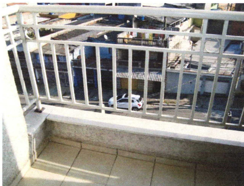
Foto nº 27- Detalhe do terraço externo
