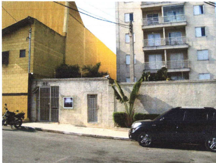
Foto nº 2- Vista parcial da entrada de pedestre e da guarita
