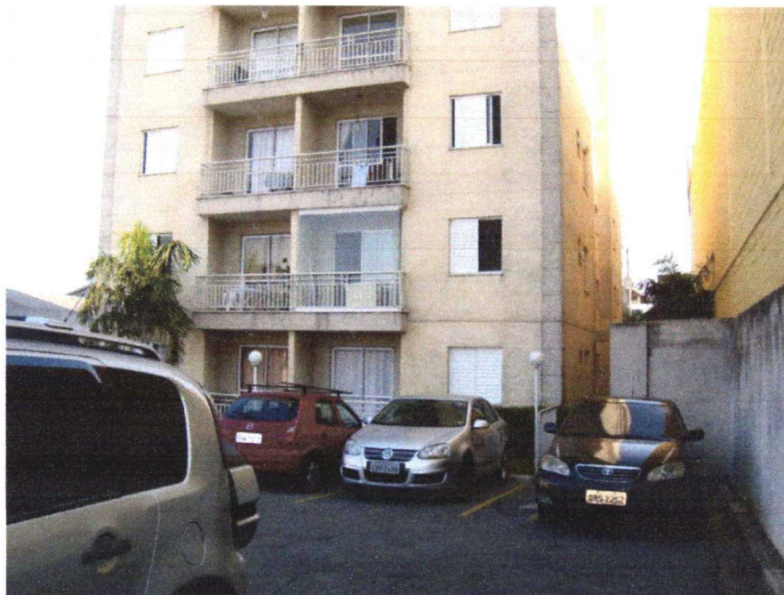
Foto nº 10- Vista parcial do estacionamento
