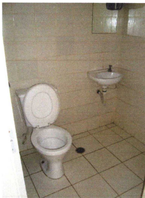
Foto nº 15- Vista parcial do banheiro do salão de festas
