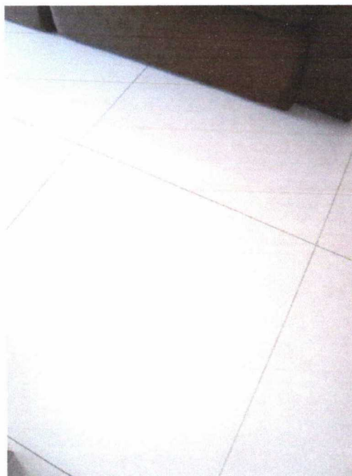
Foto nº 34- Detalhe do piso da sala
