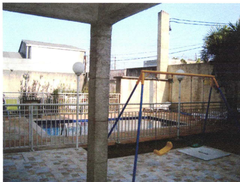
Foto nº 7- Vista parcial da piscina e do playground
