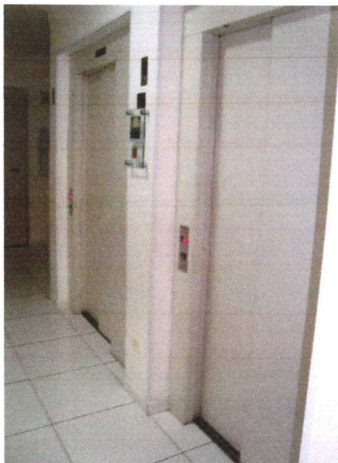
Foto nº 16- Vista parcial da porta dos elevadores no pavimento térreo
