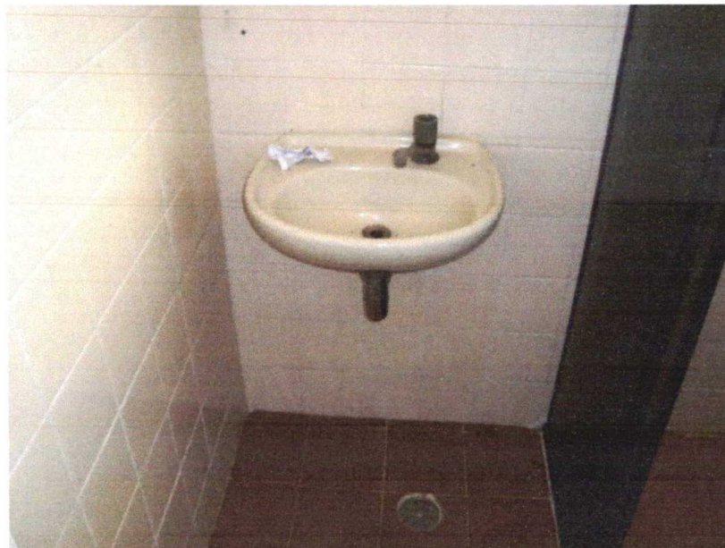
Foto nº 32- Detalhe de aparelho sanitário (pia) do banheiro
