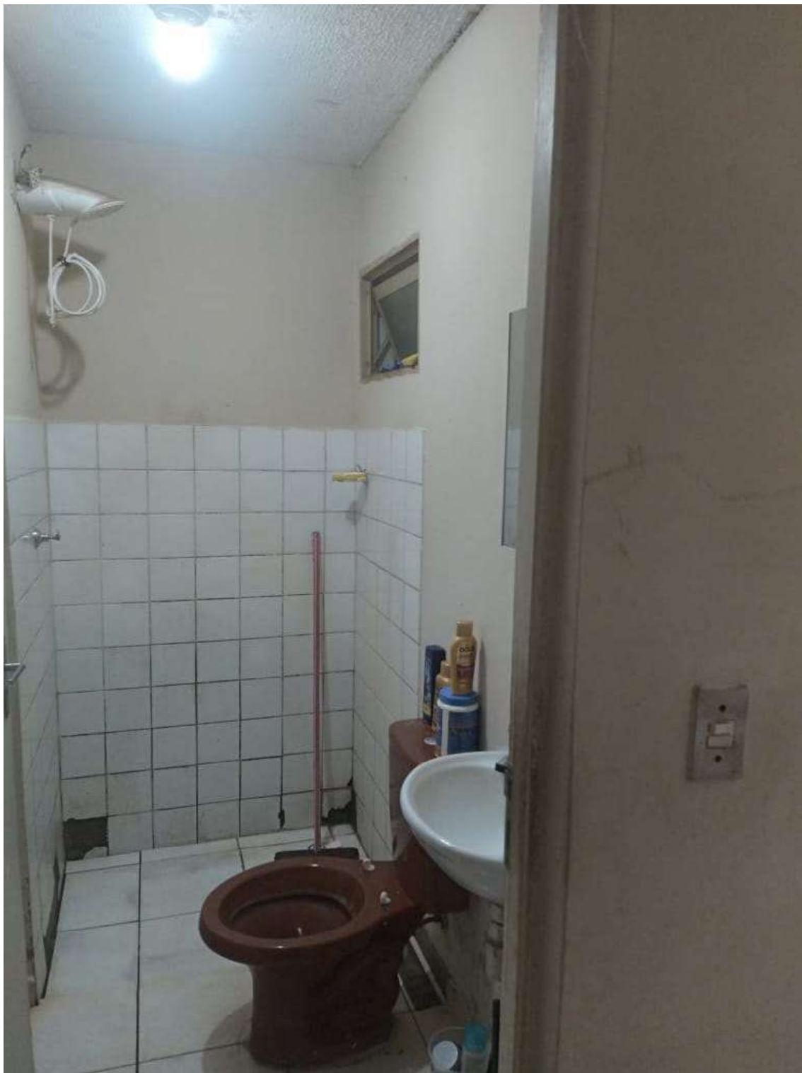
Foto 2 - Mostra o banheiro
