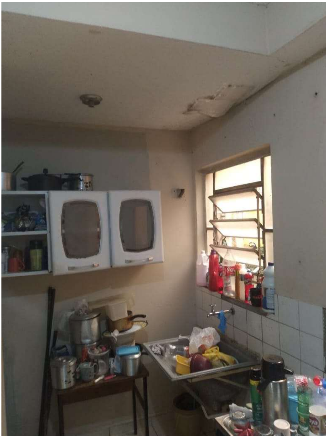
Foto 4 - Mostra a cozinha/área de serviço
