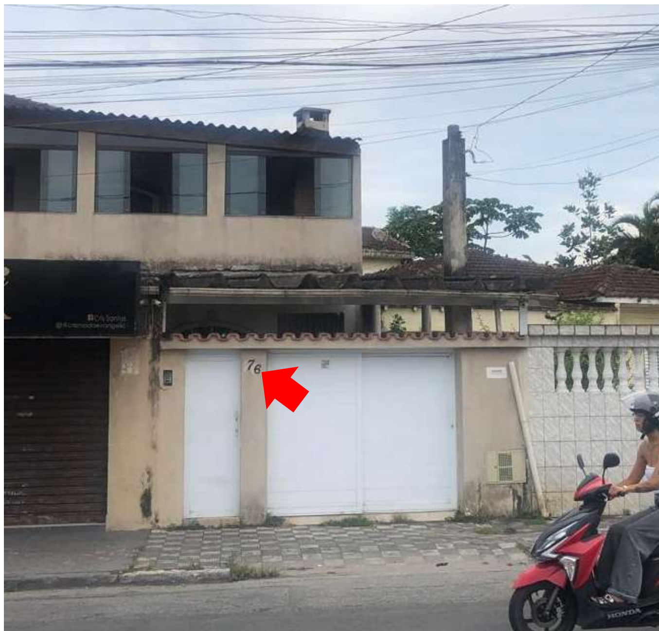
Figura 12 – Vista aproximada do imóvel avaliado e destaque para o emplaceamento incompatível.
