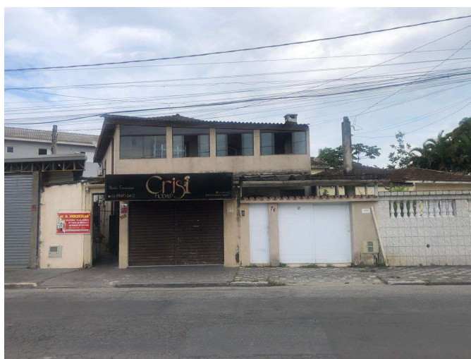
Figura 11- Vista frontal da parte térrea e superior da Edificação sobreposta.
