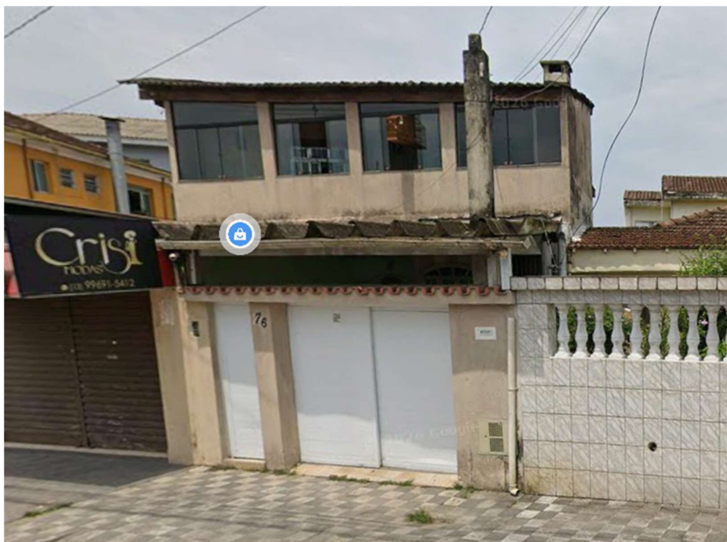
Figura 4 – Imagem da residência Térrea (Avaliada) e Sobreposta, localizada conforme nº de registro da prefeitura municipal e mapa de geoprocessamento ilustrado mais adiante. Fonte: Google Maps. Numeração emplacada encontrada não compatível.
