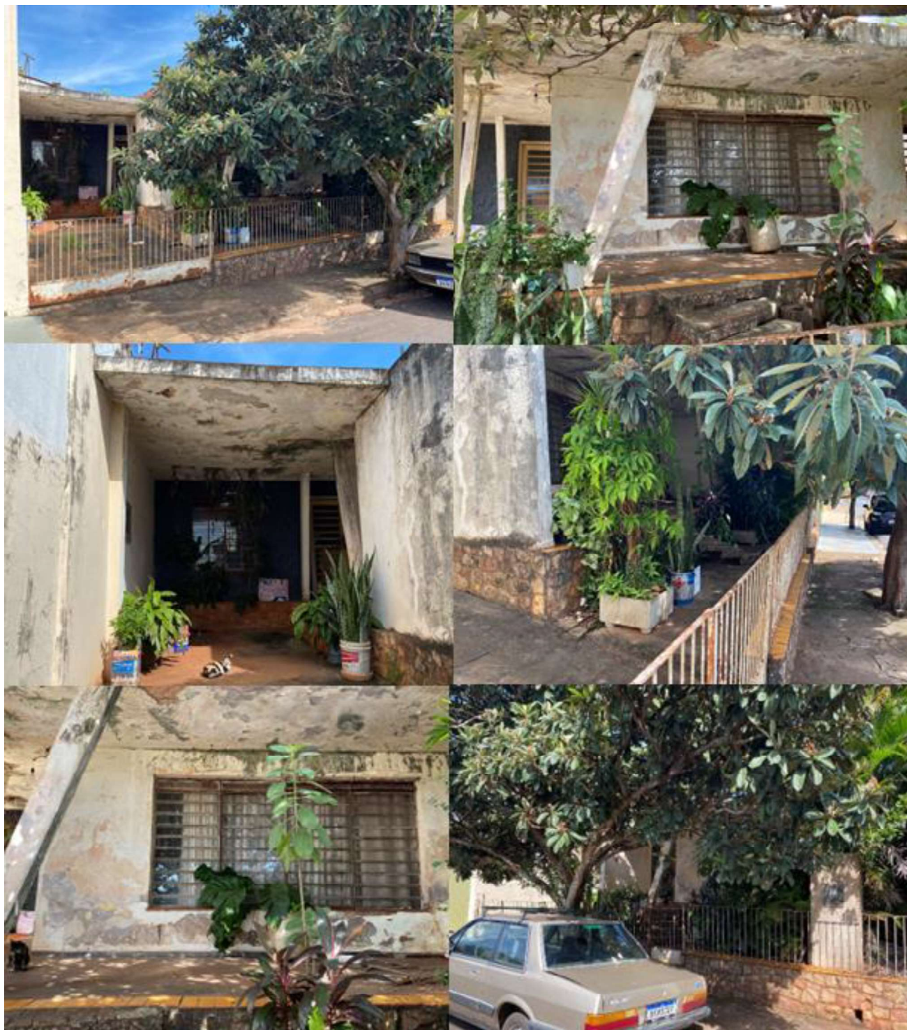
Figura 6 – Compilação de imagens vista externa/fachada do imóvel
