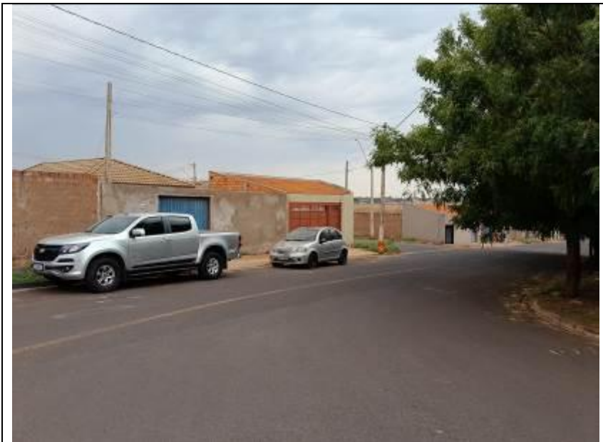
Vista Parcial da Rua VN 38 lazid José Daher com o Imóvel à Esquerda
