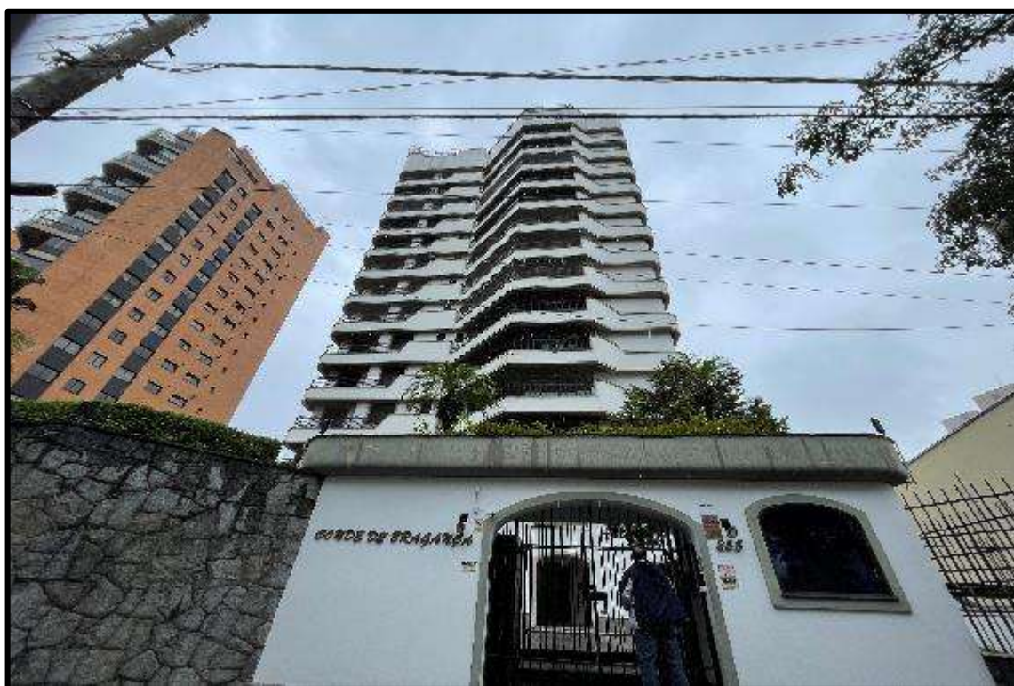
FOTO 6 – Fachada frontal do edifício.
