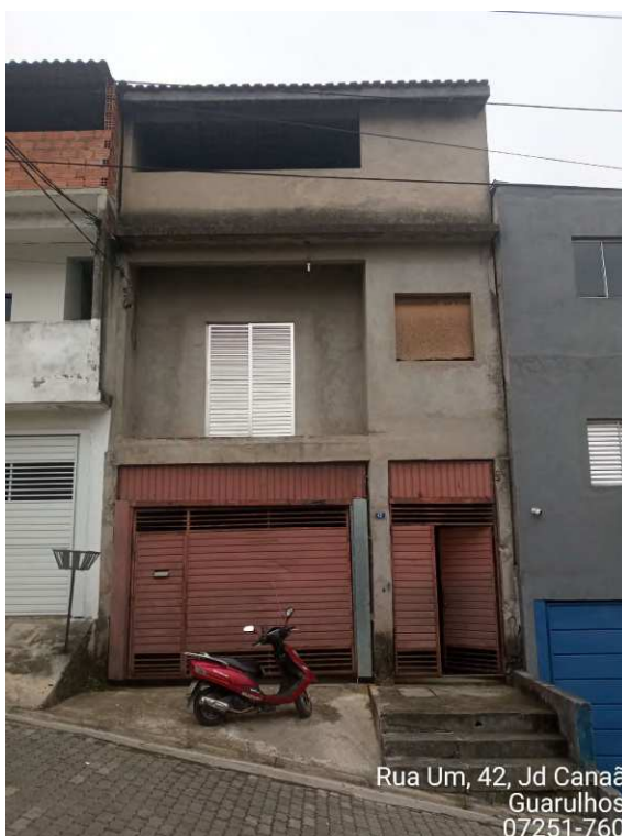
FACHADA DO IMÓVEL AVALIANDO.
