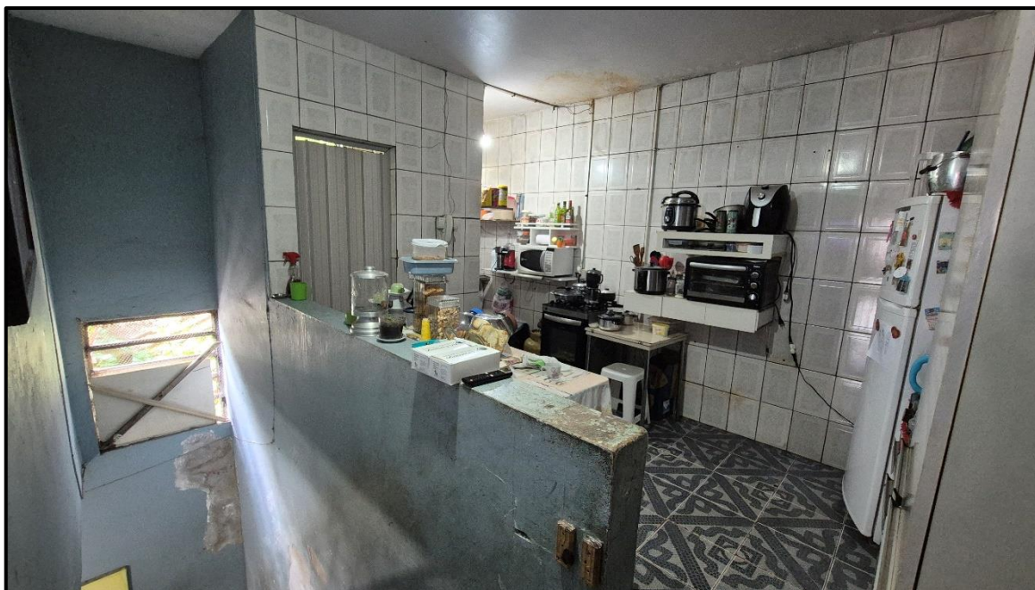
Ilustração 30: 3º pavimento (2º andar) da construção – Cozinha
