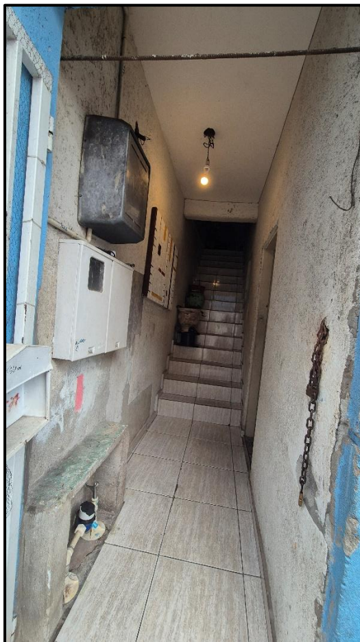
Ilustração 14: 1º pavimento (térreo) da construção – Corredor de acesso aos pavimentos
