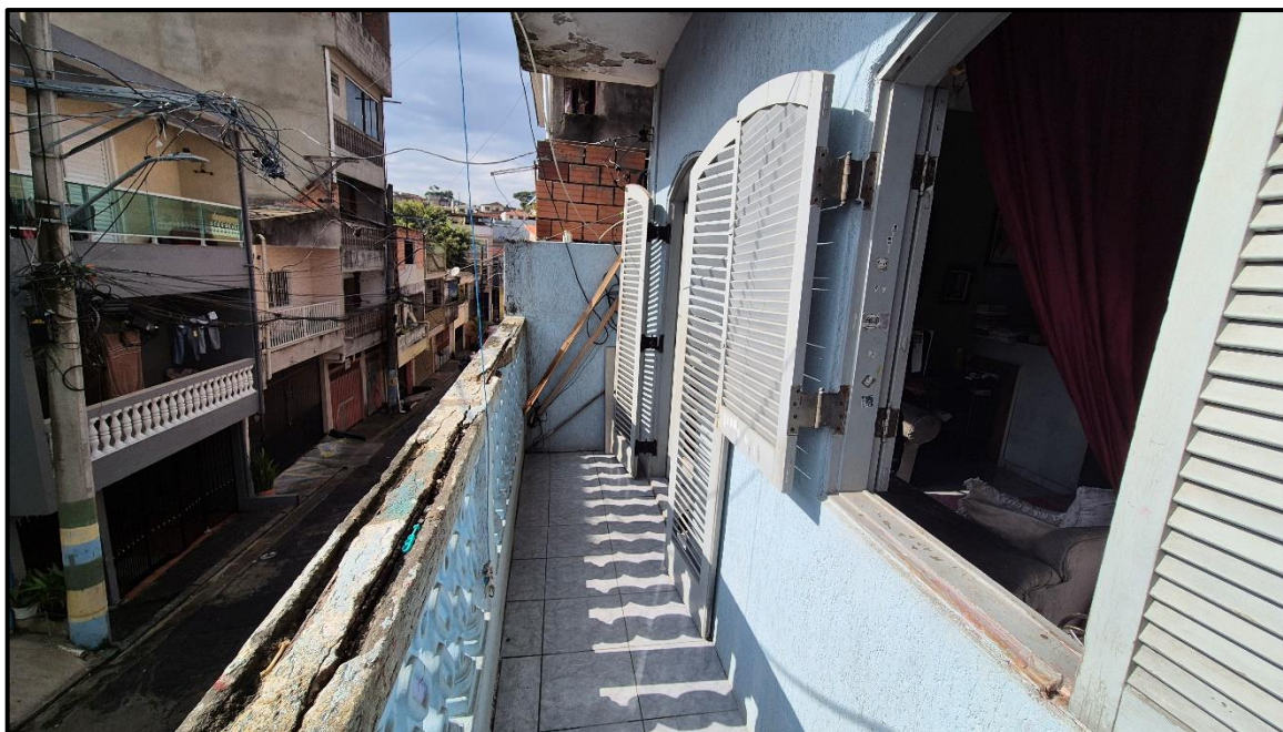
Ilustração 28: 2º pavimento (1º andar) da construção – Varanda
