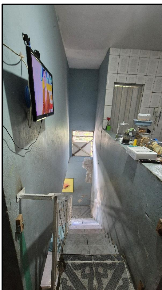
Ilustração 31: 3º pavimento (2º andar) da construção – Escada de acesso ao 2º pavimento
