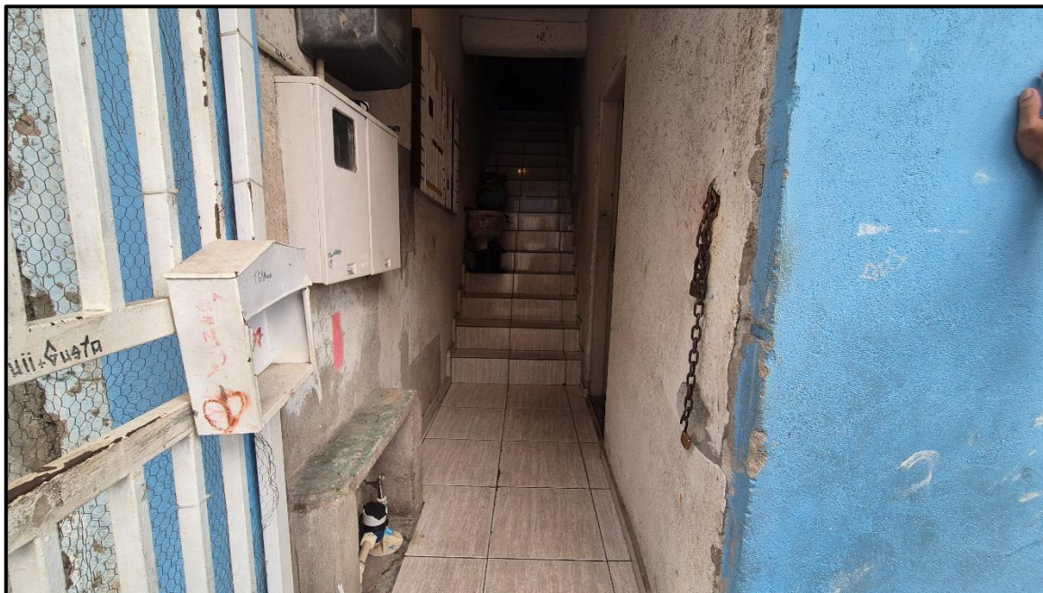
Ilustração 13: 1º pavimento (térreo) da construção – Corredor de acesso aos pavimentos
