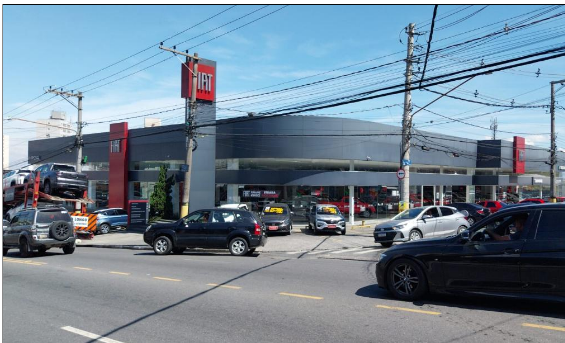
Imagem 1: Fachada do imóvel.
