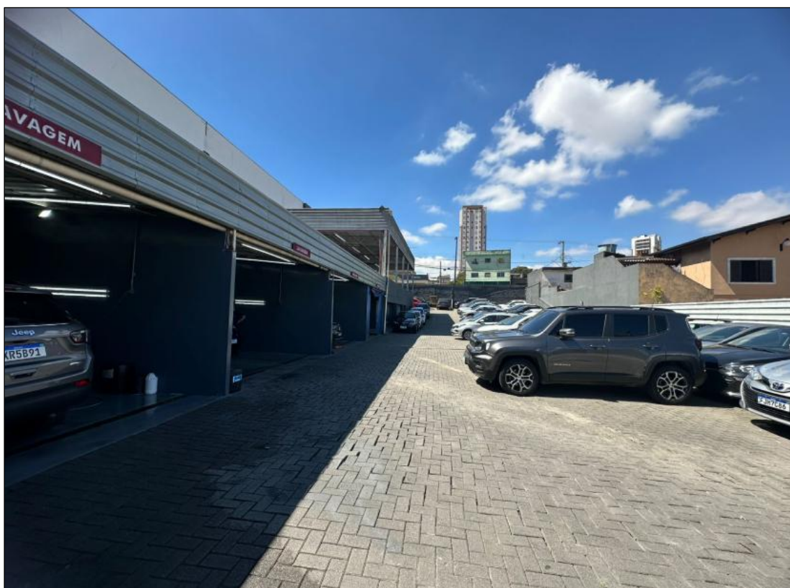
Imagem 31: Interior do imóvel.
