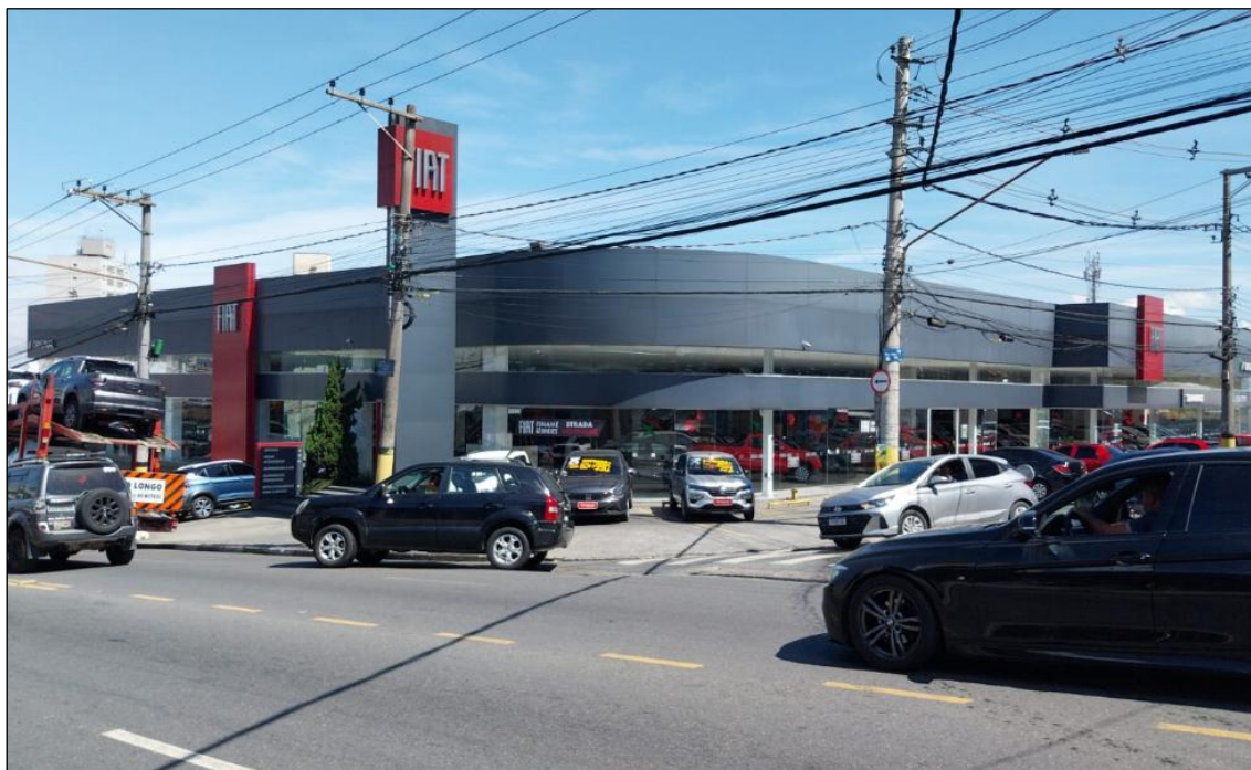
Imagem 15: Fachada do imóvel (vista da Av. Dr. Timóteo Penteado).
