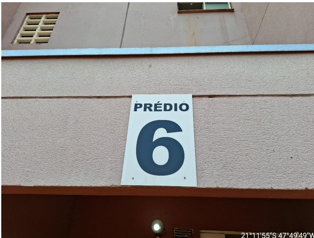
Foto 4 - Vista da placa de identificação do "Prédio 6"
