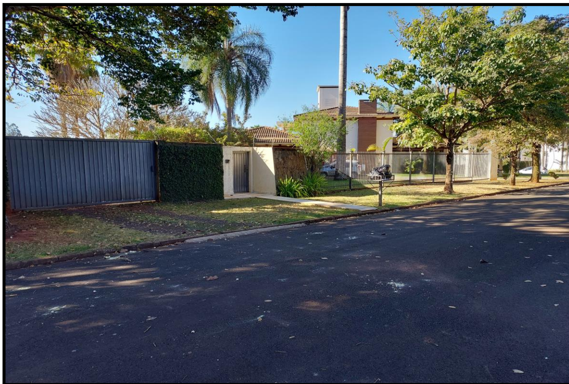
Figura 20: vista do imóvel total (residência) pela rua José Rosa de Oliveira.
