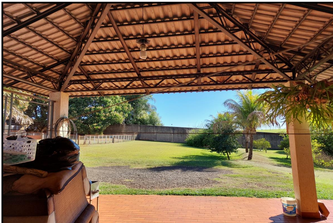
Figura 27: vista da garagem que encontra-se parcialmente construída no imóvel 02
