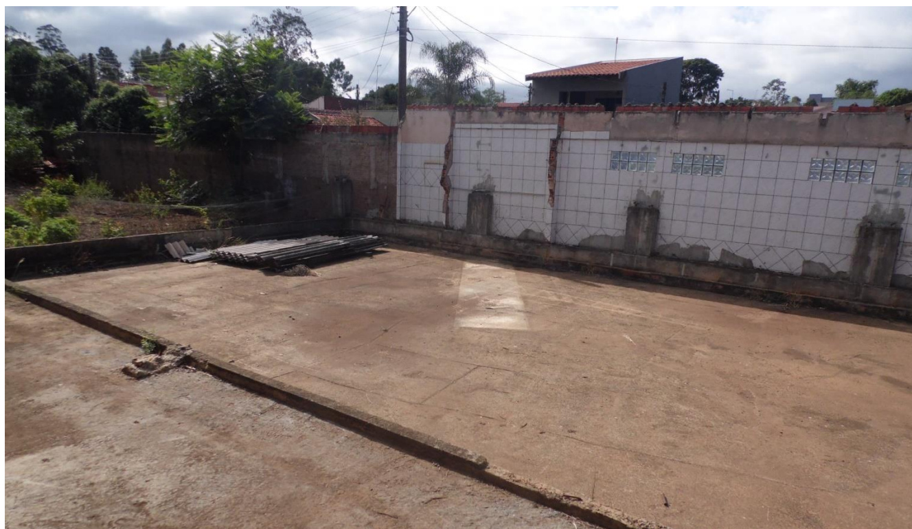
Imagem 02 – O Terreno na parte interna está nivelado aproximadamente 1,00 m acima da Rua das Violetas, que é o nível do piso de concreto do antigo Barracão construído no local.
