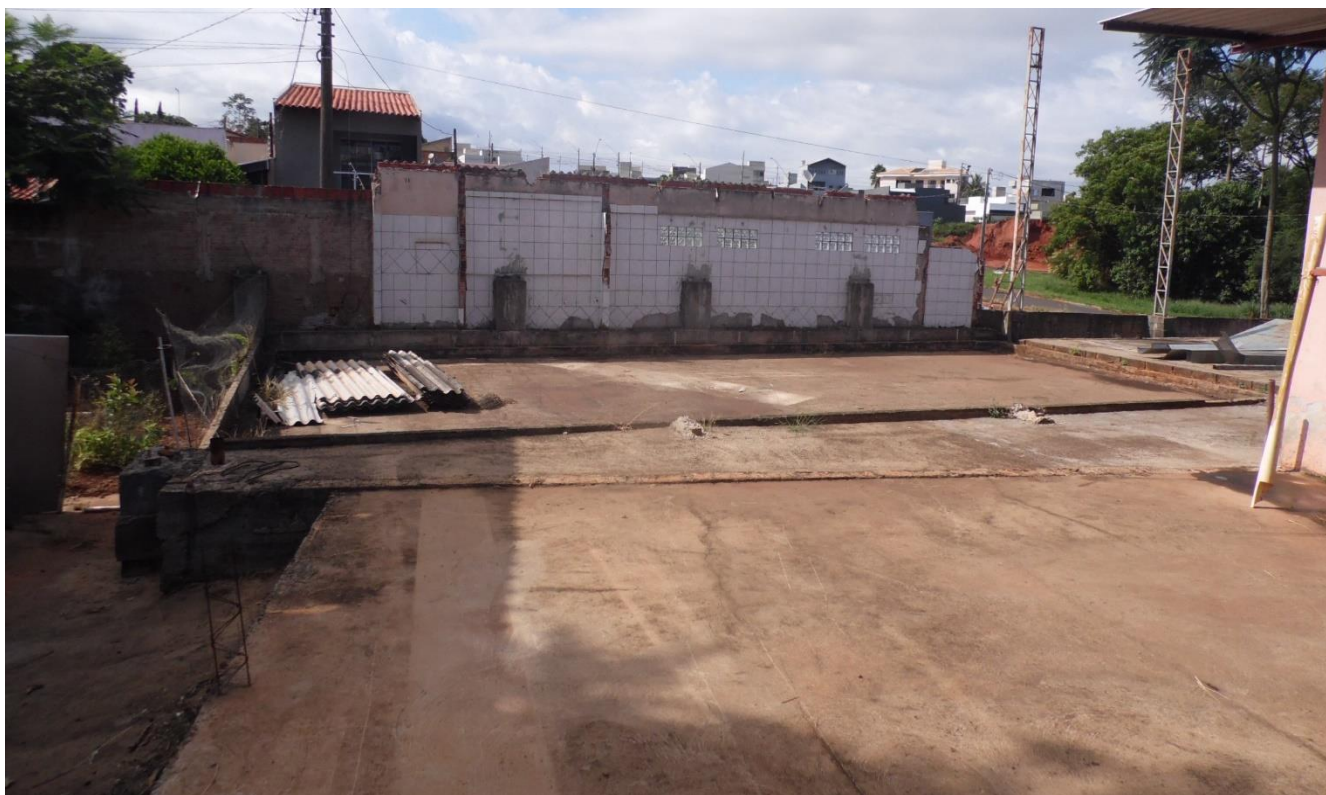
Imagem 03 – O Terreno possui uma área de 260.00 m2 e a Topografia é plana, no entanto, além da alvenaria frontal, o piso de concreto deste antigo Barracão também ficou no local.
