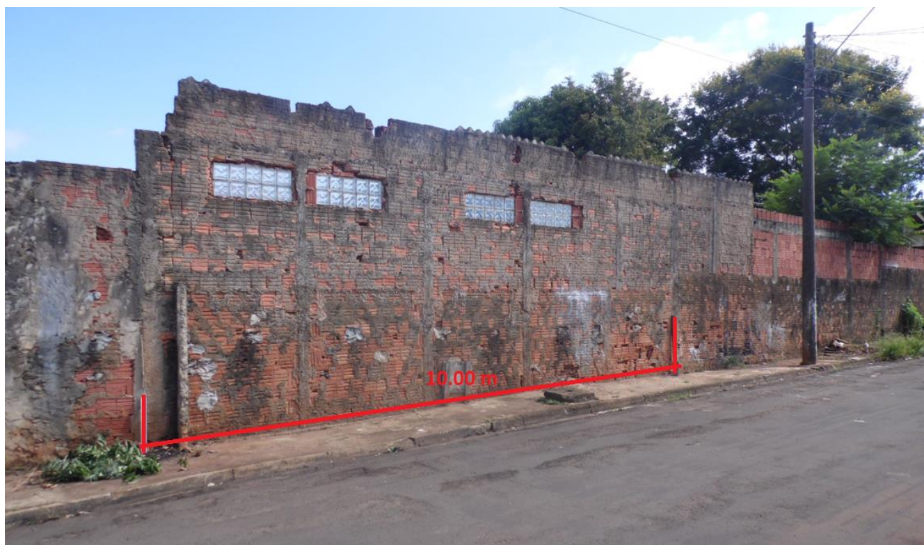
Imagem 01 – Vista frontal do Terreno - Rua das Violetas, s/n, Jardim Santa Amélia, Assis/SP, havia um Barracão construído no local, que foi removido restando somente a alvenaria frontal.
