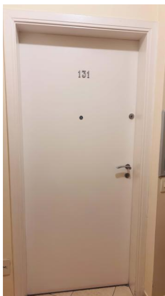
Foto 06 - Entrada do imóvel paradigma
