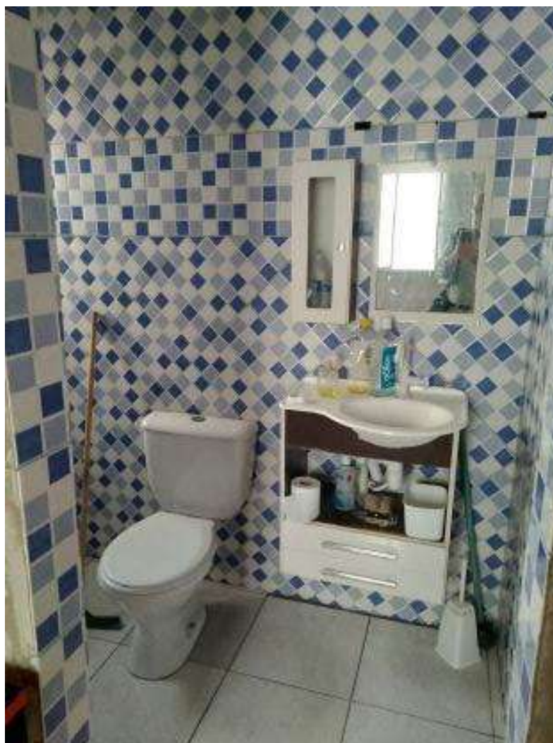
Aspectos do banheiro da suíte.
