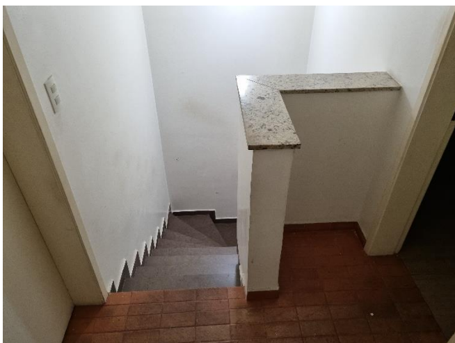
Figura 17 – Escada – Acesso Térreo – Fonte: Autor
