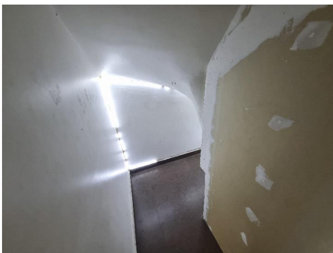
Figura 13 – Área abaixo da escada – Fonte: Autor
