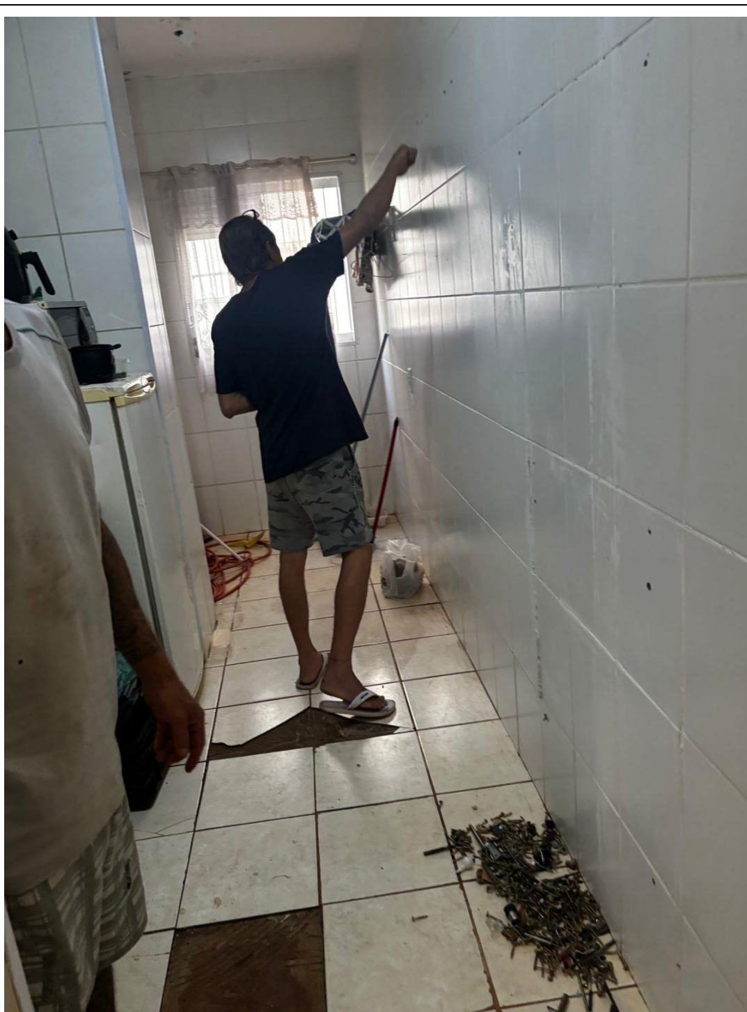
FOTO 05 – Vista da cozinha/ lavadeira do imóvel
