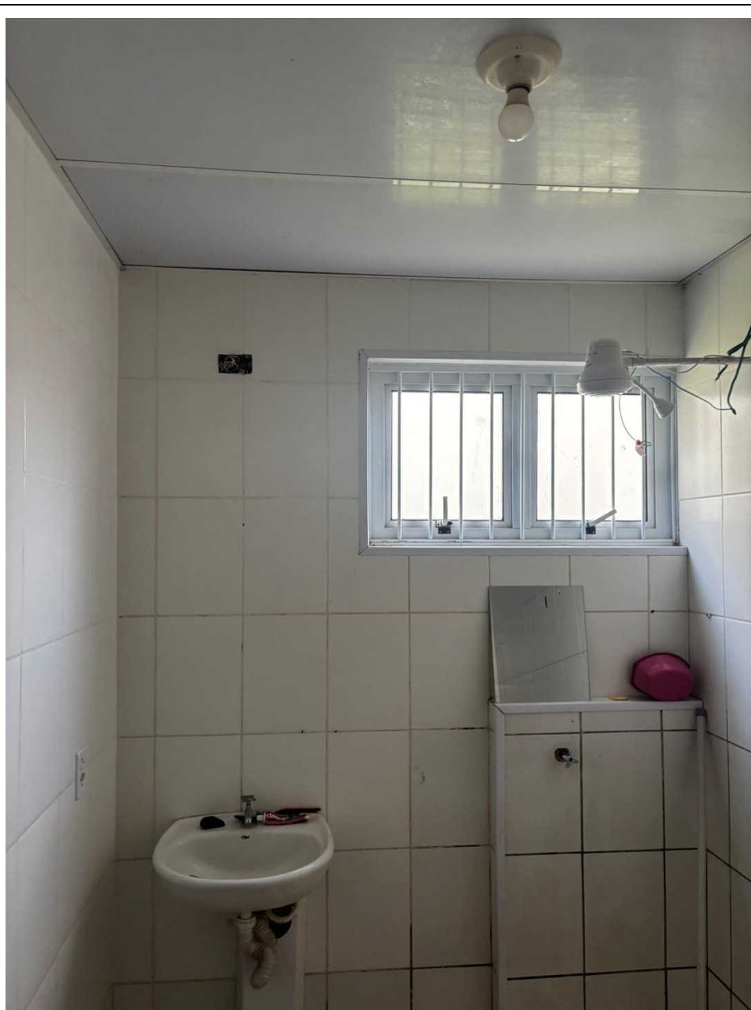
FOTO 08 – Vista do banheiro do imóvel
