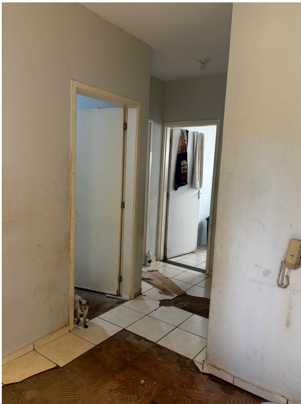
FOTO 04 – Vista do corredor do imóvel
