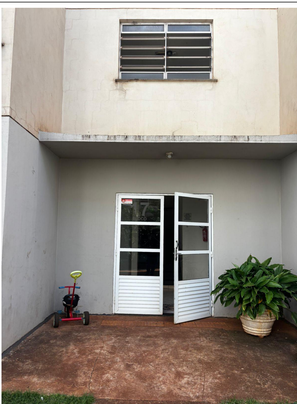
FOTO 02 – Vista da entrada do bloco
