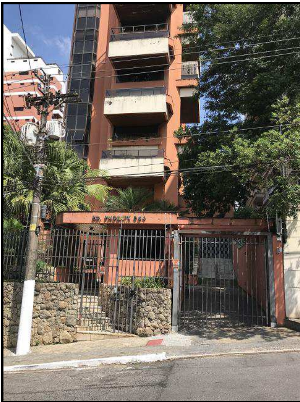
VISTA DA PORTARIA DO CONDOMÍNIO EDIFÍCIO PHOENIX.
