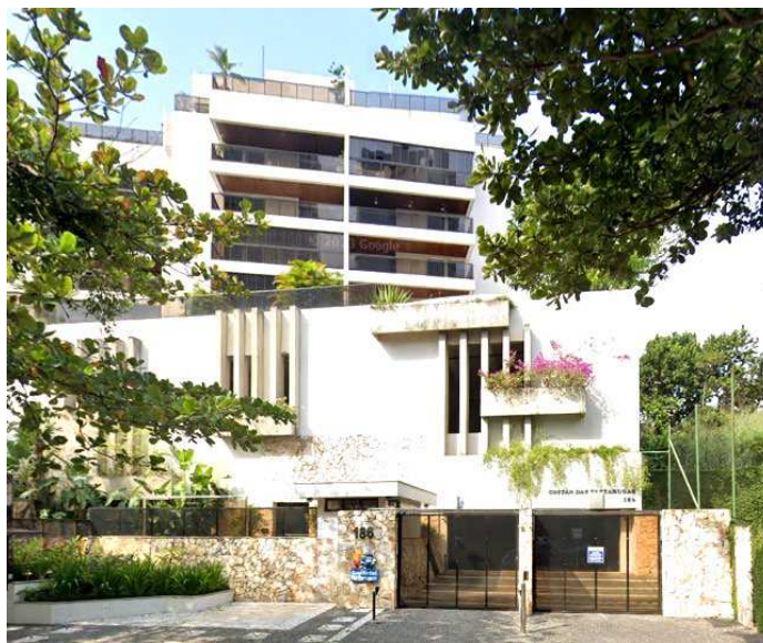
Vista parcial fachada do condomínio
