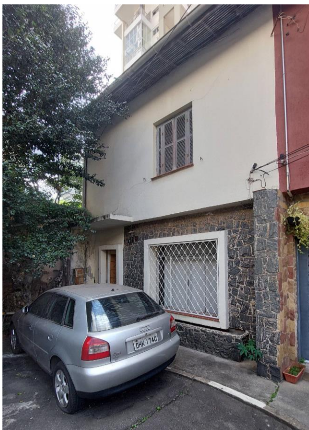
Vista da casa 02, avaliada no presente trabalho.
