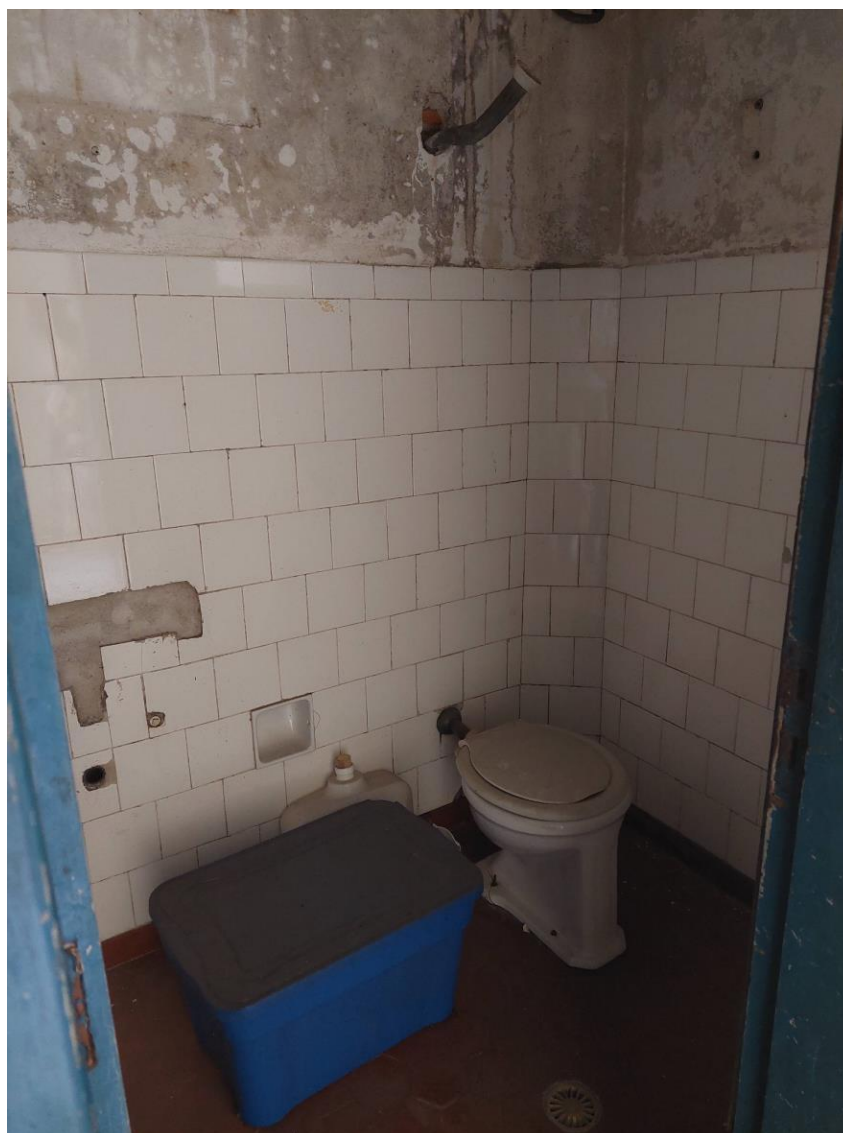
Banheiro da edícula.
