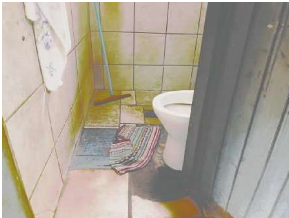
FOTO 7 Banheiro do corpo principal
