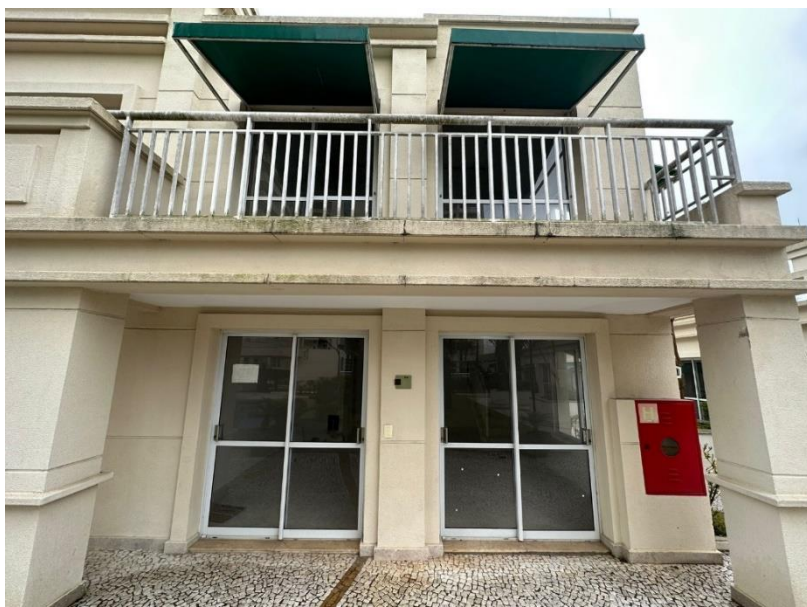
Figura 13 - vista frontal do imóvel avaliando
