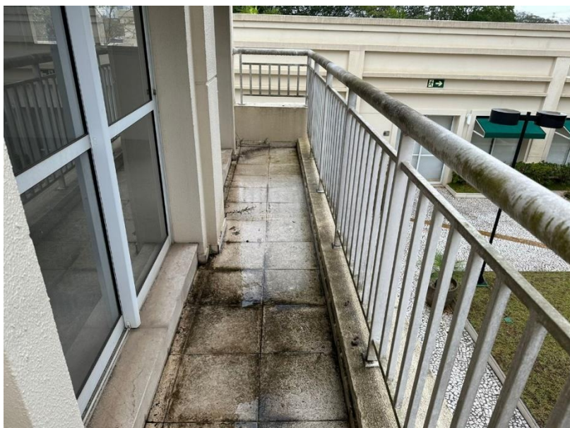
Figura 19 - vista externa do pavimento superior
