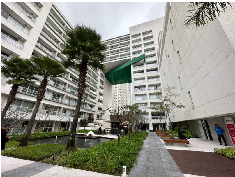
Figura 14 - vista do condomínio e o imóvel avaliando (ao centro)
