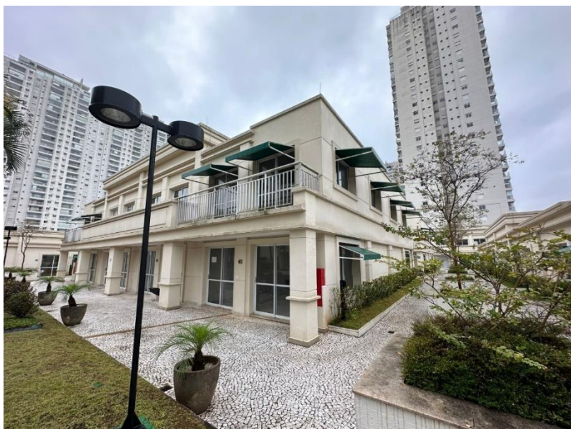
Figura 15 - vista do imóvel avaliando
