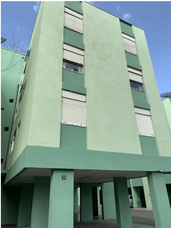
FOTO 4: Vista da Fachada do edifício
