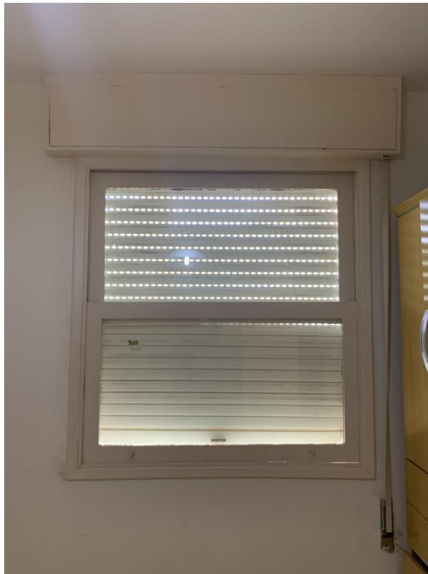
FOTOS 17 E 18: Dormitório 1, com a foto a direita mais aproximada do caixilho tipo guilhotina com persiana de enrolar.
