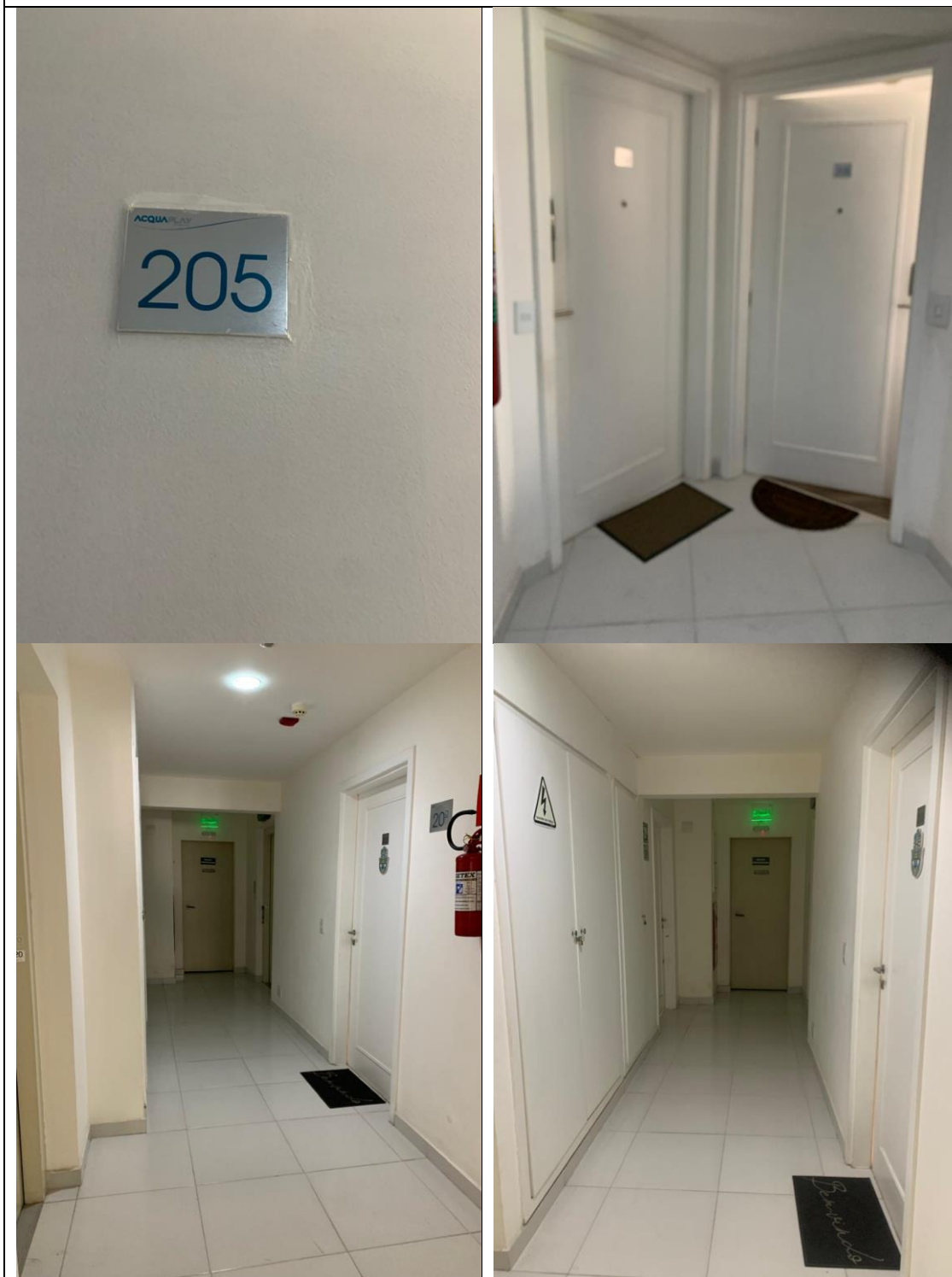
HALL DE CIRCULAÇÃO DO APARTAMENTO Nº 205 TORRE "A" EDIFÍCIO ILHA PORCHAT
